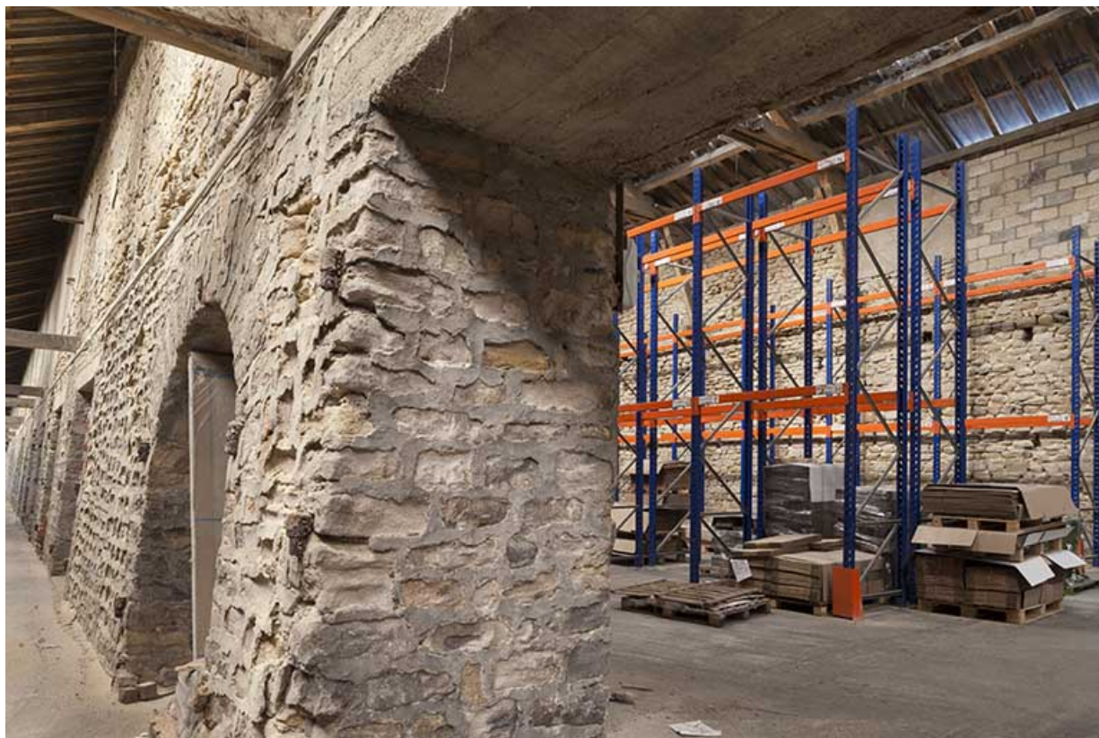
Mur séparant le quai de l'atelier (ouvertures modifiées).
