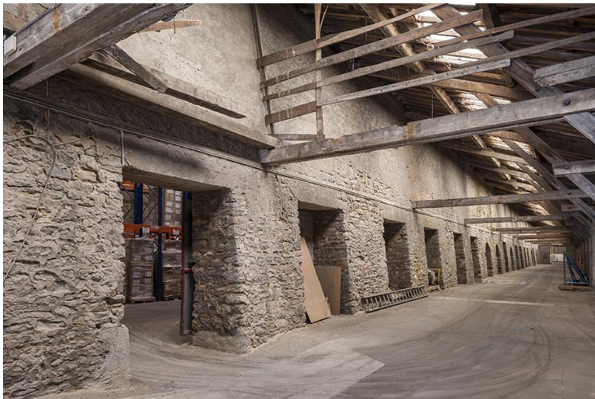
Atelier de fabrication (berne) : ancien quai. 25, Geneuille, 20 chemin des Salines
