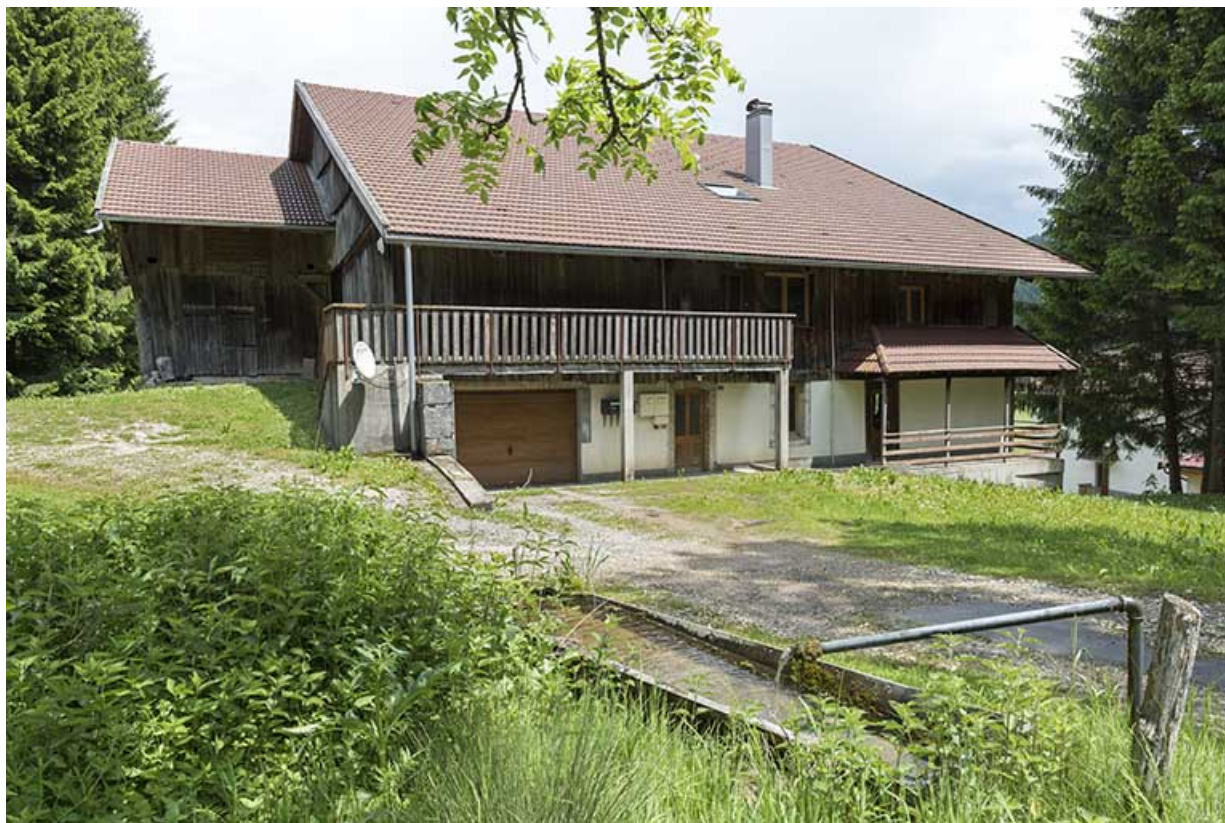
Façade latérale gauche, de trois quarts gauche, avec la fontaine.
