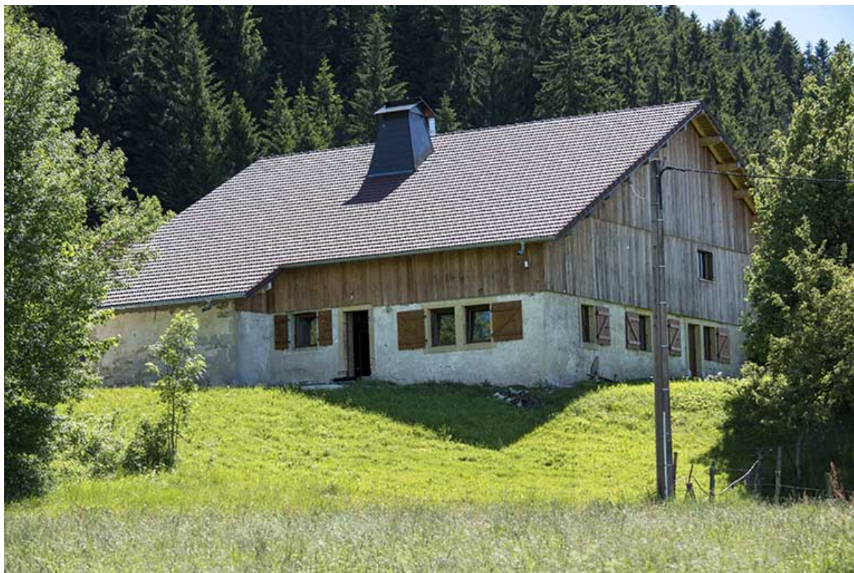
Façades postérieure et latérale droite.
