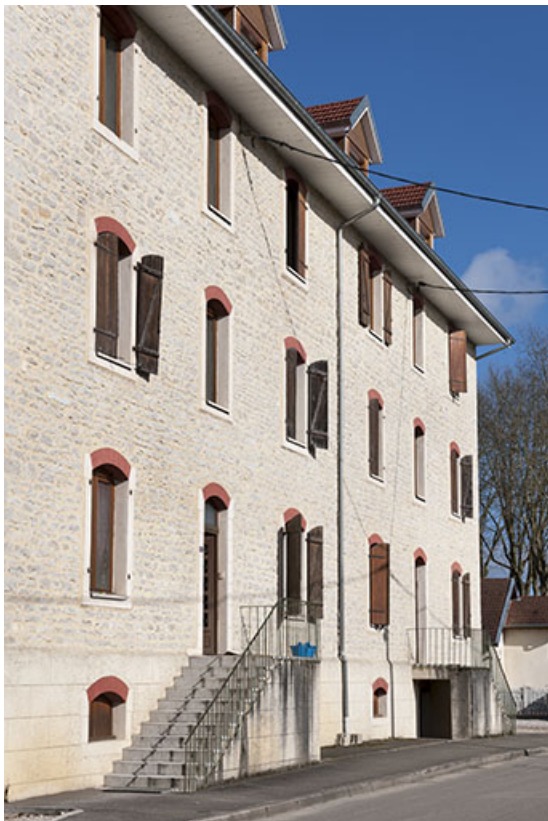
Immeuble de logements. Façade antérieure vue de trois quarts.
