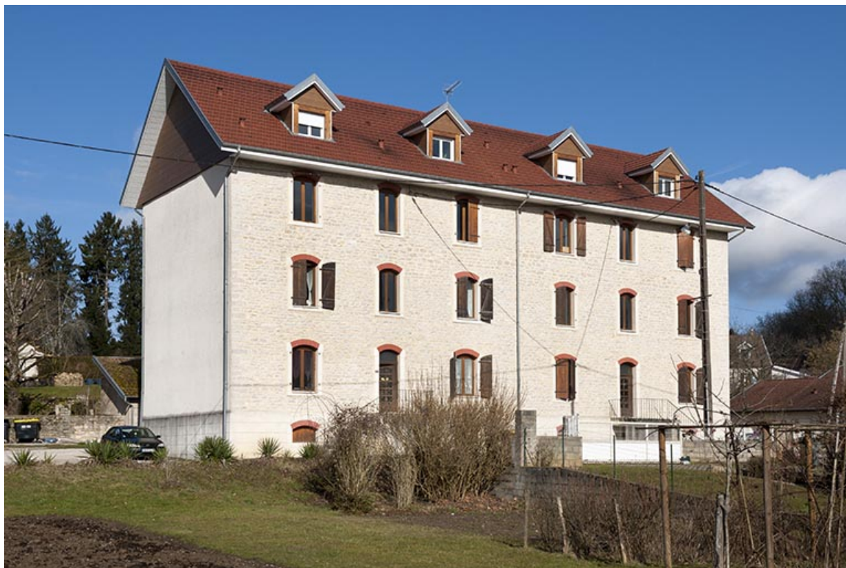
Immeuble de logements. Vue depuis le sud.
