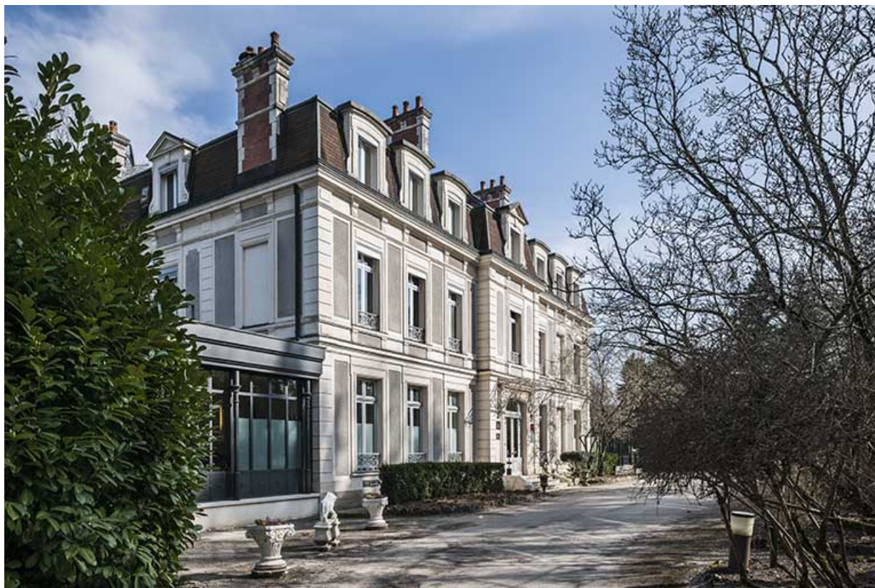
Logement patronal. Vue de trois quarts arrière. 25, Geneuille route des Papetiers
