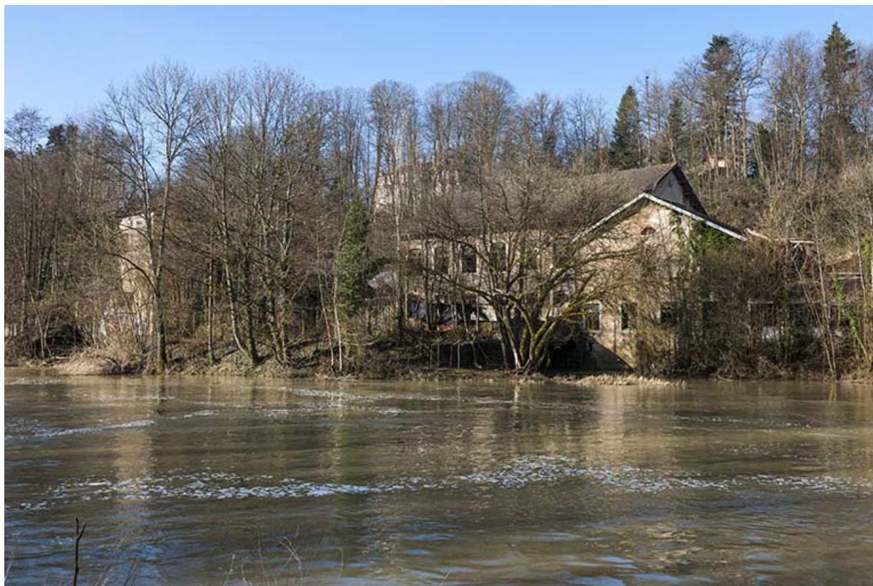
Bâtiments de la papeterie depuis la rive droite.
