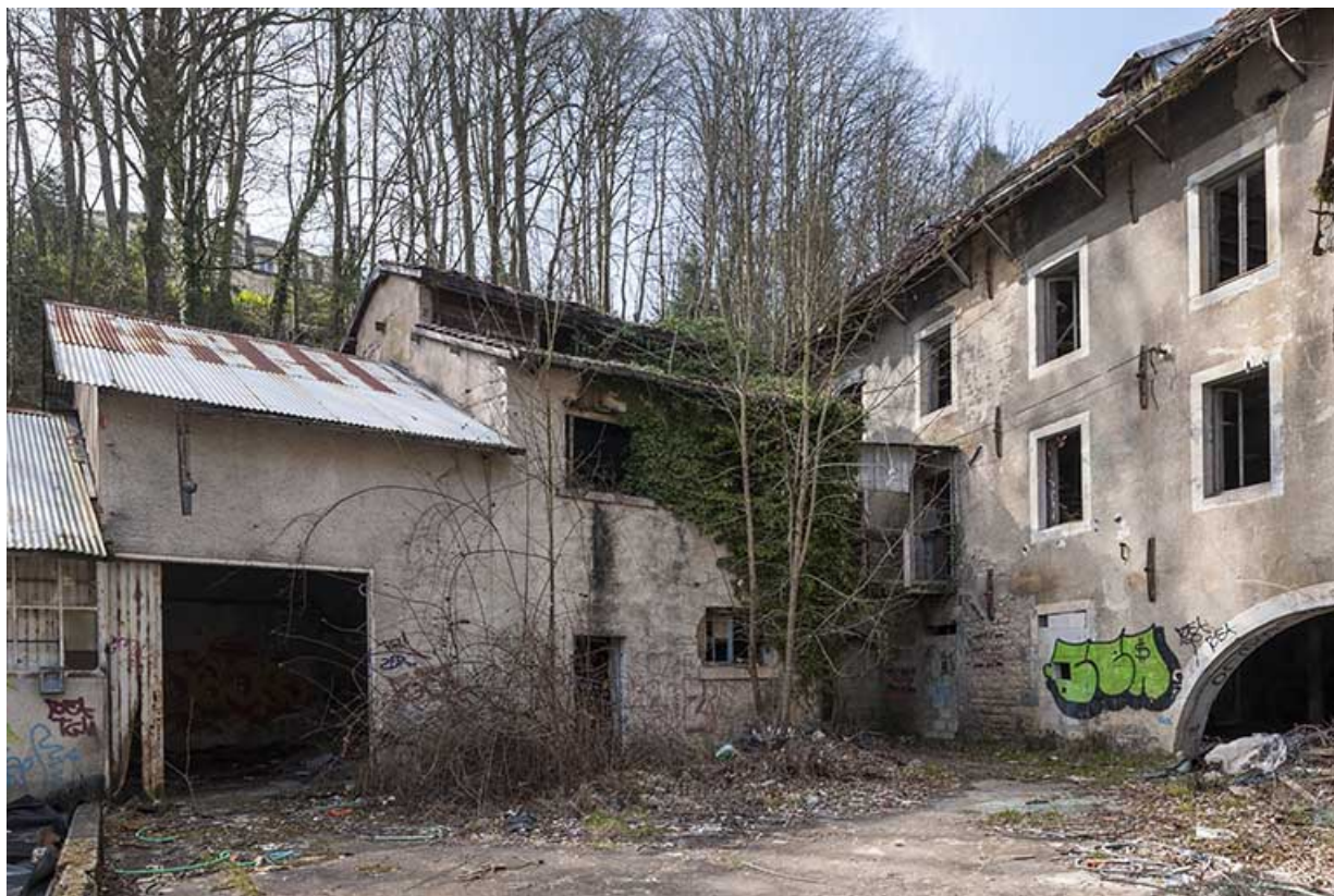
Atelier de blanchiment et bâtiment d'entrée.
