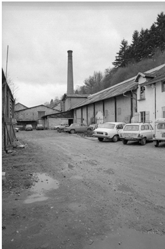
Vue depuis les hangars (T) sur les magasins et le stockage. 25, Geneuille route des Papetiers
