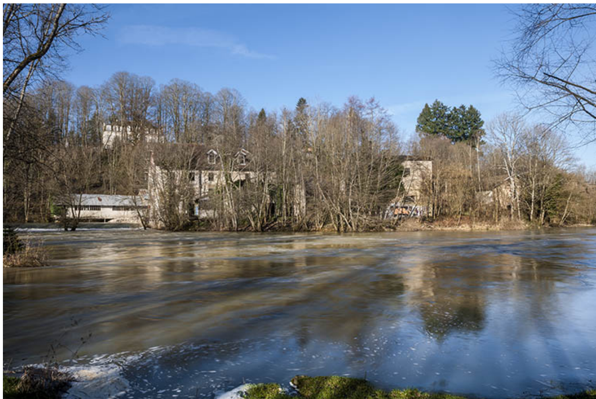
Vue d'ensemble depuis l'est (rive droite). 25, Geneuille route des Papetiers
