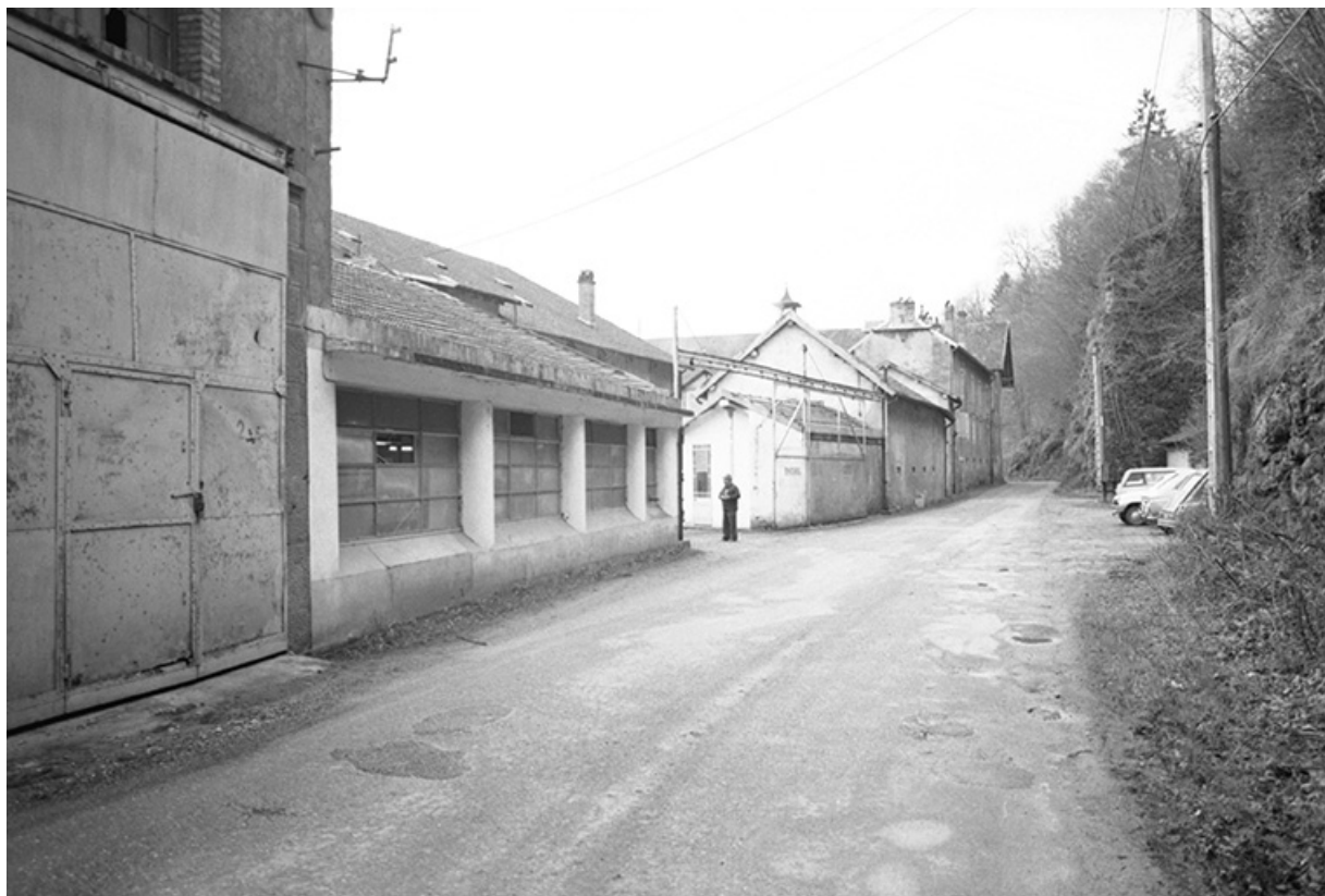
Entrée. Bureaux (L) au 1er étage. 25, Geneuille route des Papetiers
