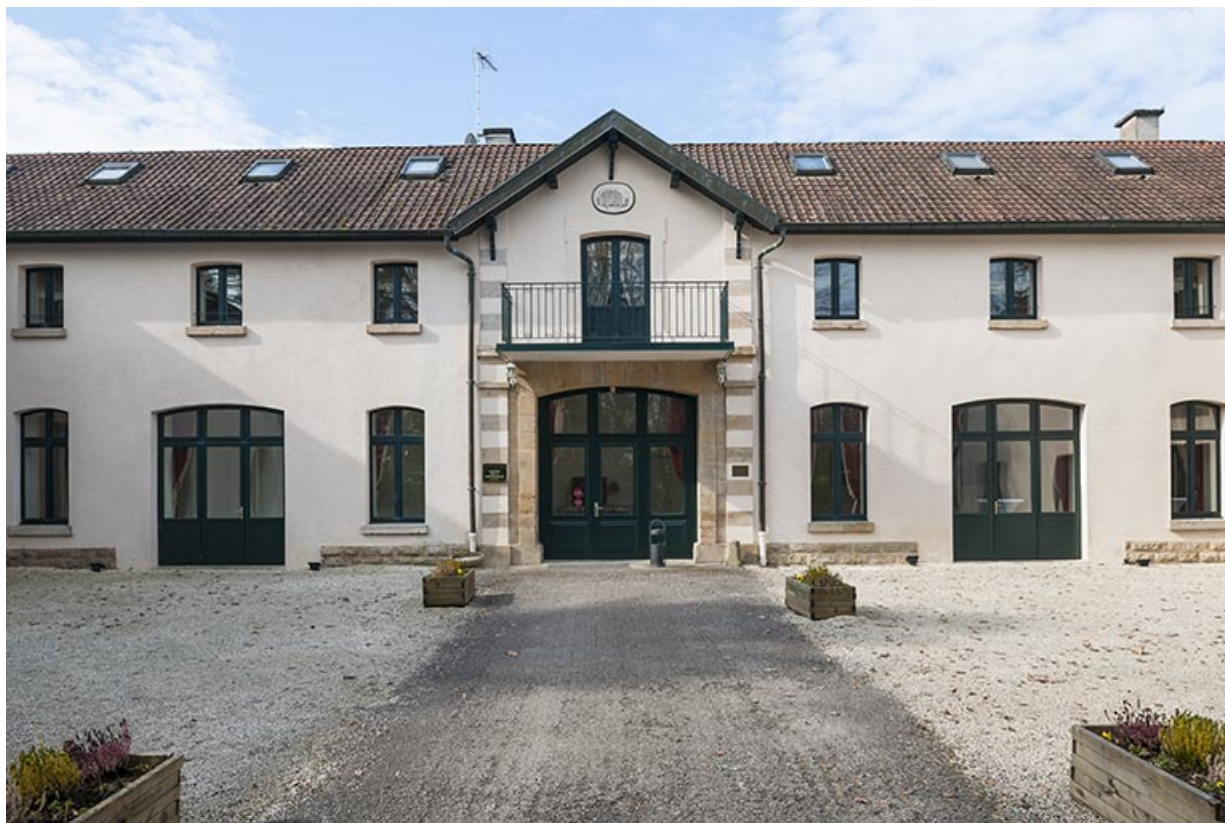
Bâtiment des communs. Travée centrale.
