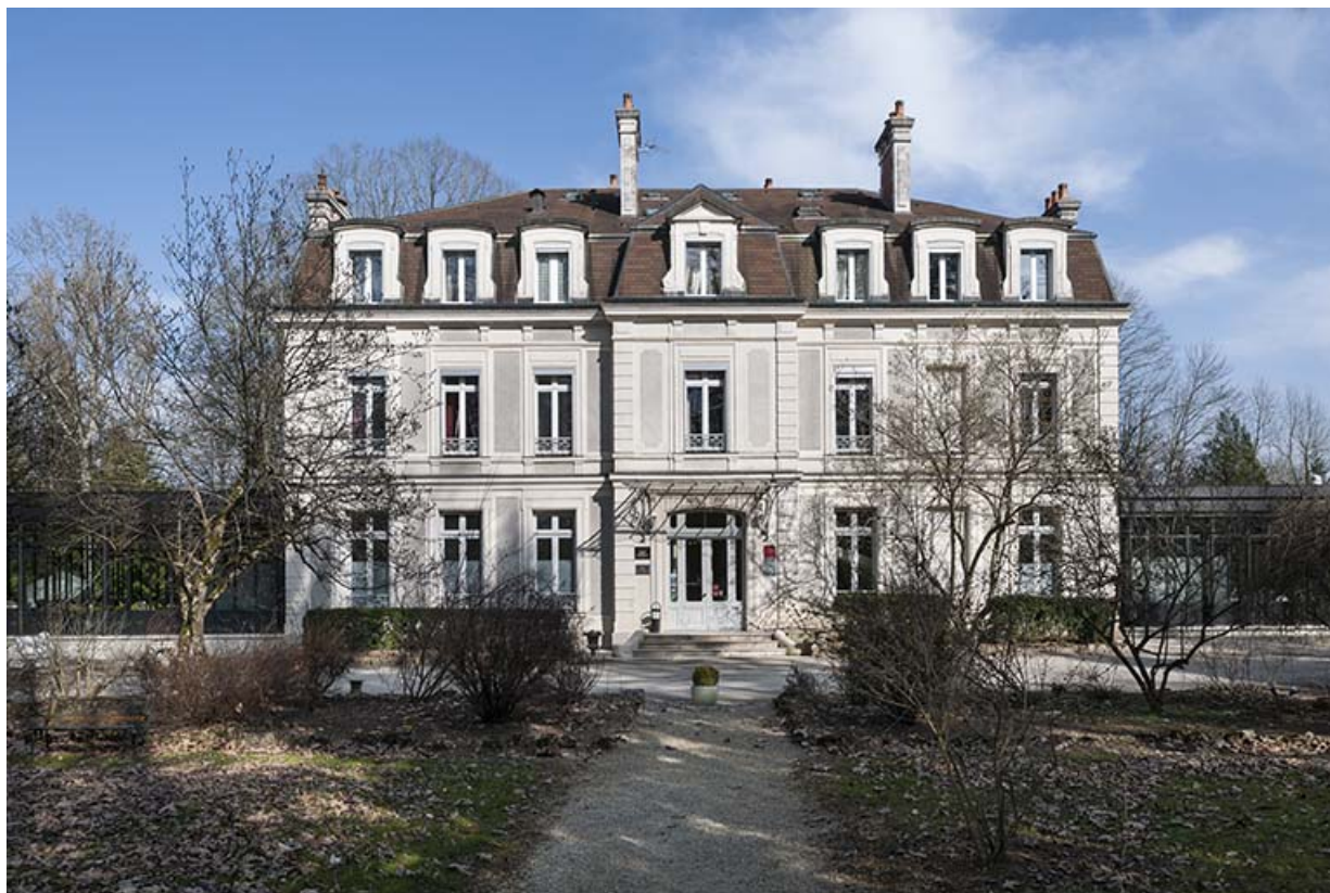
Logement patronal. Façade ouest.
