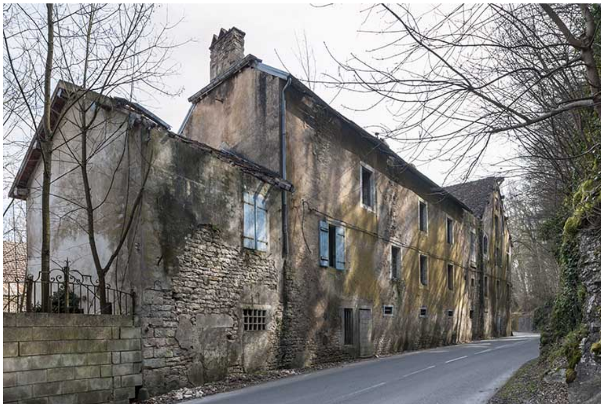
Bâtiment d'entrée longeant la route (logements).
