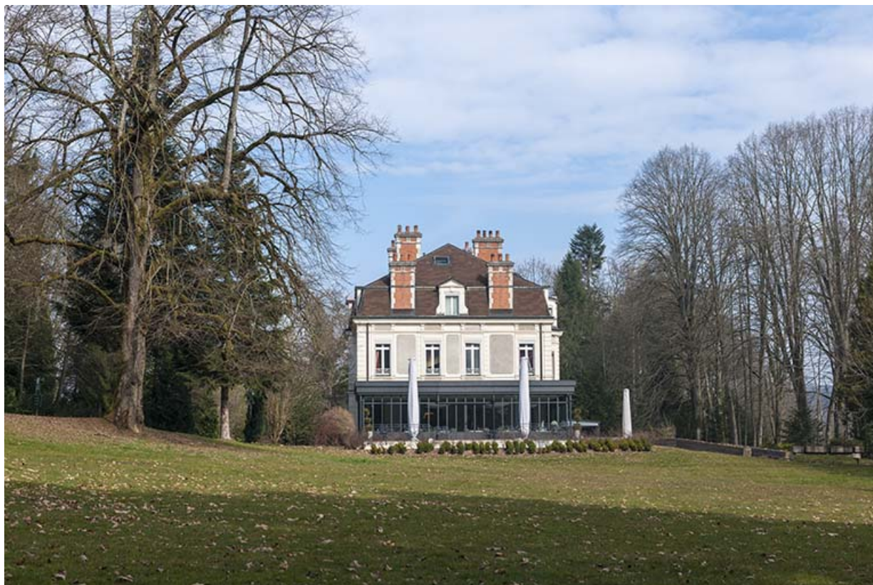
Logement patronal. Façade sud depuis le parc. 25, Geneuille route des Papetiers
