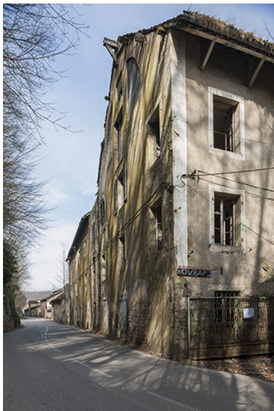
Bâtiment d'entrée (conciergerie et logements) et façade des ateliers le long de la route des Papetiers. 25, Geneuille route des Papetiers
