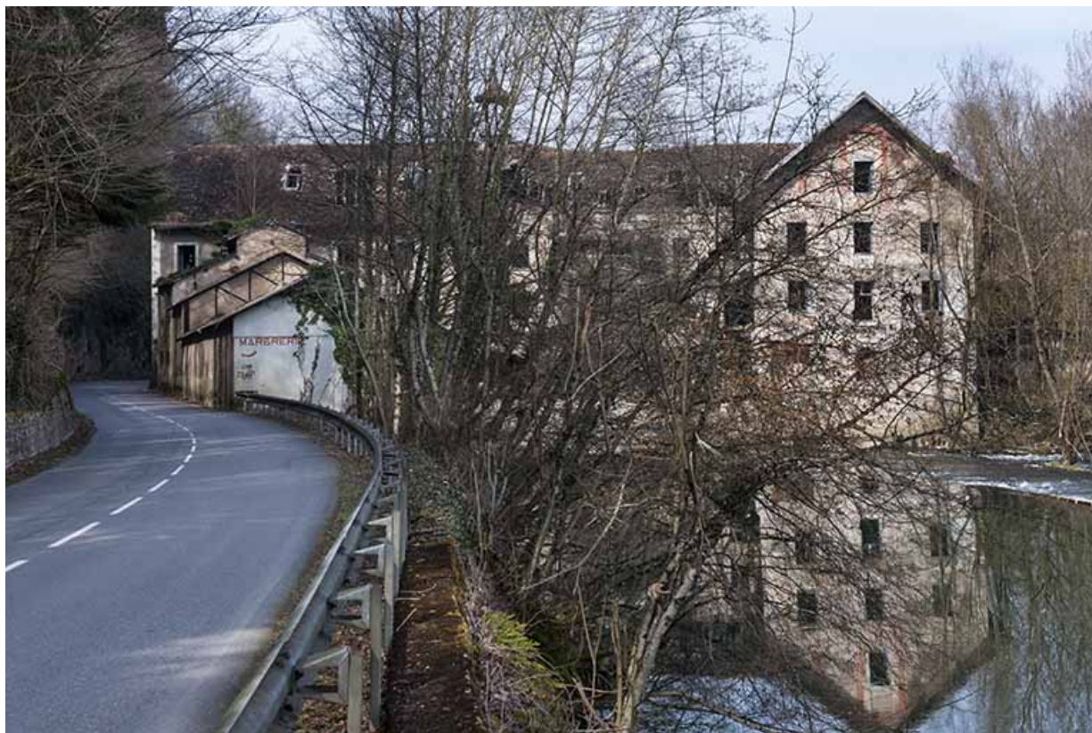
Vue d'ensemble depuis la route des papetiers, au sud.
