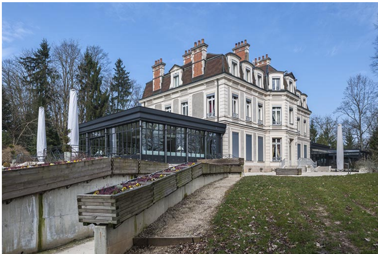
Logement patronal. Vue d'ensemble depuis le sud.
