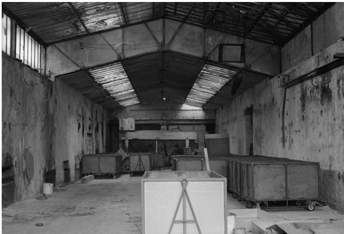
Bâtiment I : machines à papier.
