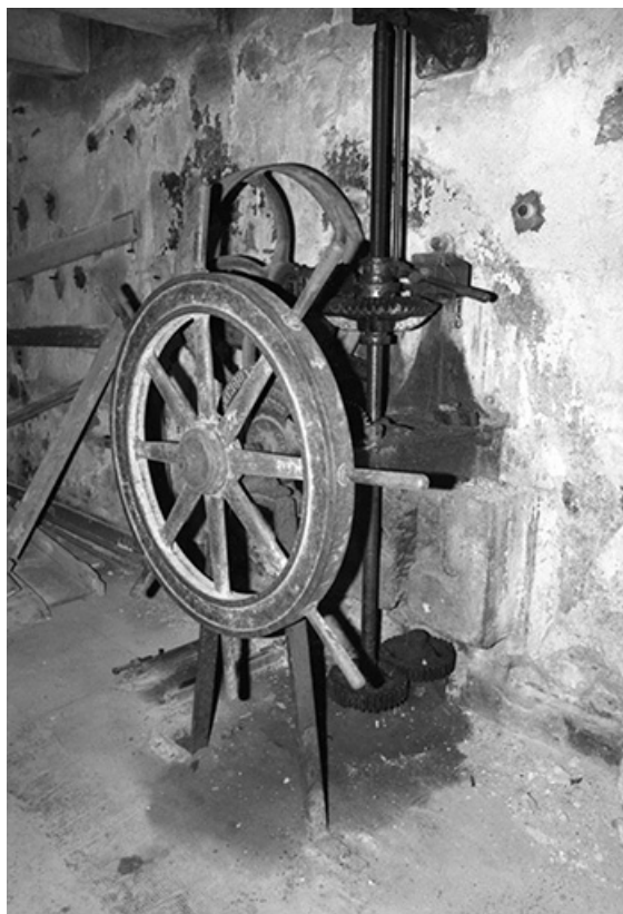
Bâtiment D, 1er étage : mise en route des turbines. 25, Geneuille route des Papetiers
