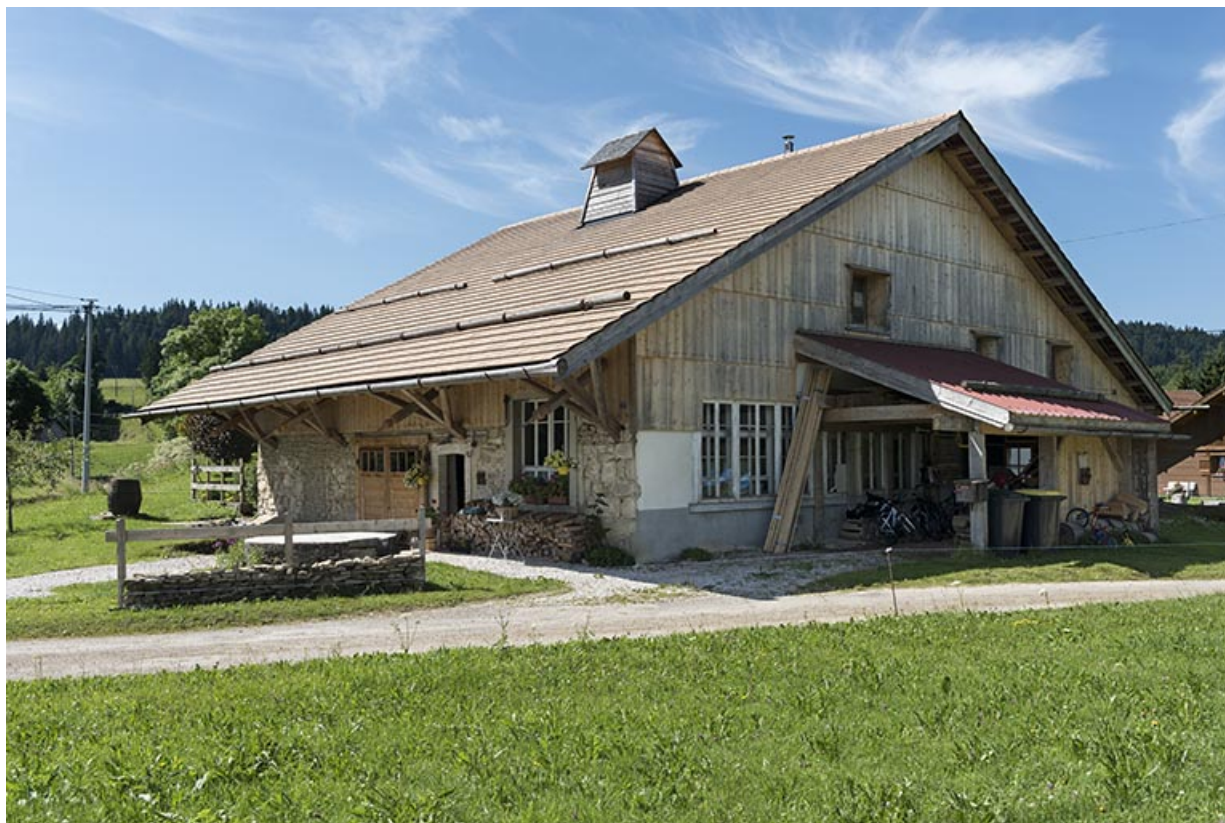
Façades antérieure et latérale droite.
