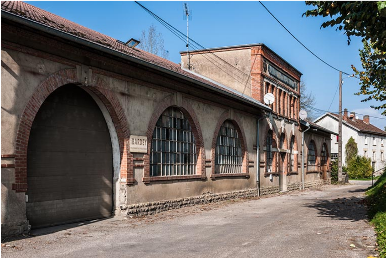
Façade est de l'atelier de la Société française des Métaux ouverts.
