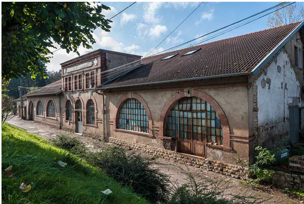
Atelier de fabrication sud. Vue de trois quarts droite.
