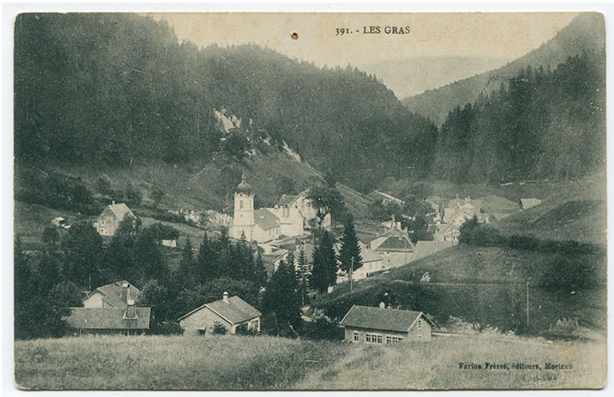
391. - Les Gras [les Epaisses et le quartier de l'église vus du sud], 1er quart 20e siècle [entre 1908 et 1916]. La maison est visible au centre, l'atelier à droite.
