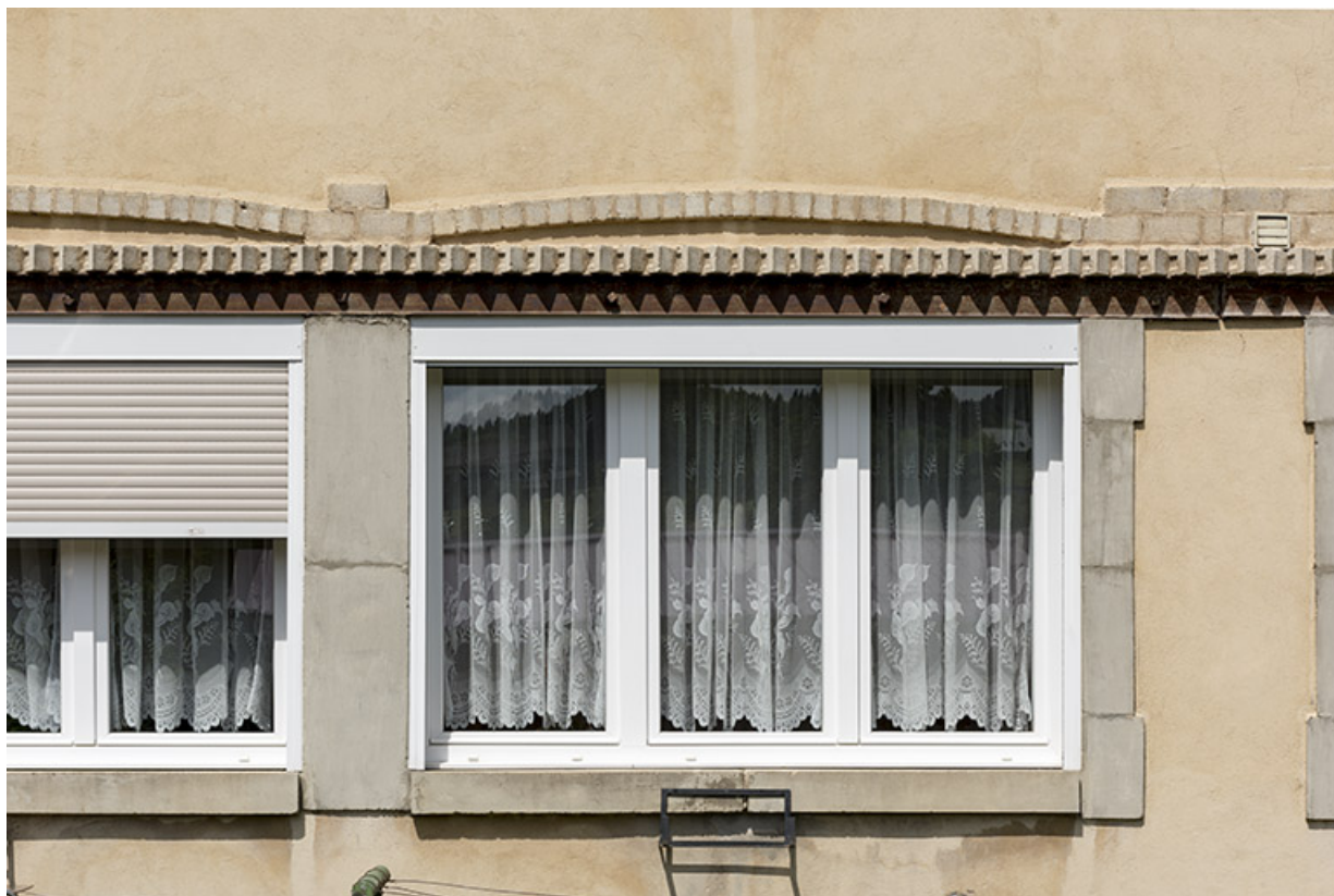
Baie d'atelier au rez-de-chaussée de la façade latérale droite.
