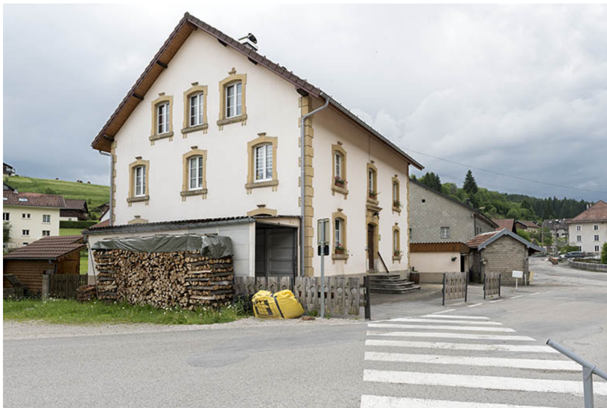
Façades antérieure et latérale gauche.
