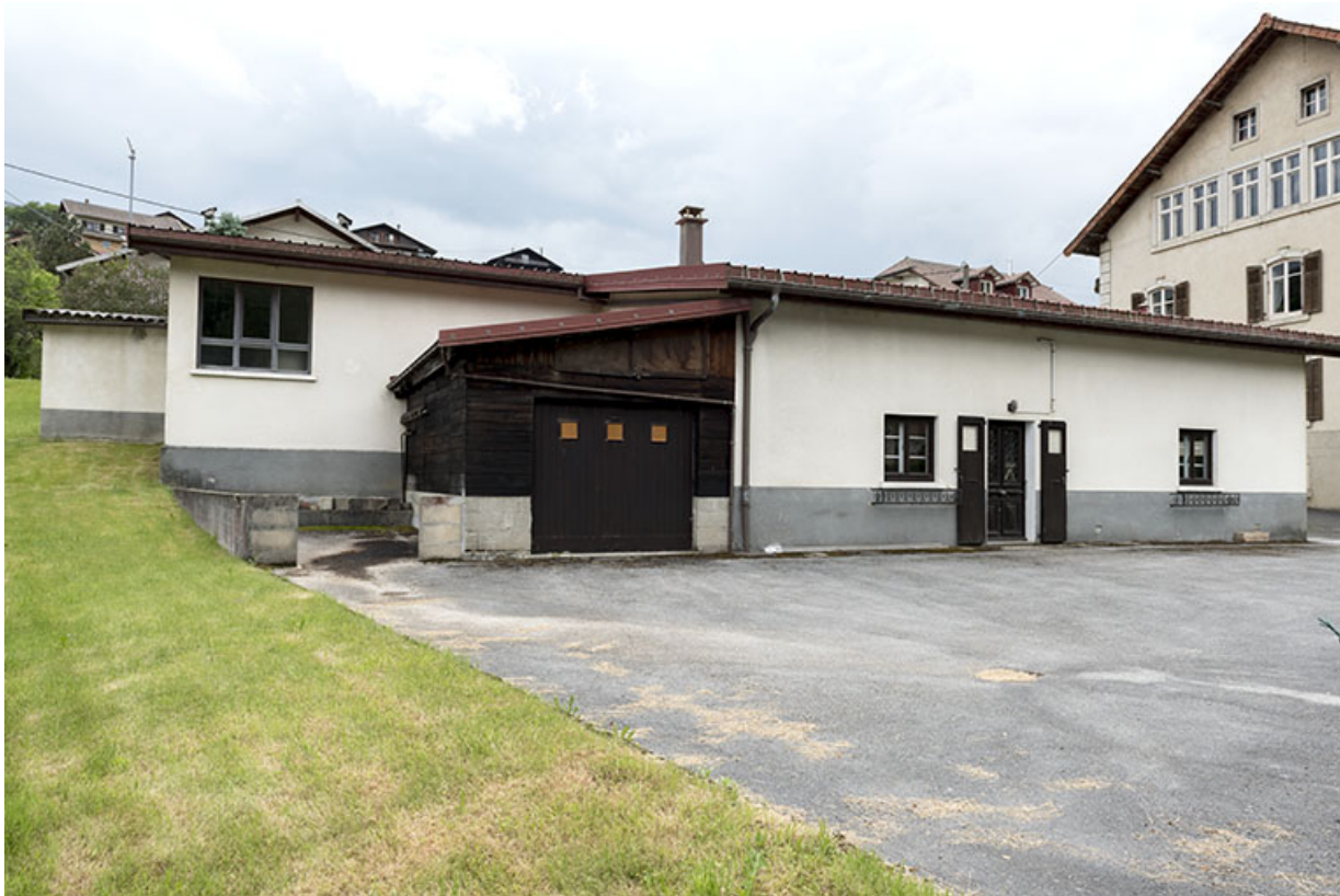
Atelier Moysse Outillage : façade postérieure, de trois quarts gauche. 25, Les Gras, 1-5 rue des Jardins
