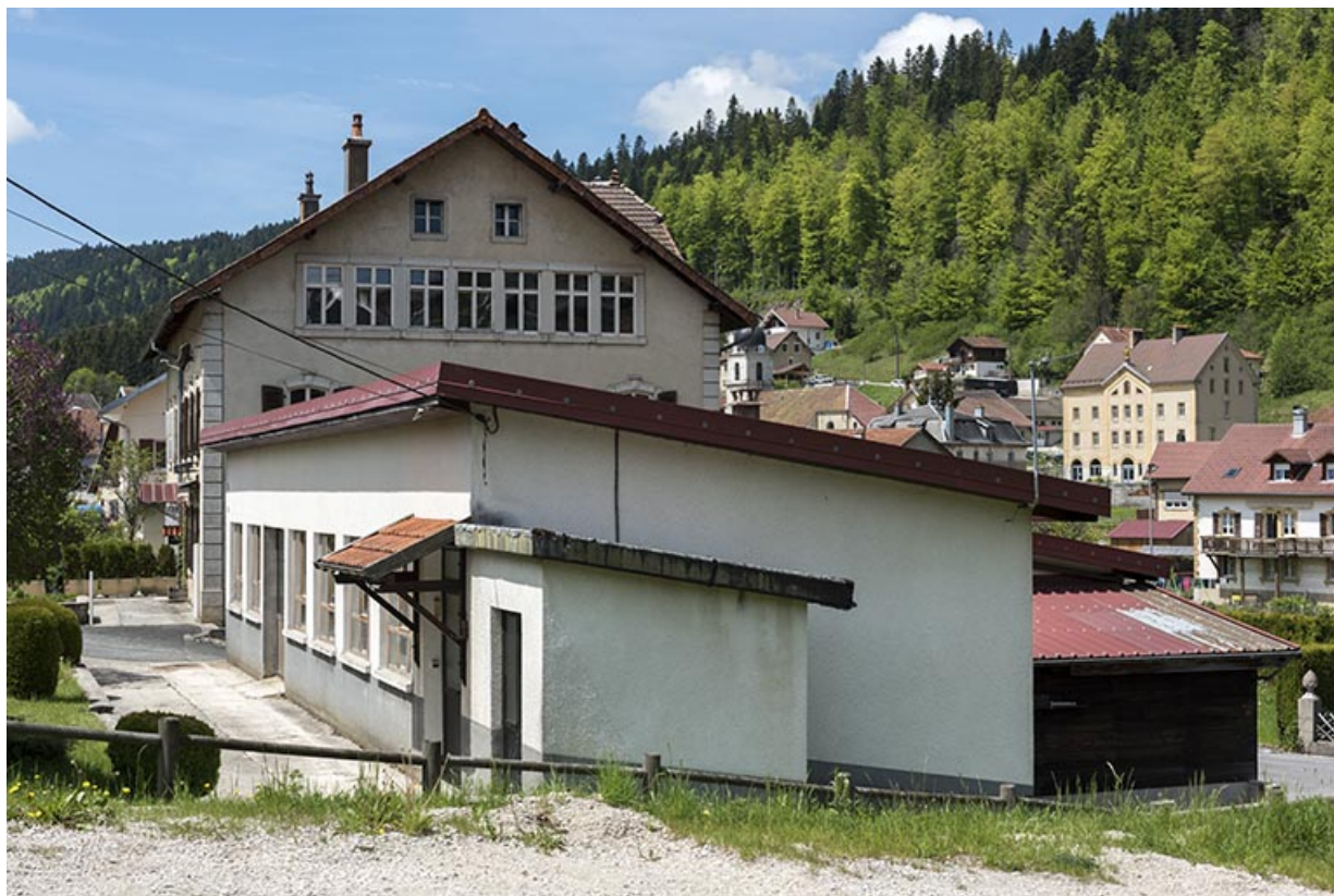
Atelier Moyse Outillage : façades antérieure et latérale droite. 25, Les Gras, 1-5 rue des Jardins
