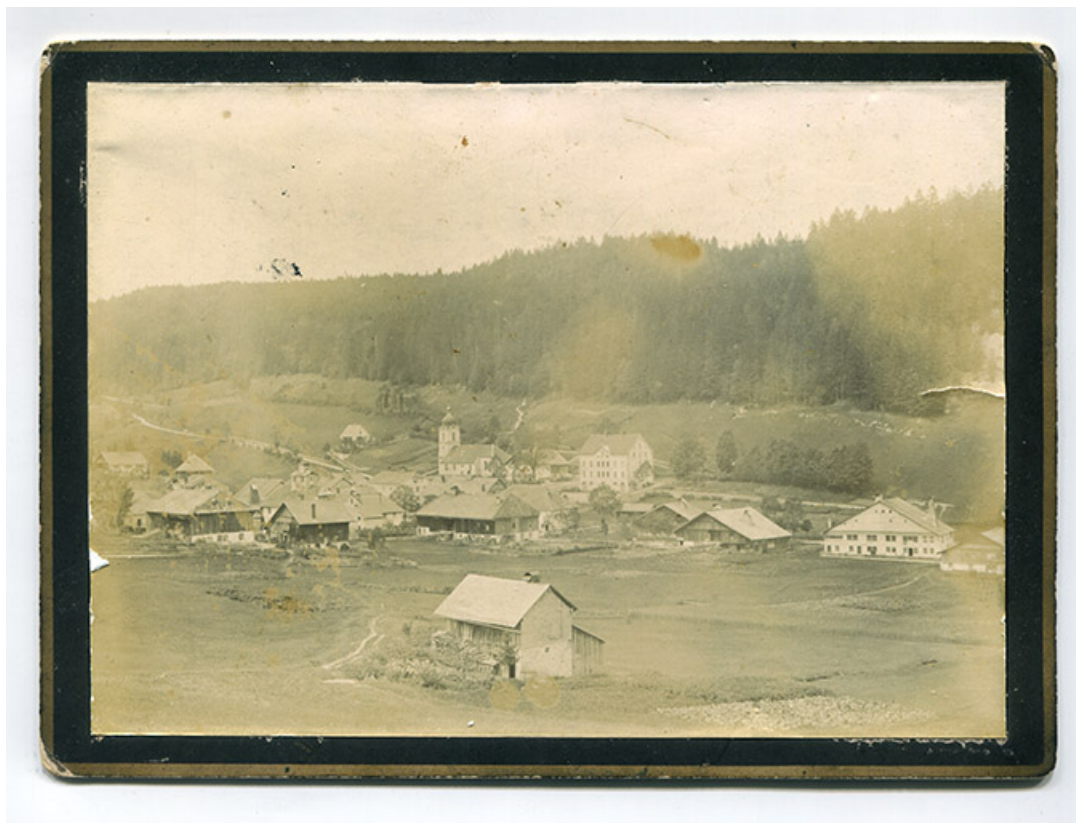
[Vue d'ensemble du village, depuis la route de La Brévine, à l'est], limite 19e siècle 20e siècle [avant 1910]. 25, Les Gras
