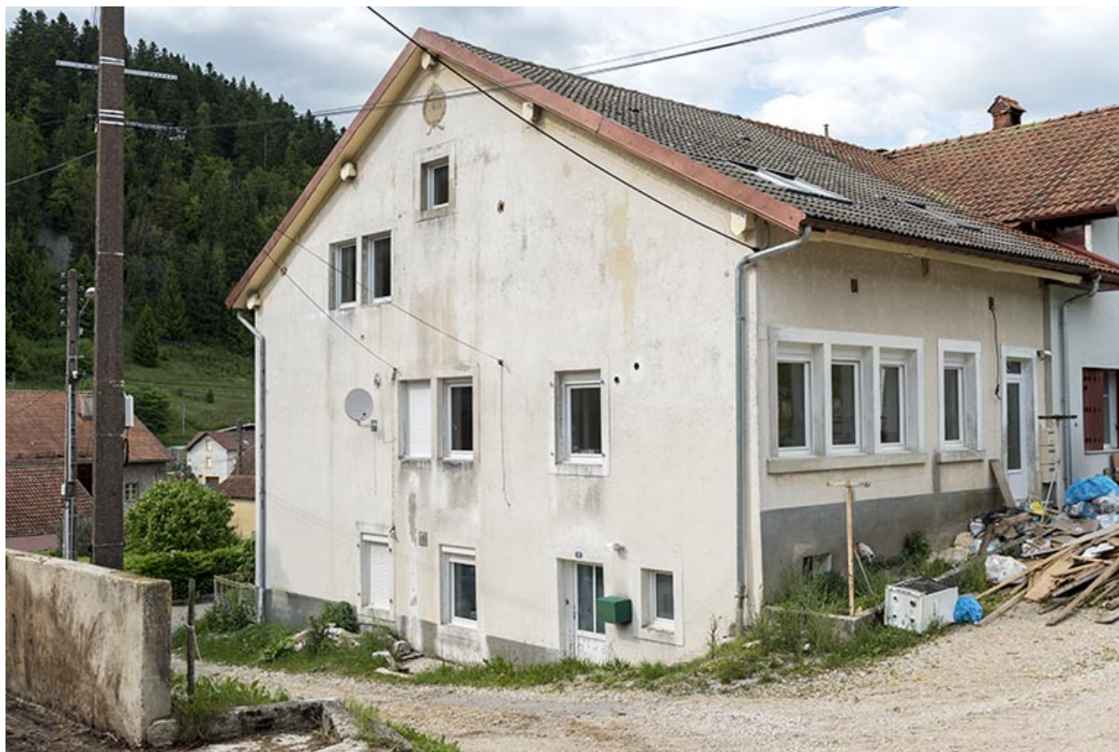
Bâtiment d'origine : façades postérieure et latérale droite.
