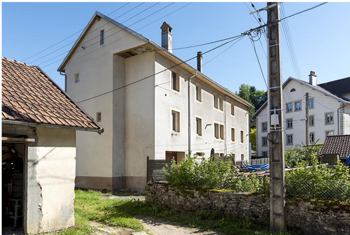
Façades postérieure et latérale droite.
