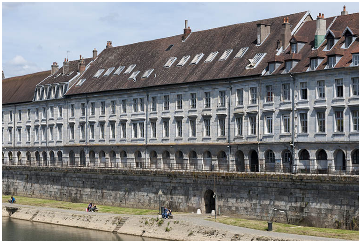
Vue d'ensemble, depuis la rive droite du Doubs en aval.
