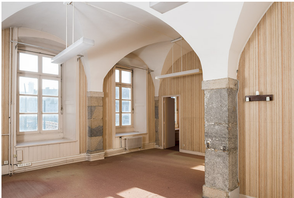
Premier étage, partie droite : pièce voûtée à usage de bureau (administration), côté place. 25, Besançon, 27 rue des Boucheries
