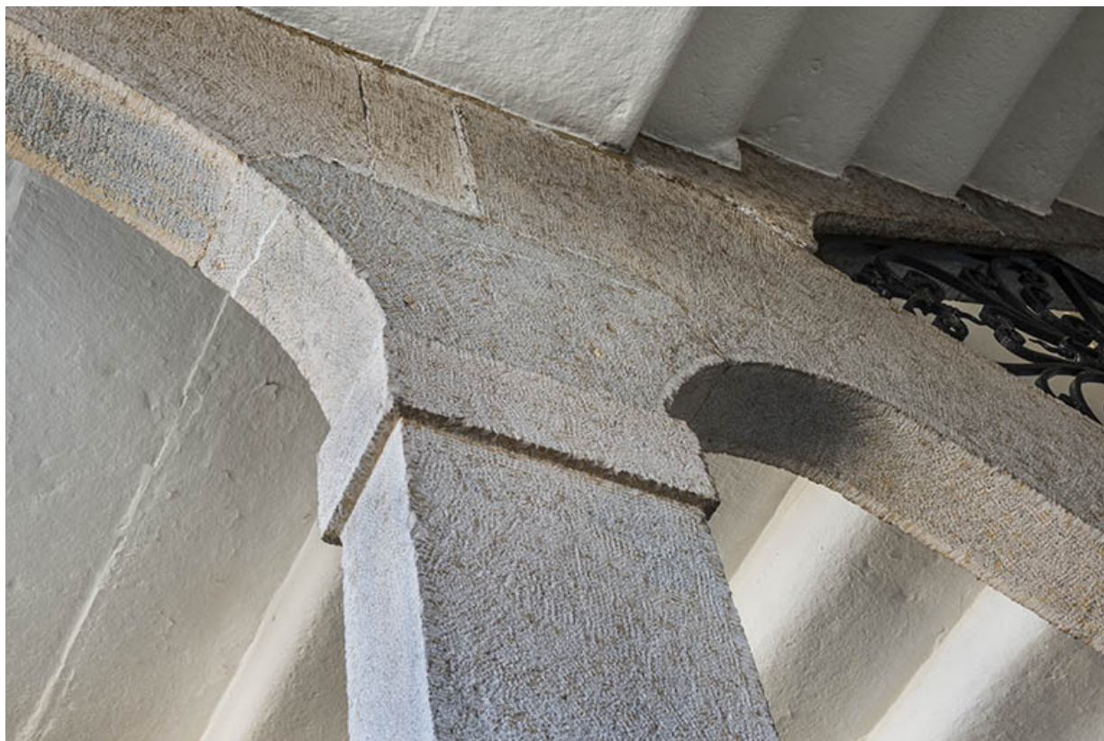
Grand escalier : partie supérieure d'un pilier rectangulaire supportant un limon et un arc.
