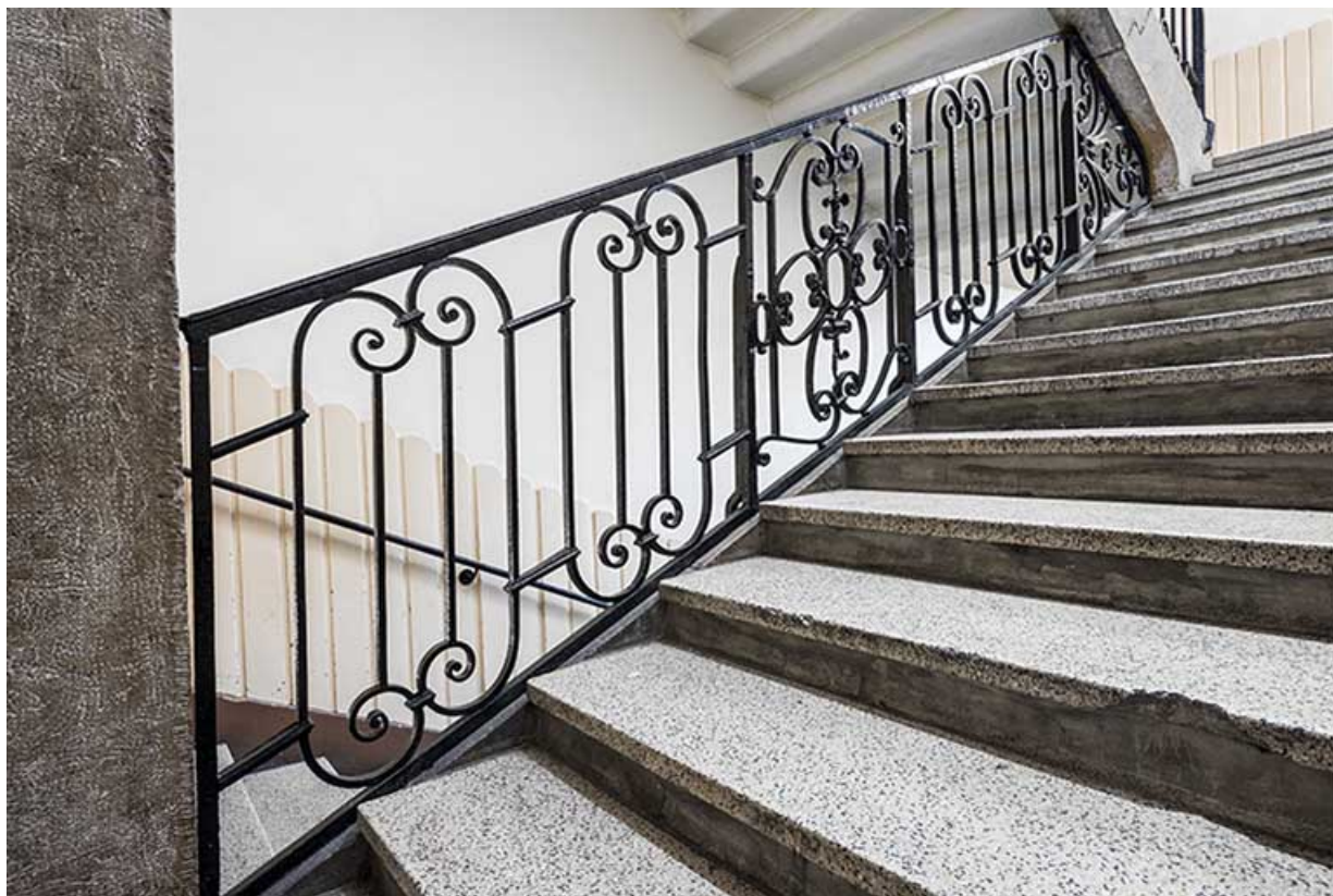
Grand escalier : garde-corps en ferronnerie.
