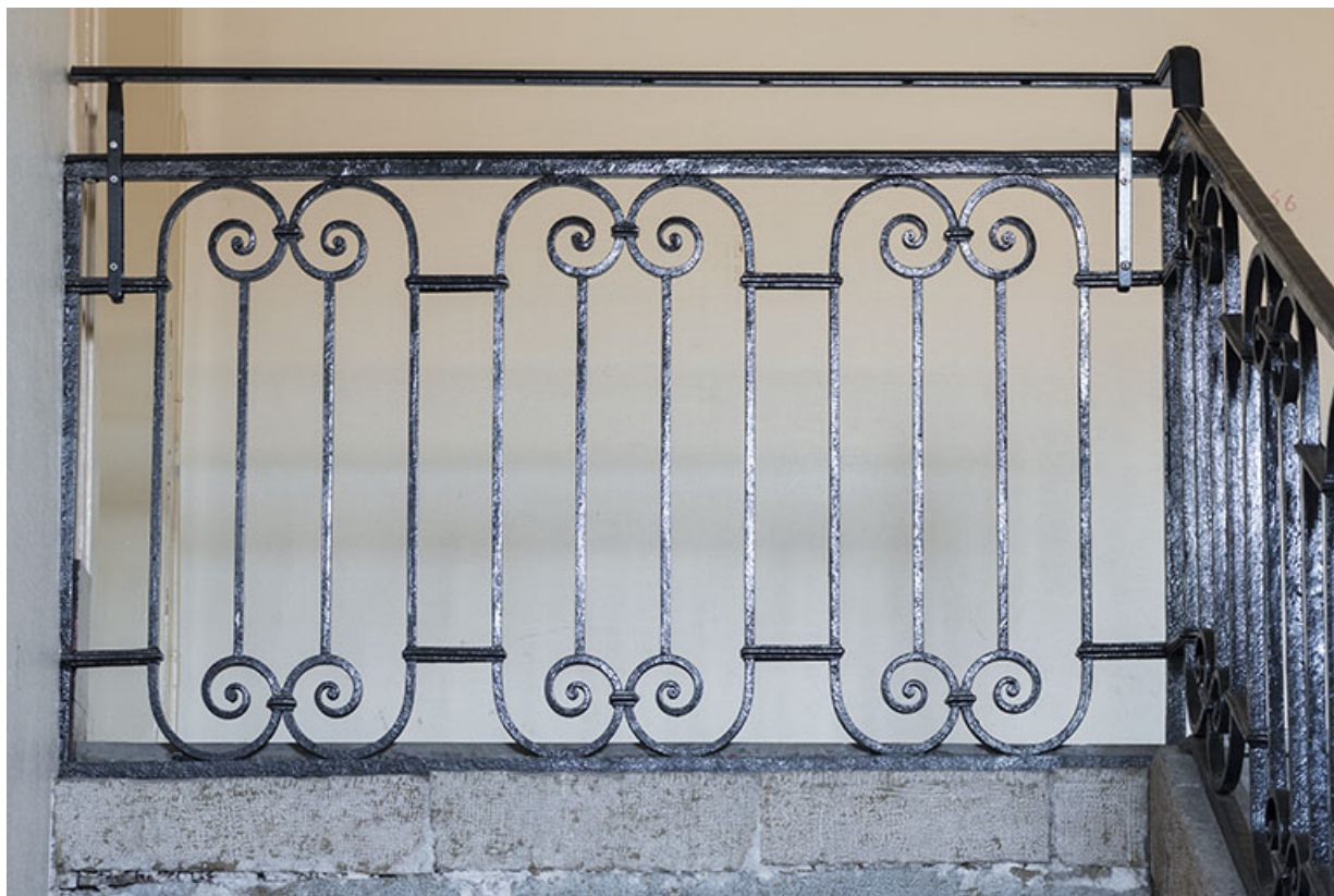
Grand escalier : garde-corps du dernier palier.
