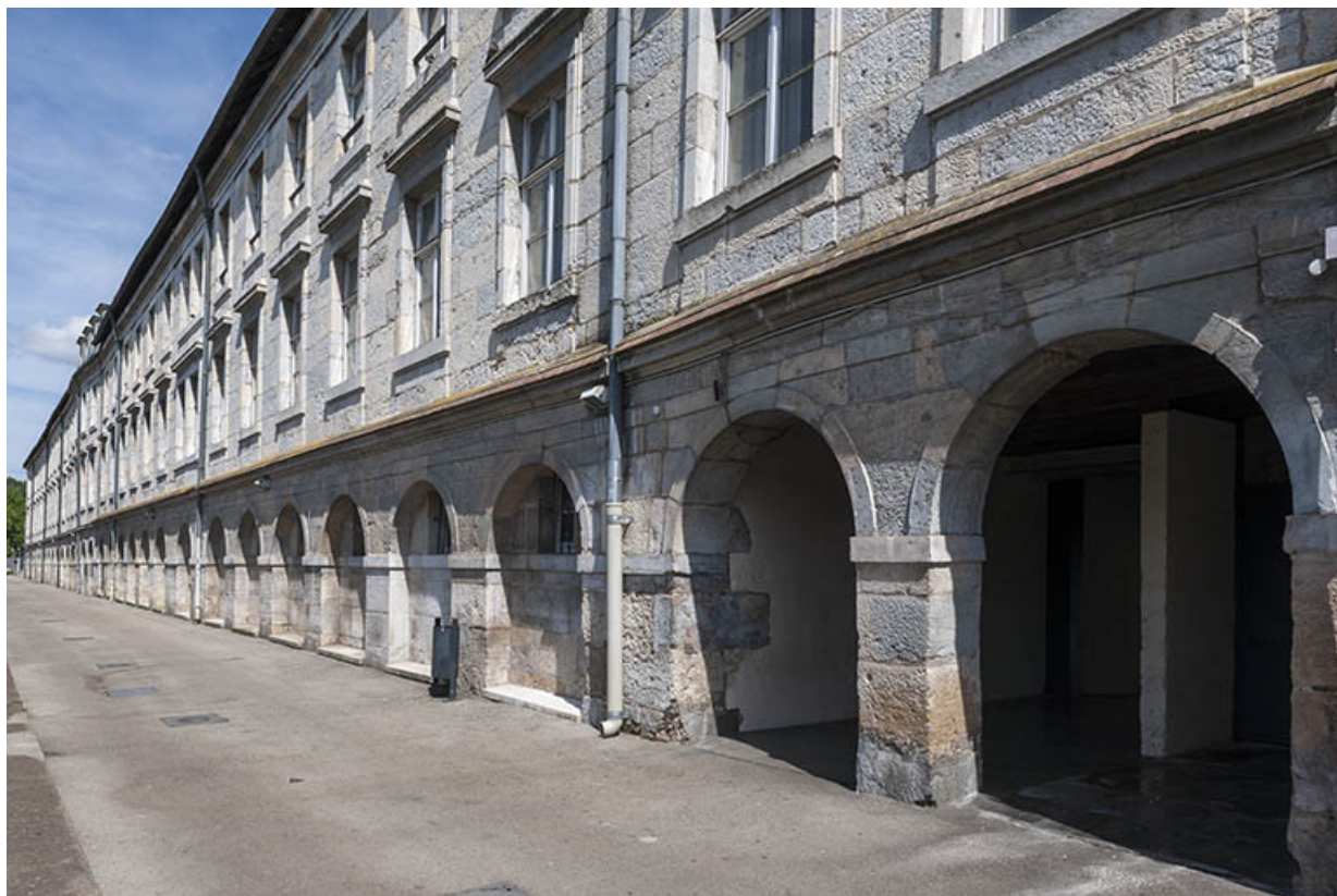
Façade postérieure, vue en enfilade de trois quarts droite. A droite, les baies donnant accès au passage couvert. 25, Besançon, 27 rue des Boucheries
