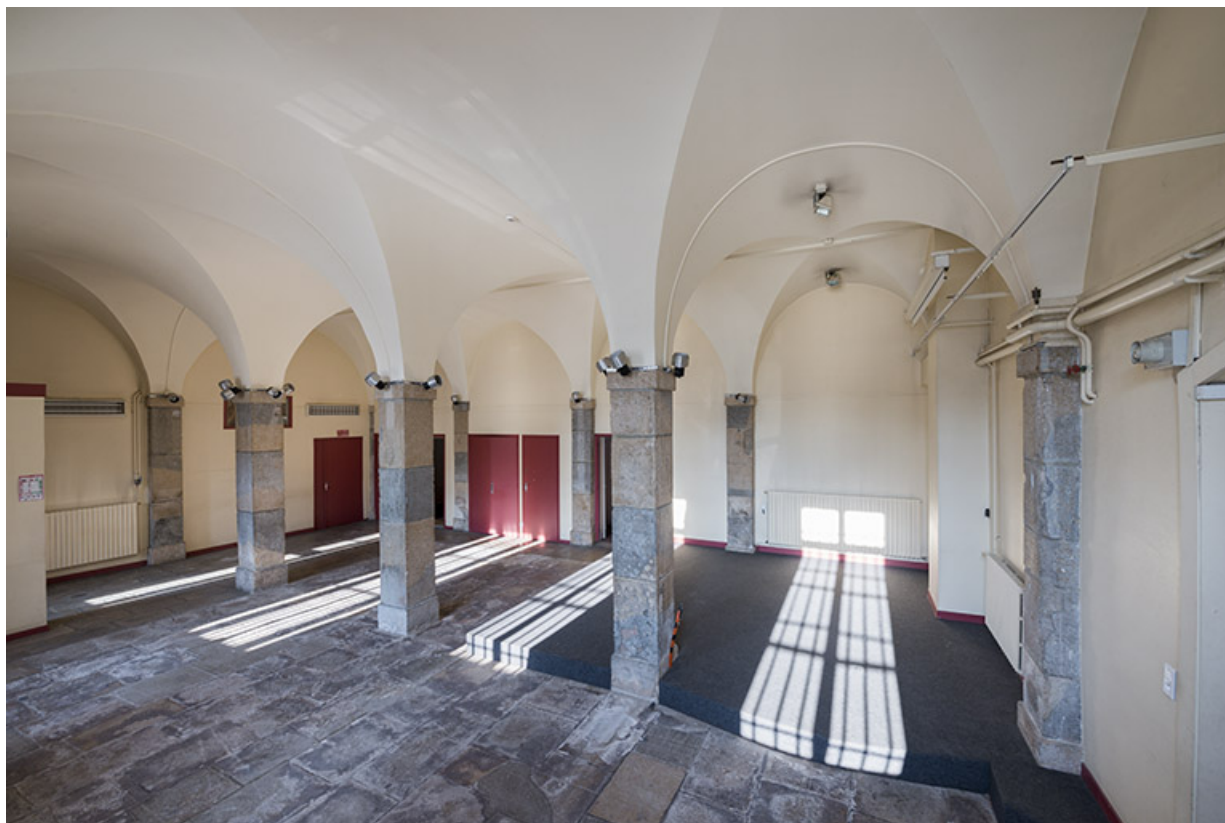
Rez-de-chaussée, partie gauche : pièce voûtée.
