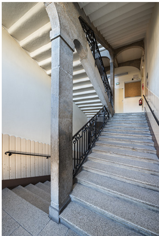
Grand escalier : deuxième volée depuis le premier repos.
