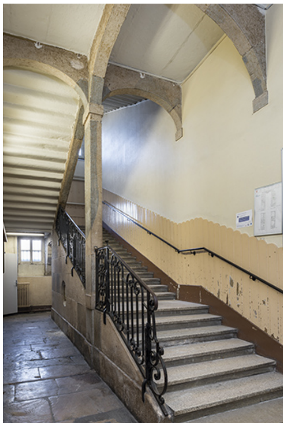
Grand escalier : vue d'ensemble de trois quarts gauche, au rez-de chaussée.
