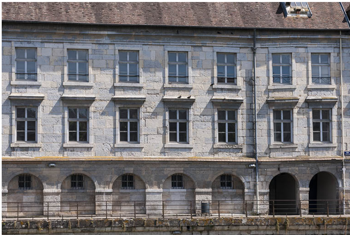
Vue rapprochée des immeubles qui Vauban depuis le quai de Strasbourg.
