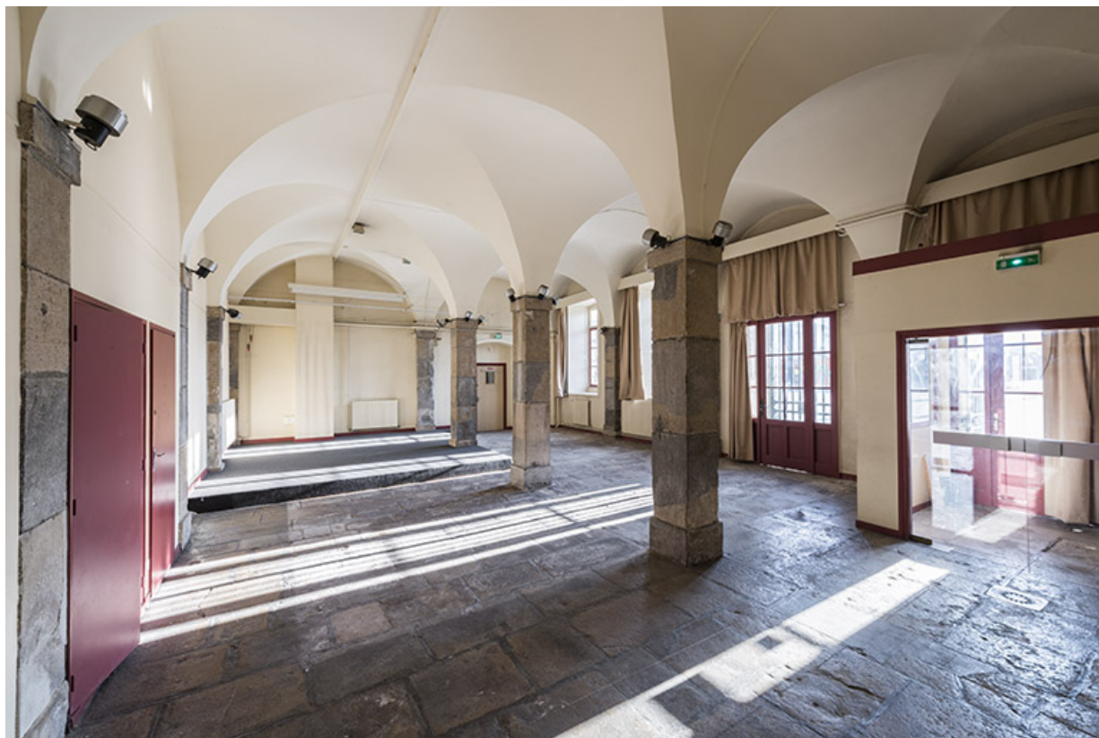
Rez-de-chaussée, partie gauche : pièce voûtée (avec portes et fenêtres côté place). 25, Besançon, 27 rue des Boucheries
