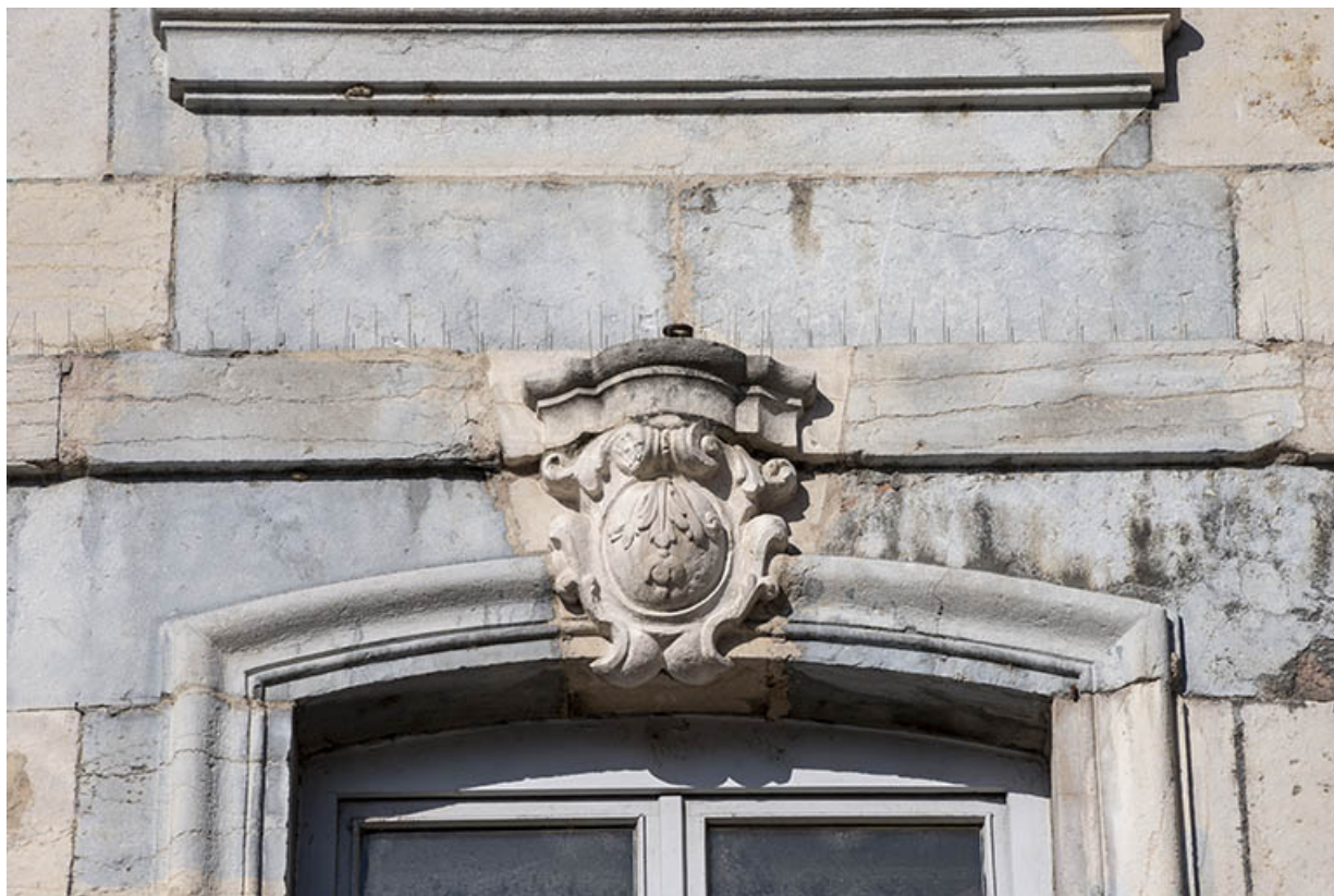
Avant-corps central : clef de l'arc coiffant la fenêtre du premier étage.
