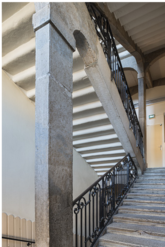
Grand escalier : pilier et limon (au premier repos).
