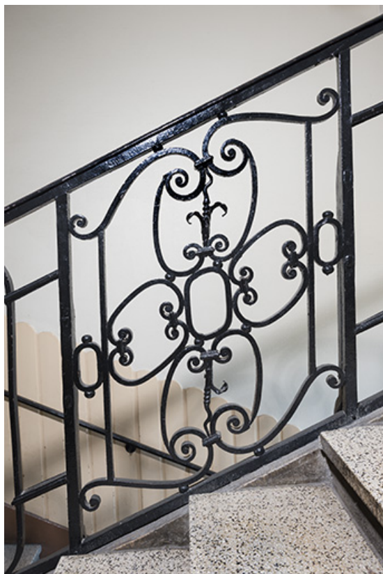
Grand escalier : motif central du garde-corps.
