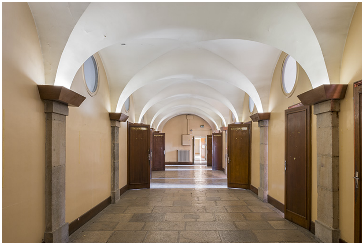
Premier étage, partie gauche : couloir central voûté.
