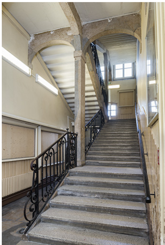
Grand escalier : vue d'ensemble au rez-de chaussée.
