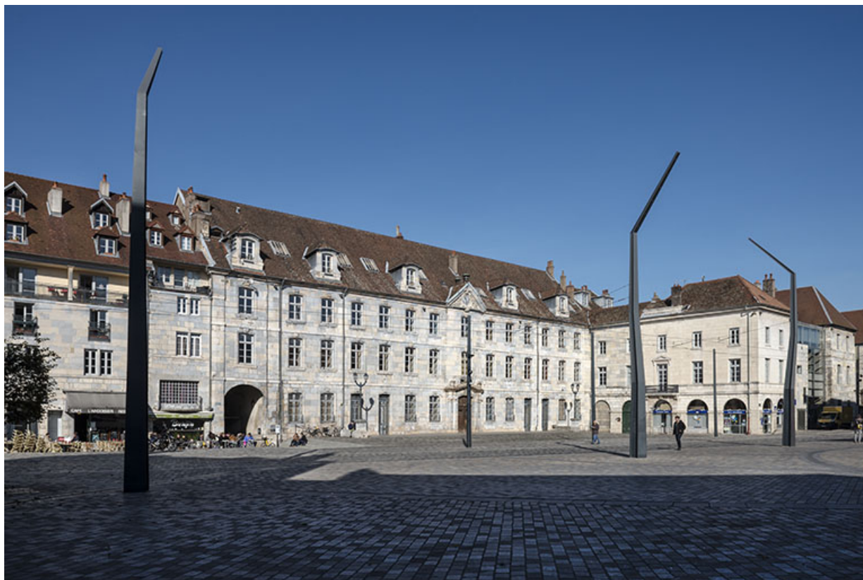
Vue d'ensemble, depuis la place de la Révolution.
