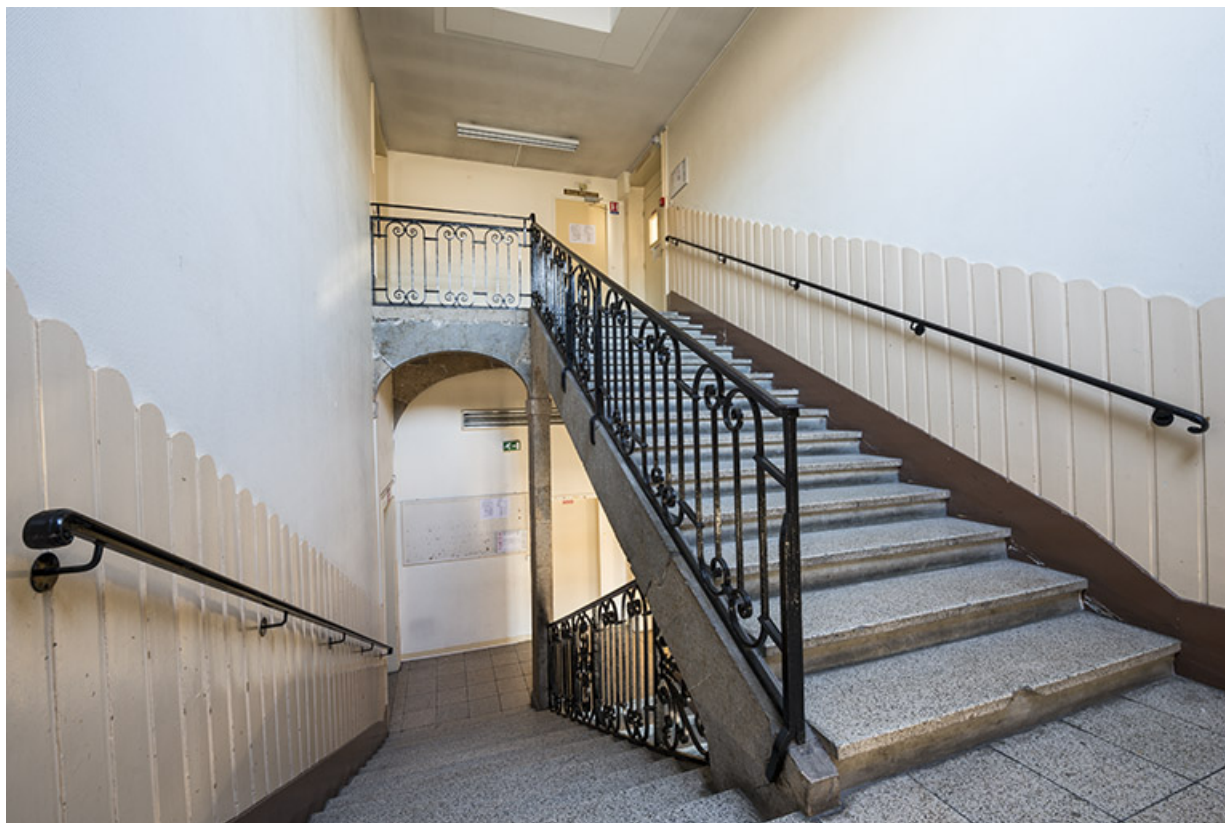
Grand escalier : volées réunissant le deuxième étage carré et l'étage en surcroît, depuis le dernier repos.
