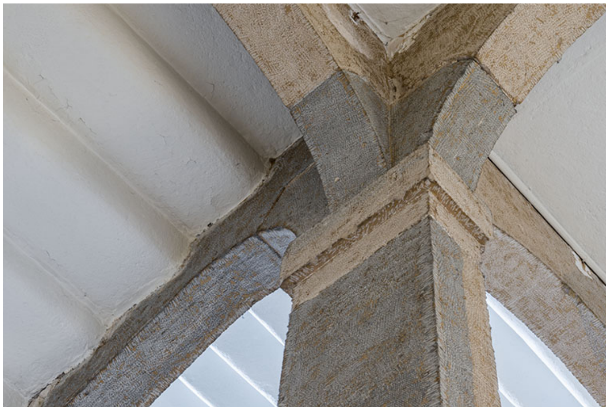
Grand escalier : partie supérieure du premier pilier rectangulaire au rez-de-chaussée, supportant un limon et trois arcs. 25, Besançon, 27 rue des Boucheries
