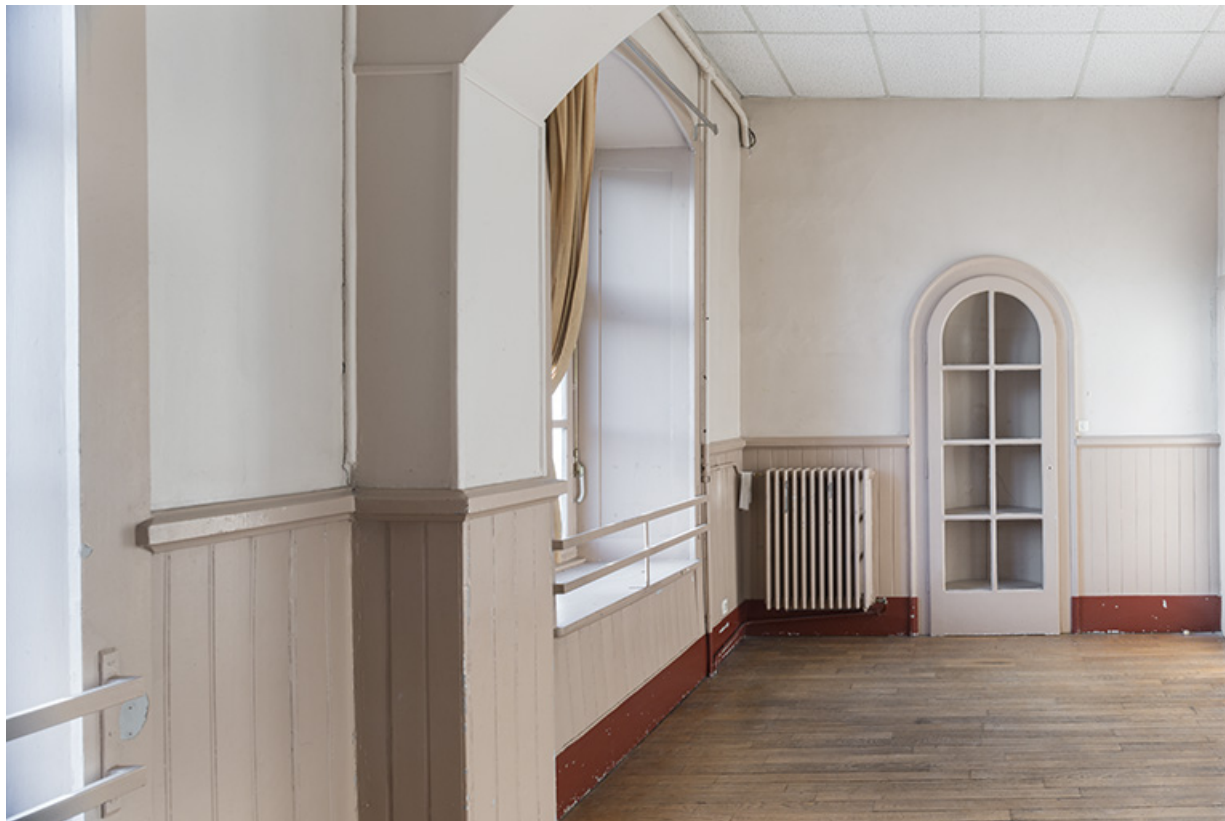
Deuxième étage, partie gauche : pièce avec niche murale (salle Saint-Saens), près ou au-dessus du passage couvert (côté place). 25, Besançon, 27 rue des Boucheries
