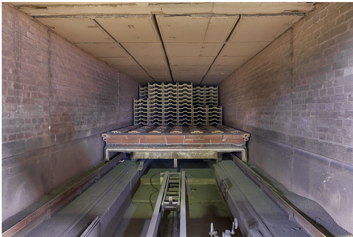
Unité de fabrication dite UL 1. Intérieur du four désaffecté, avec son chariot et les supports réfractaires. 25, Lantenne-Vertière route de Mercey
