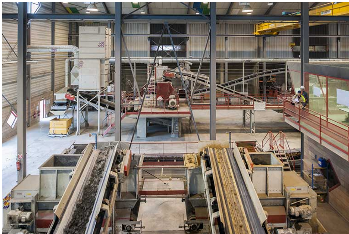
Unité de préparation des terres. Au premier plan, transporteurs à bande. Au second plan, laminoir-finisher. 25, Lantenne-Vertière route de Mercey
