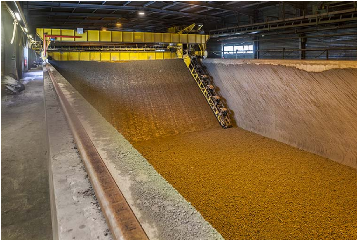
Fosse à terre. Excavatrice (reprise de la terre après maturation). 25, Lantenne-Vertière route de Mercey
