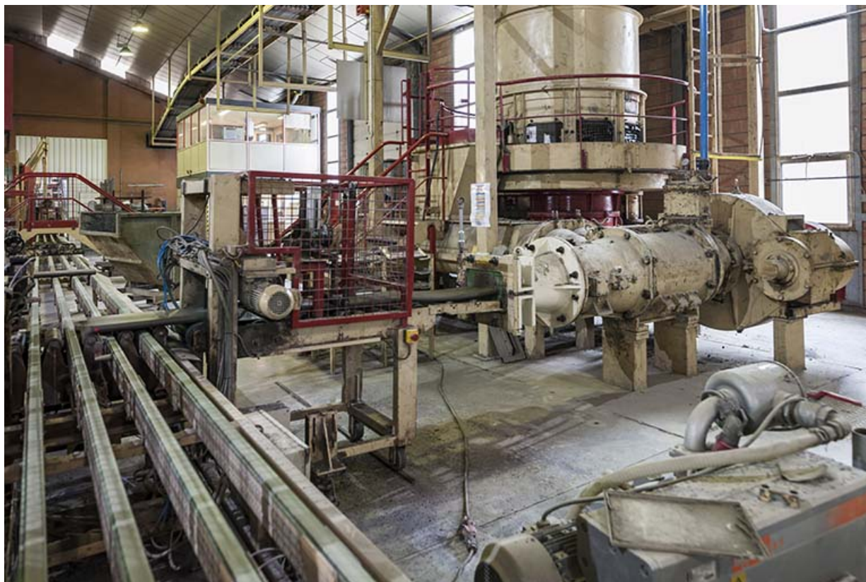
Unité de fabrication dite UL 3. Détail de la bande de terre continue en sortie de la mouleuse. 25, Lantenne-Vertière route de Mercey
