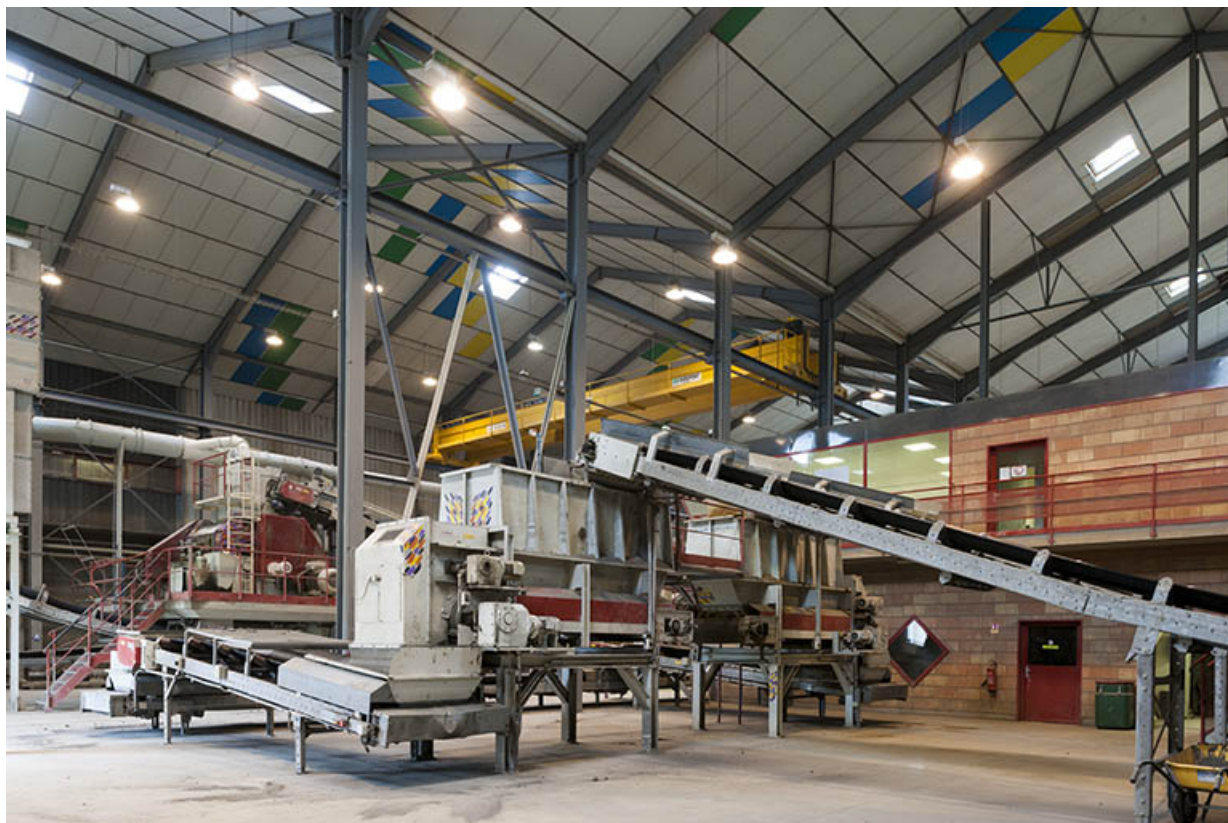
Atelier de préparation des terres. Vue d'ensemble depuis le sud. 25, Lantenne-Vertière route de Mercey
