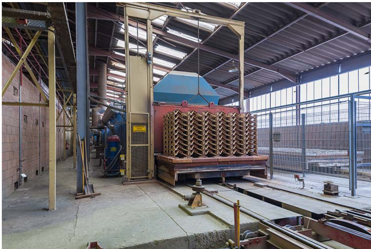
Unité de fabrication dite UL 1. Four (1984). 25, Lantenne-Vertière route de Mercey
