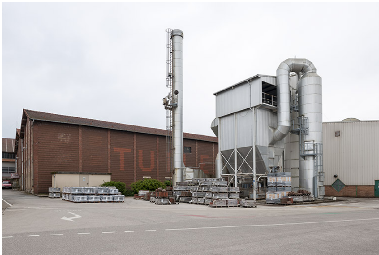
Atelier de fabrication (actuellement UL 3). 25, Lantenne-Vertière route de Mercey
