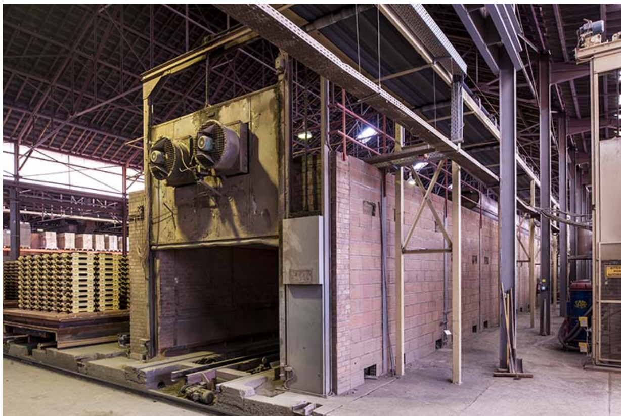
Unité de fabrication dite UL 1. Four désaffecté (années 1960 ?).
