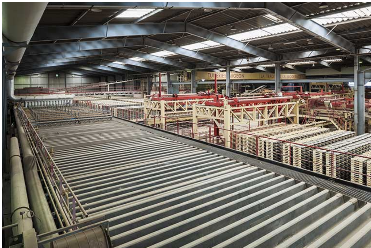
Unité de fabrication dite UL 2 (à l'arrêt). Vue d'ensemble. Au premier plan, partie supérieure du four piscine.
