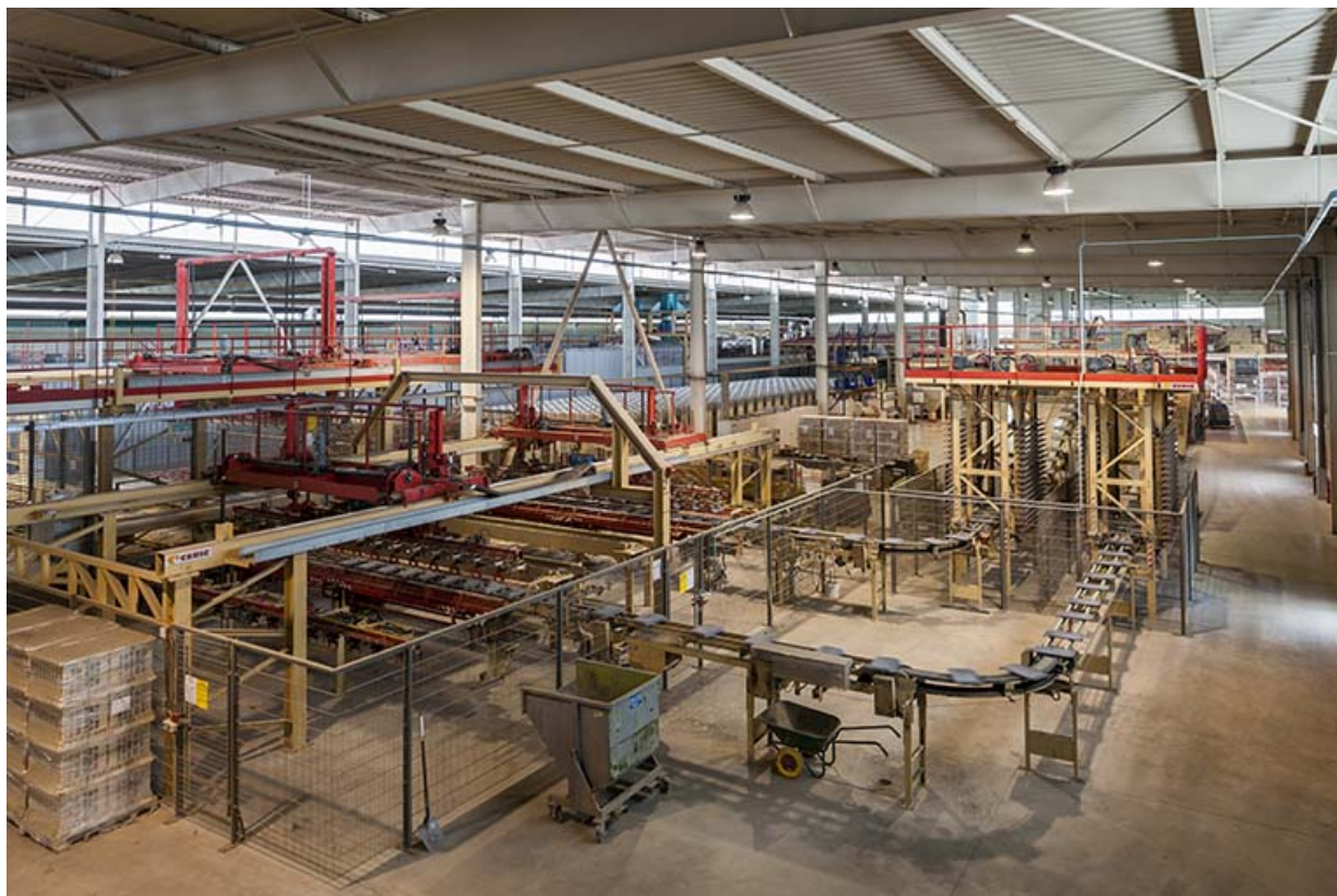
Unité de fabrication dite UL 5. Vue plongeante. Circulation des tuiles par convoyeurs. 25, Lantenne-Vertière route de Mercey
