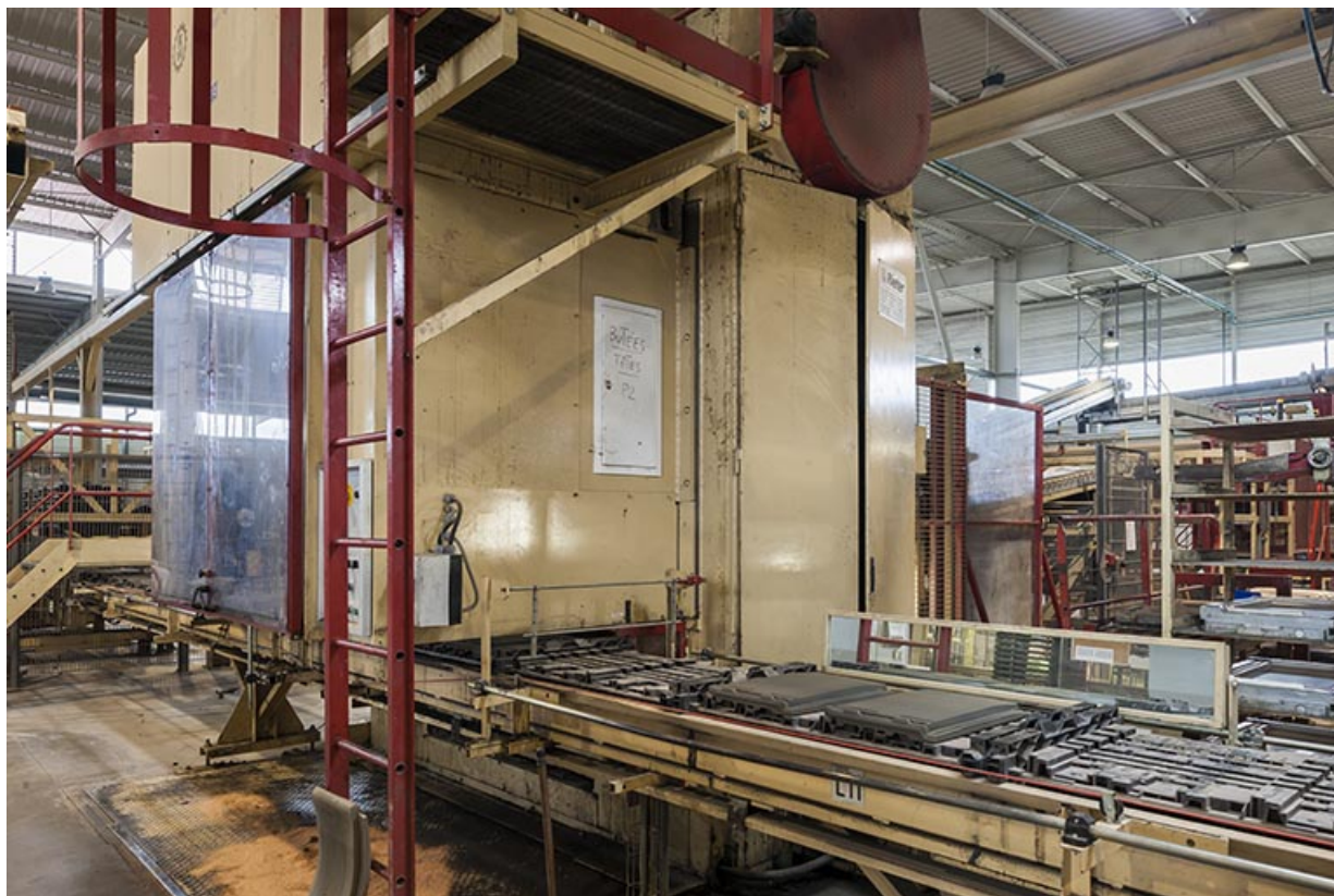
Unité de fabrication dite UL 5. Sortie de presse. 25, Lantenne-Vertière route de Mercey
