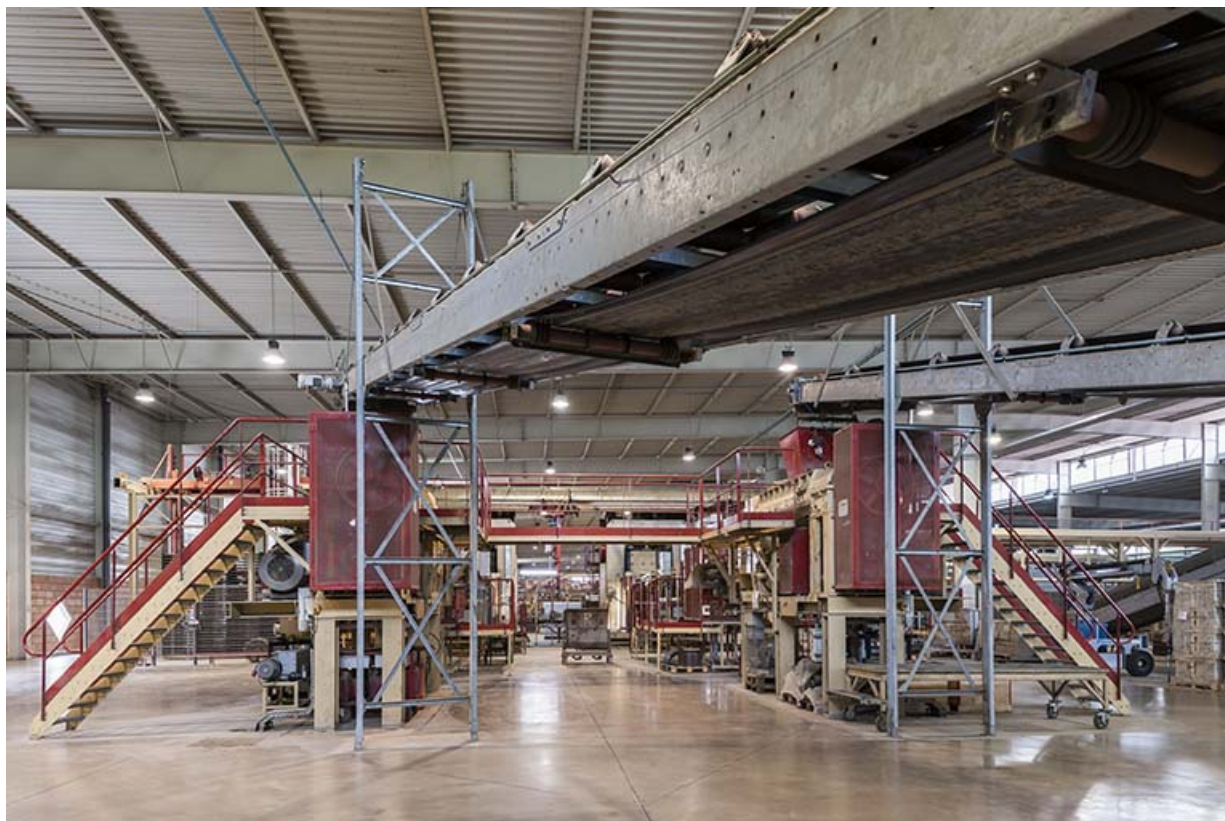
Unité de fabrication dite UL 5. Acheminement de la terre aux deux lignes de pressage par transporteur à bande. 25, Lantenne-Vertière route de Mercey
