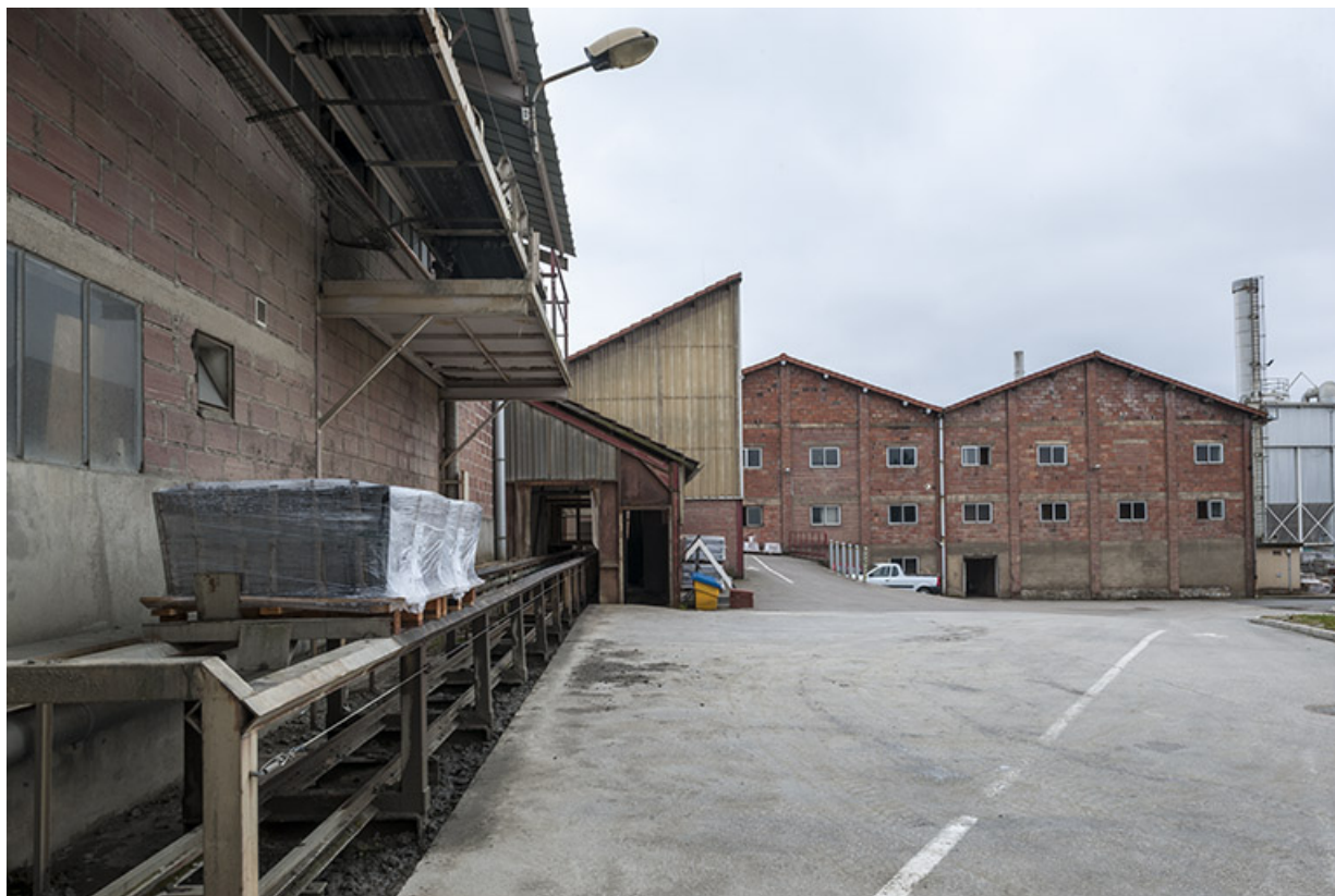
Atelier de fabrication (actuellement UL 3) depuis le nord-est. 25, Lantenne-Vertière route de Mercey
