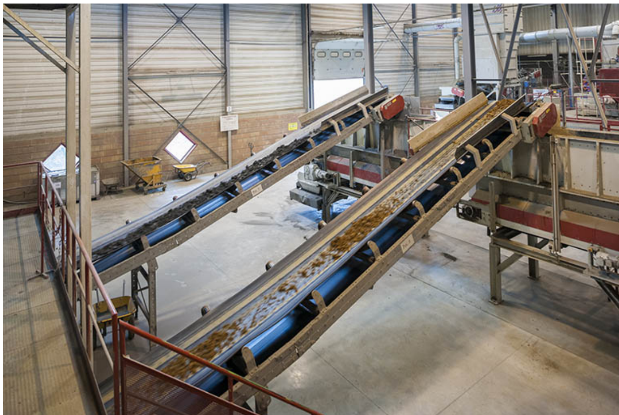
Unité de préparation des terres. Transport depuis le doseur (pesée et brise-mottes) jusqu'au doseurs-tampon. 25, Lantenne-Vertière route de Mercey
