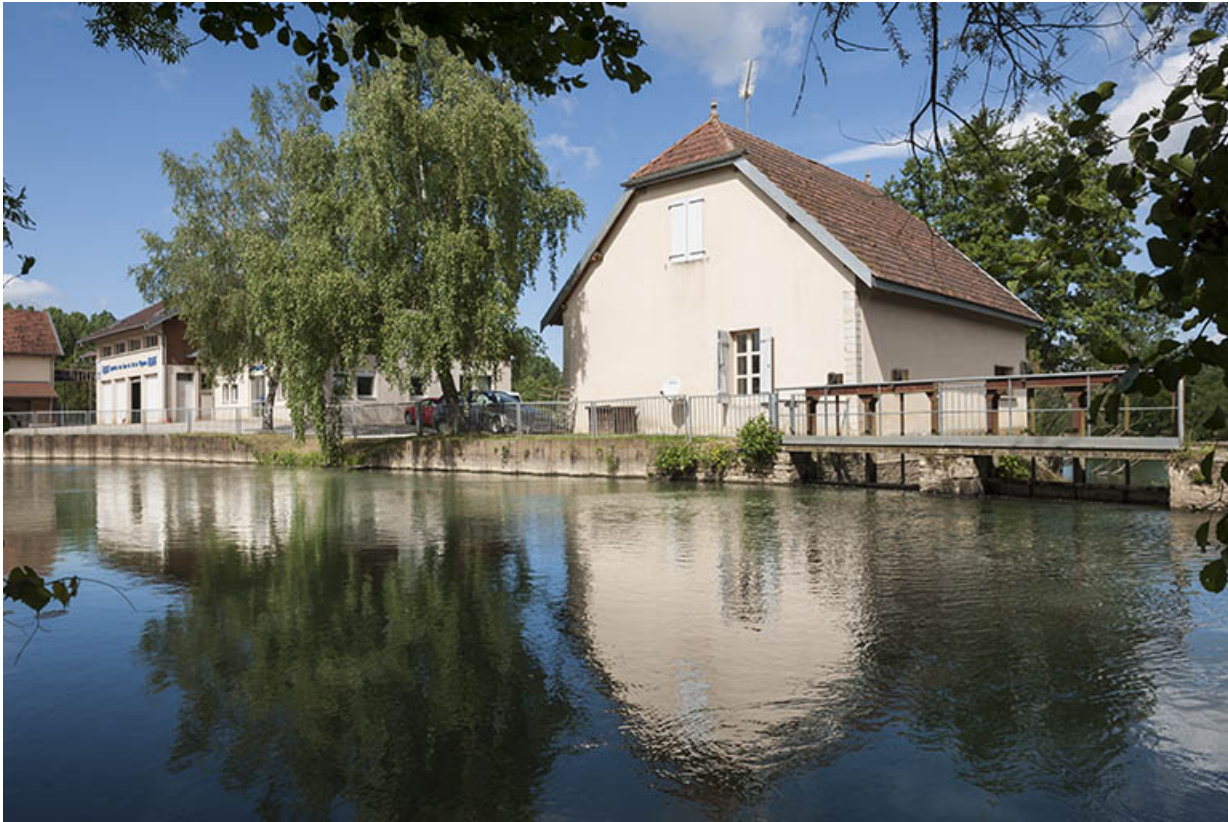
Vue depuis le début du canal d'aménée.
