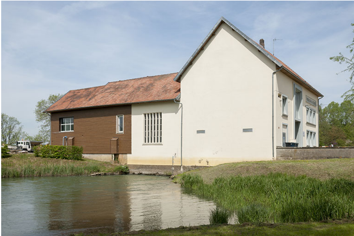
La centrale hydroélectrique vue depuis le sud.
