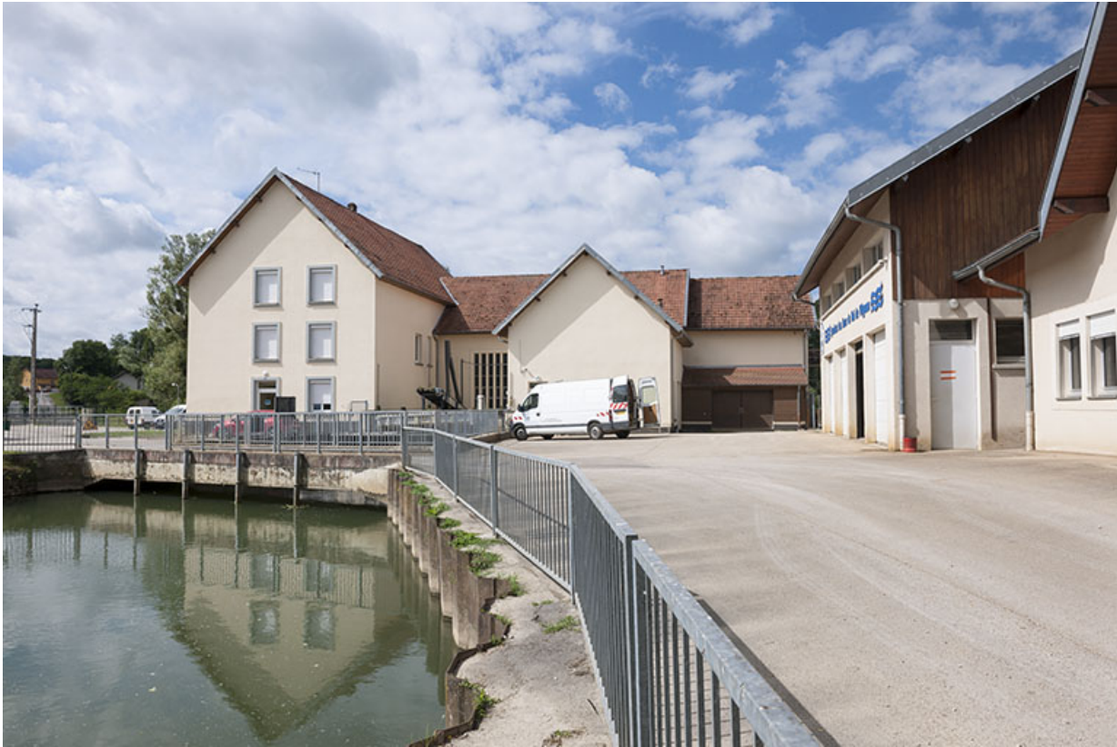
La centrale hydroélectrique vue depuis le nord.
