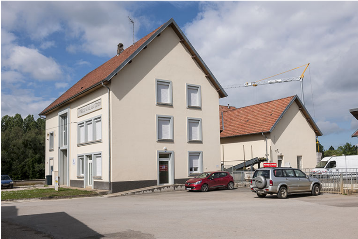
La centrale hydroélectrique vue de trois quarts gauche.
