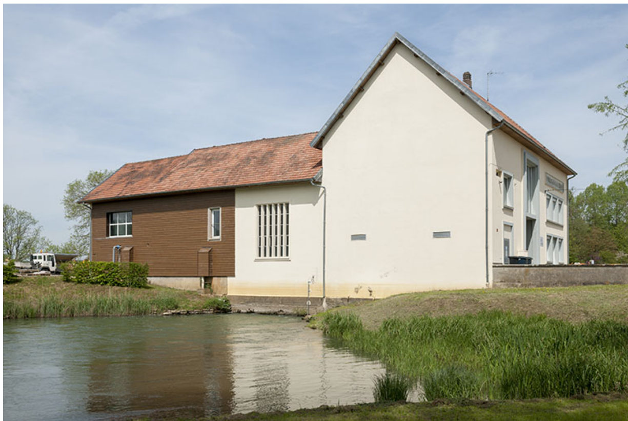
La centrale hydroélectrique vue depuis le sud.
