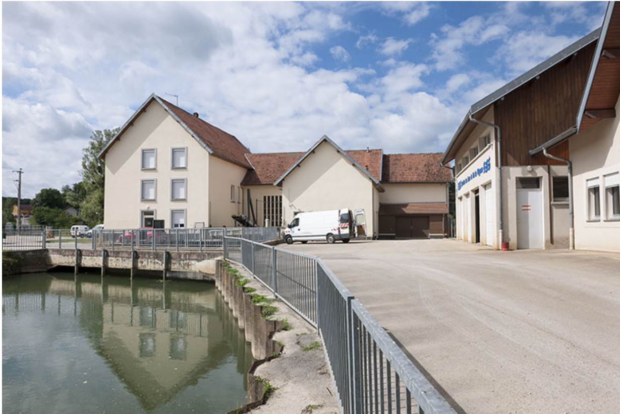
La centrale hydroélectrique vue depuis le nord.
