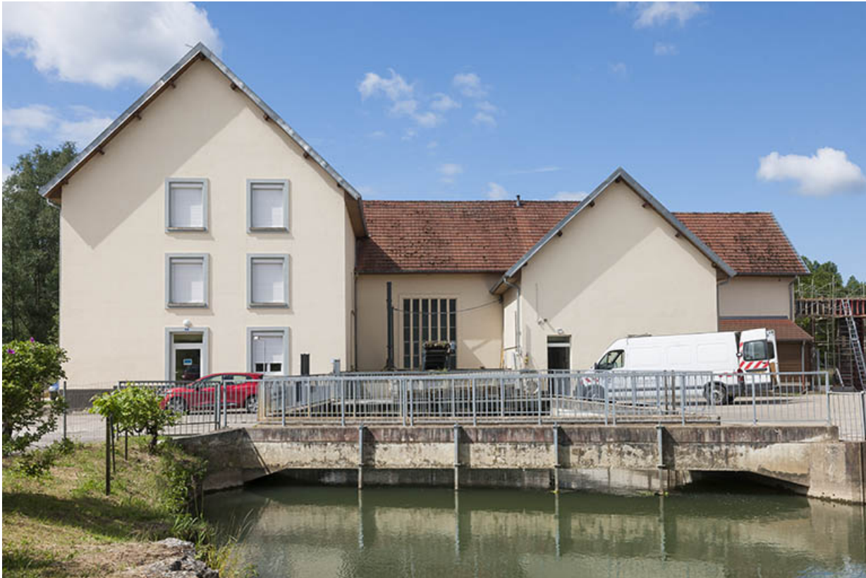
La centrale hydroélectrique depuis le canal d'amenée.
