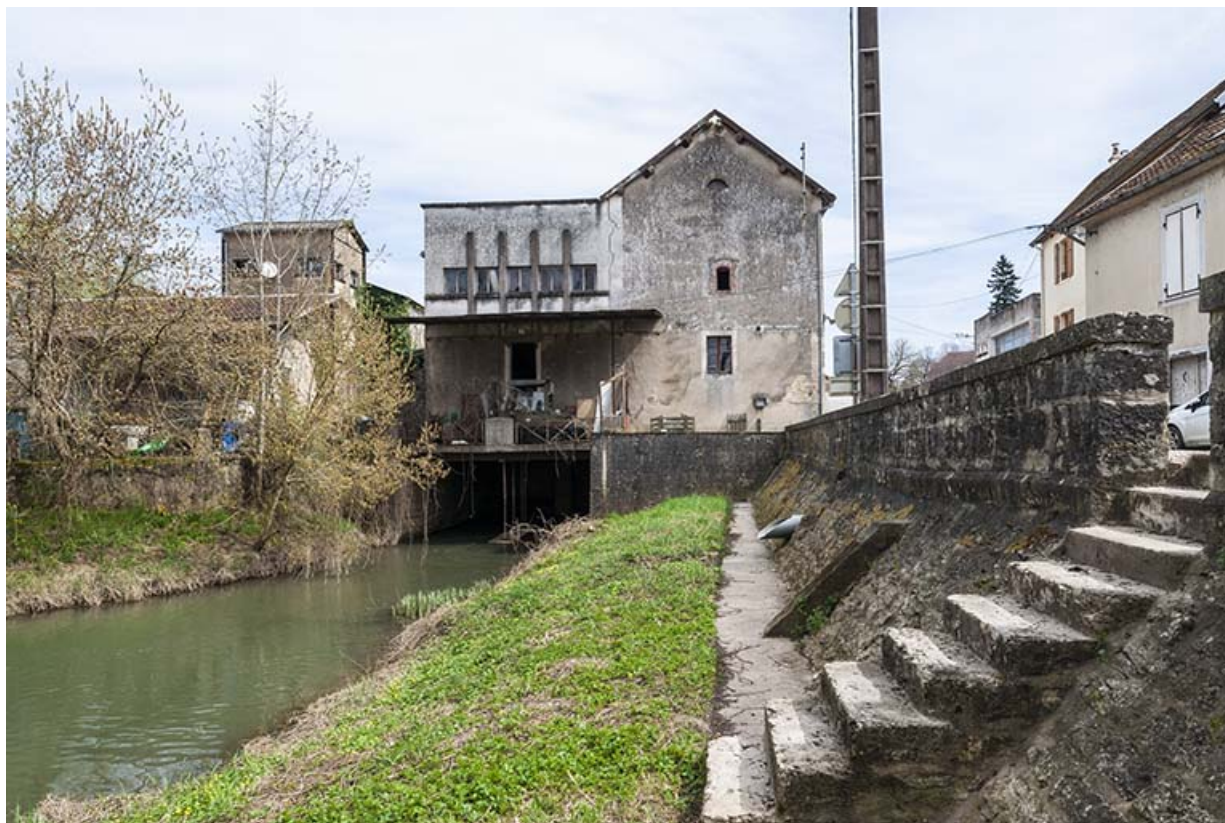
La minoterie vue depuis le canal de fuite.
