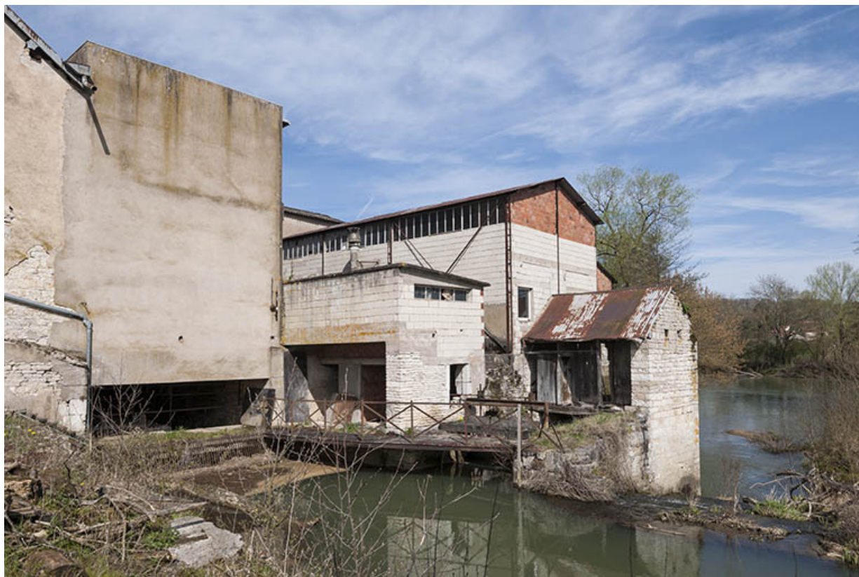
Bâtiments à l'extrémité est du barrage, à l'entrée du canal d'aménée.
