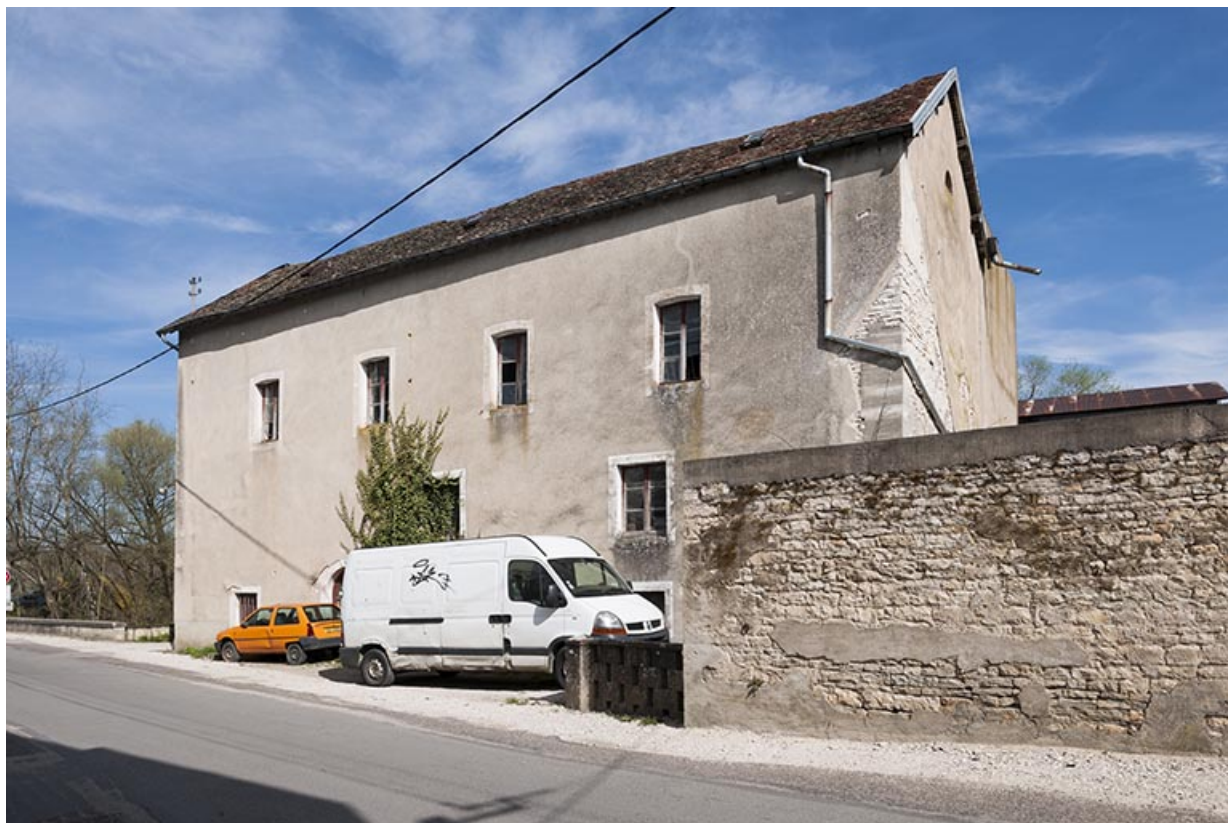
Façade sud de la minoterie.
