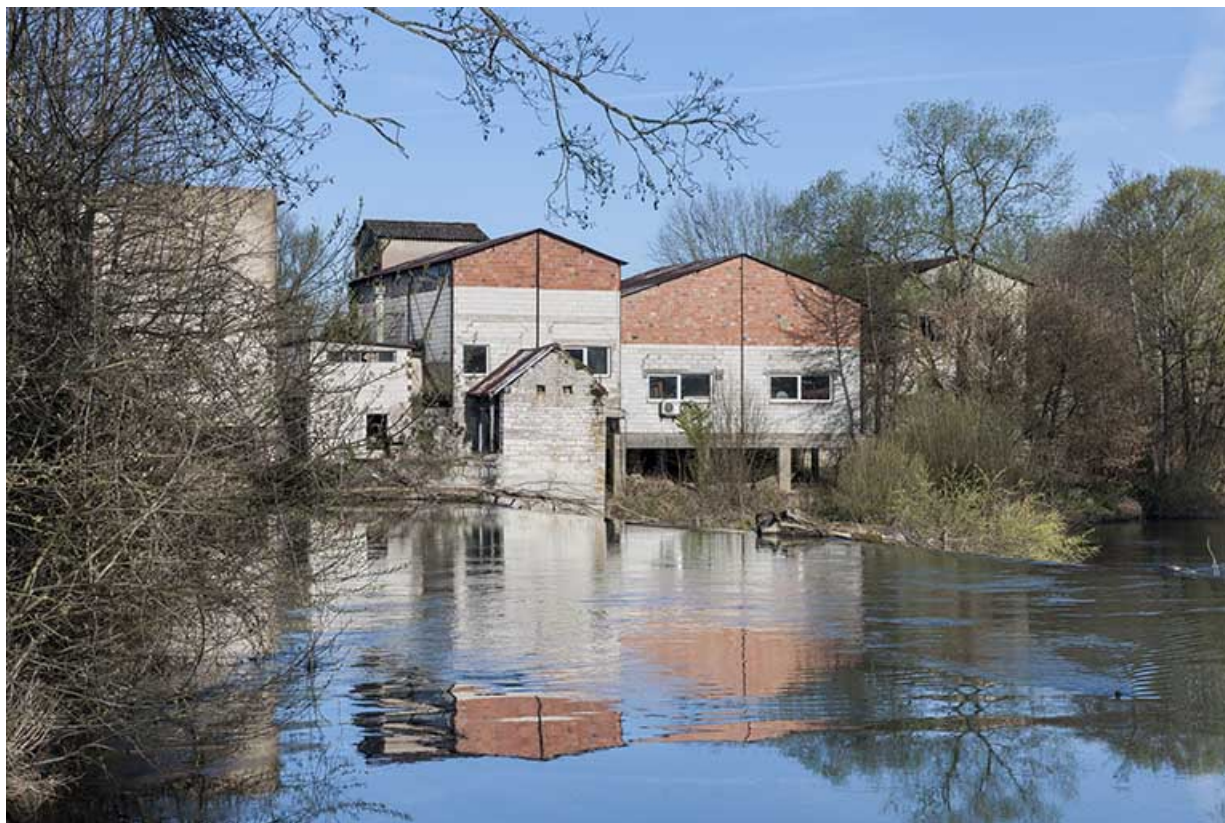
Vue d'ensemble depuis l'amont du barrage.
