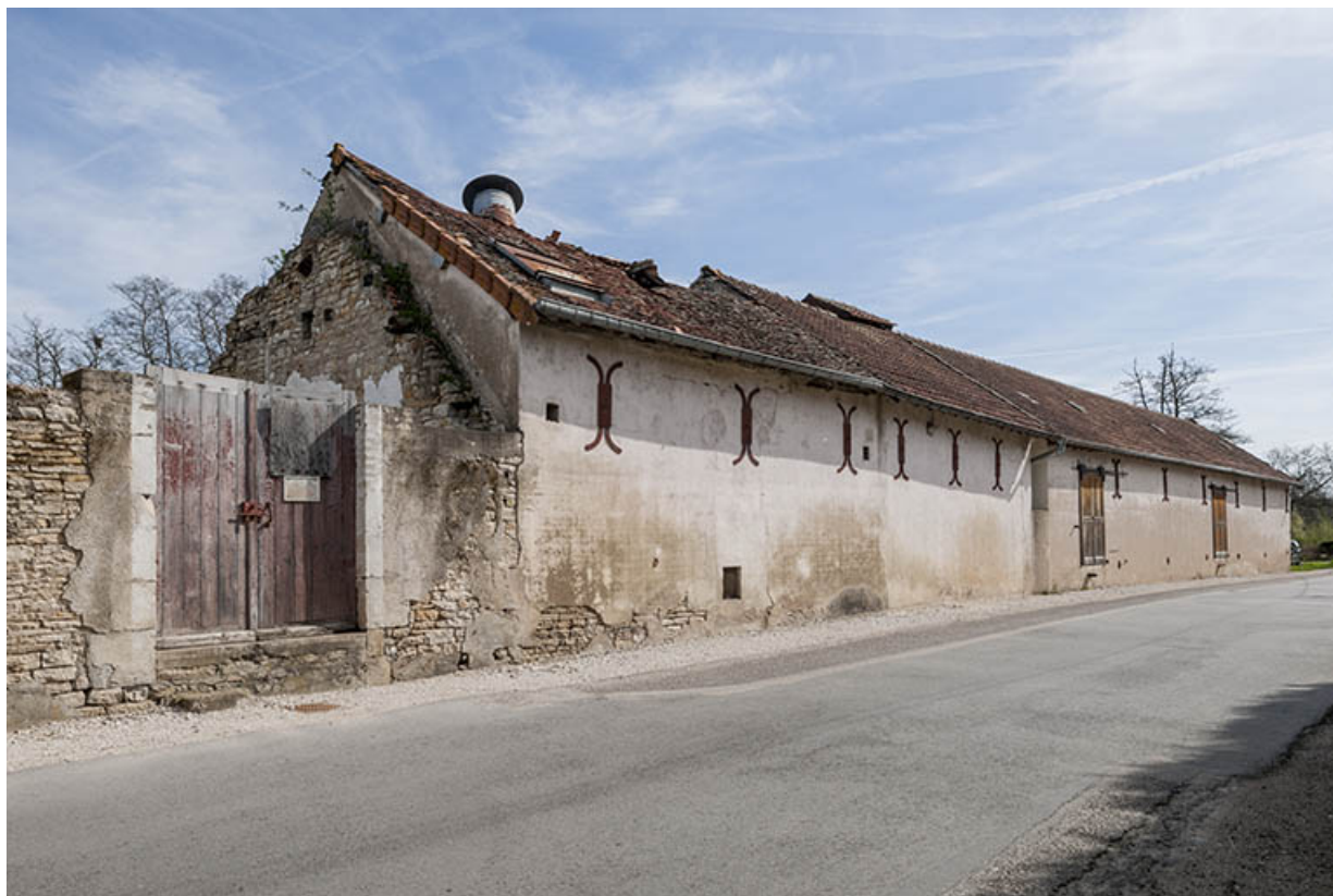
Les magasins industriels à l'est, le long de la rue de Moncley.
