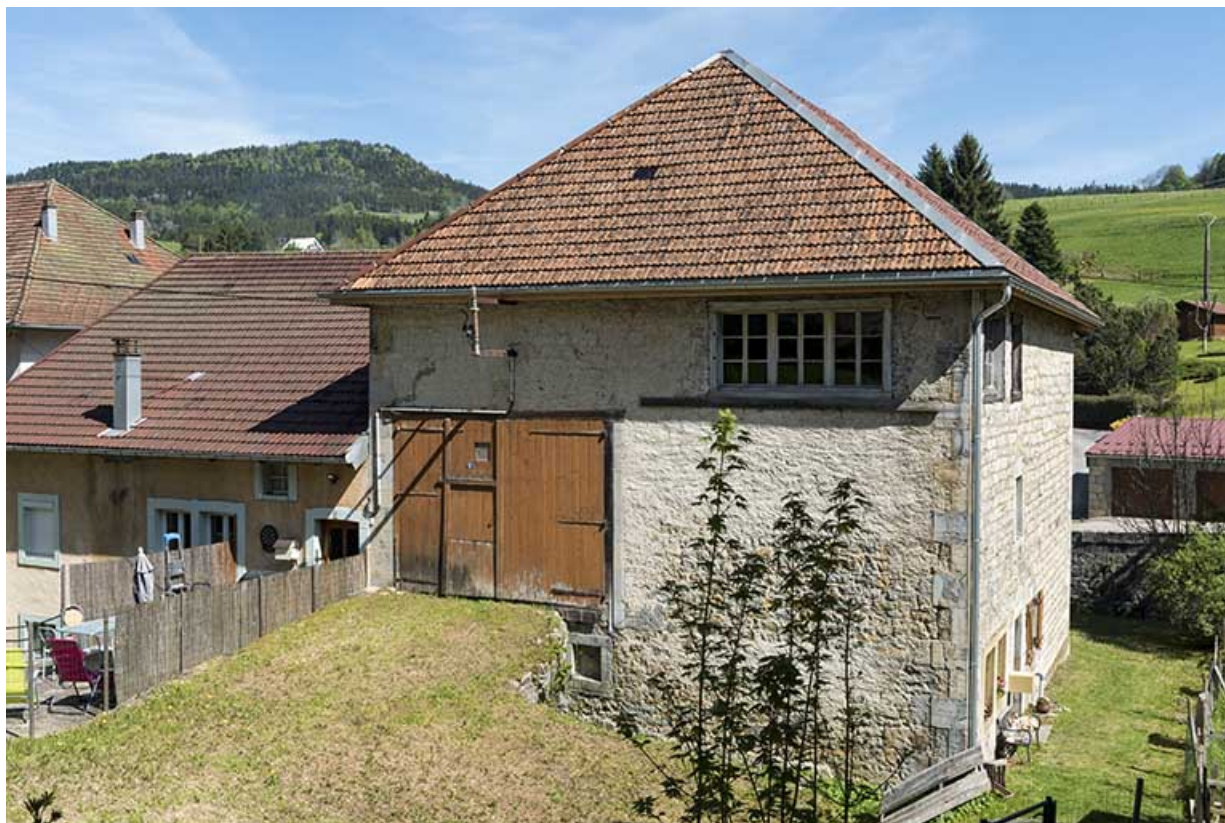
Façade nord : pont et portail de la grange, fenêtres de l'atelier sous le toit. 25, Les Gras, 5 rue de Pontarlier
