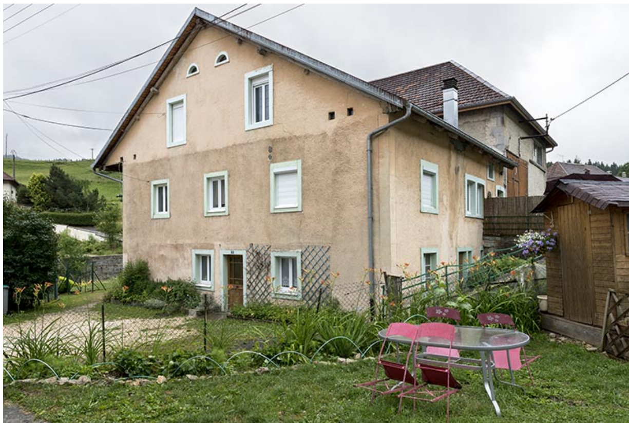
Façades antérieure et latérale droite.
