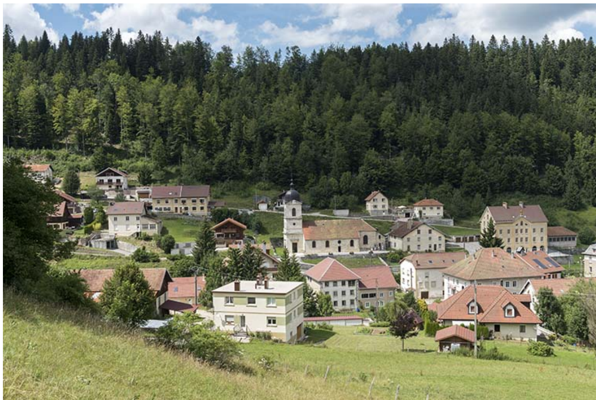
Vue d'ensemble du centre du village, depuis le sud-est. 25, Les Gras
