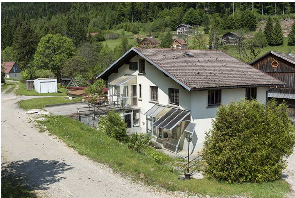
Façades postérieure et latérale gauche.
