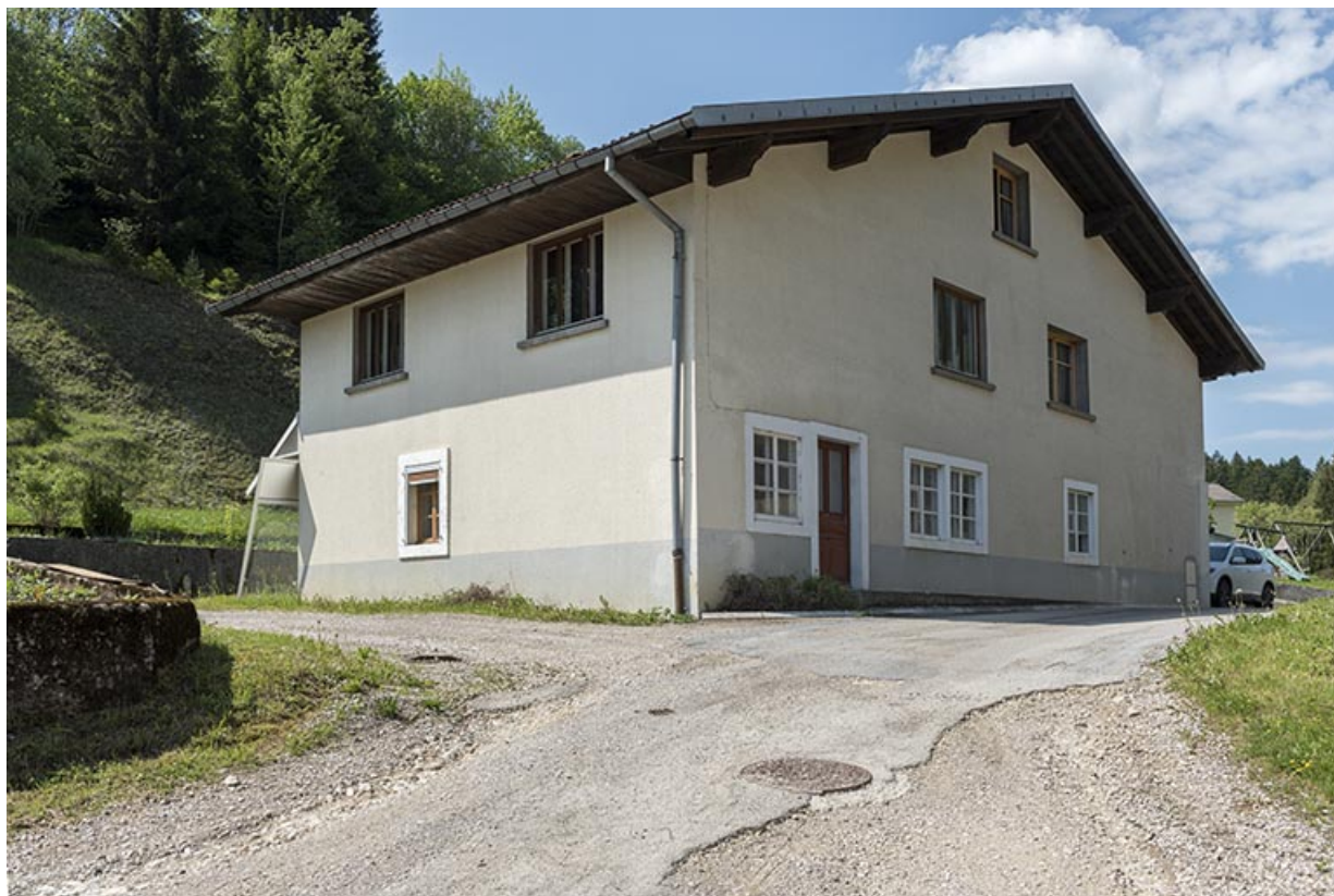
Façades postérieure et latérale gauche.
