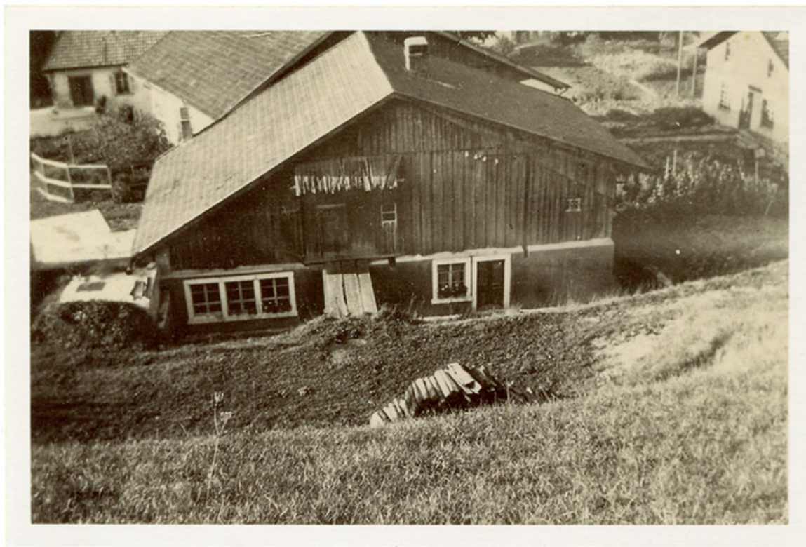
[Façade postérieure du bâtiment], décennie 1940 ou 1950 ? 25, Les Gras, 5 rue du Moulin
