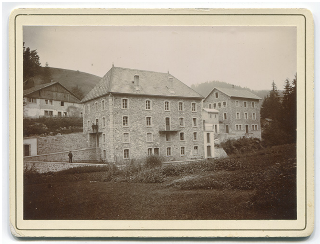
[Vue d'ensemble des deux bâtiments (non crépis), depuis le nord], 1er quart 20e siècle [après 1908]. 25, Les Gras, 4-6 rue du Moulin
