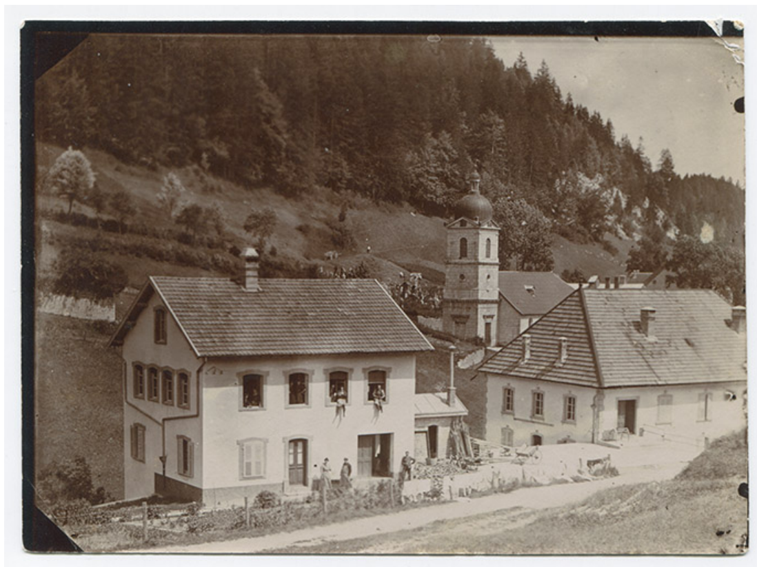
[Vue d'ensemble des deux bâtiments, depuis le sud], 1er quart 20e siècle [après 1908]. 25, Les Gras, 4-6 rue du Moulin
