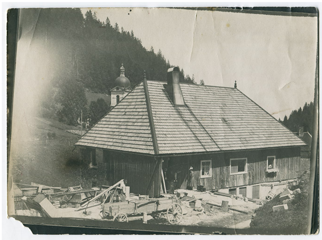
[La fonderie de cuivre Mesnier, en cours de reconstruction : façades antérieure et latérale gauche de l'immeuble], [1906 ou 1907]. 25, Les Gras, 4-6 rue du Moulin
