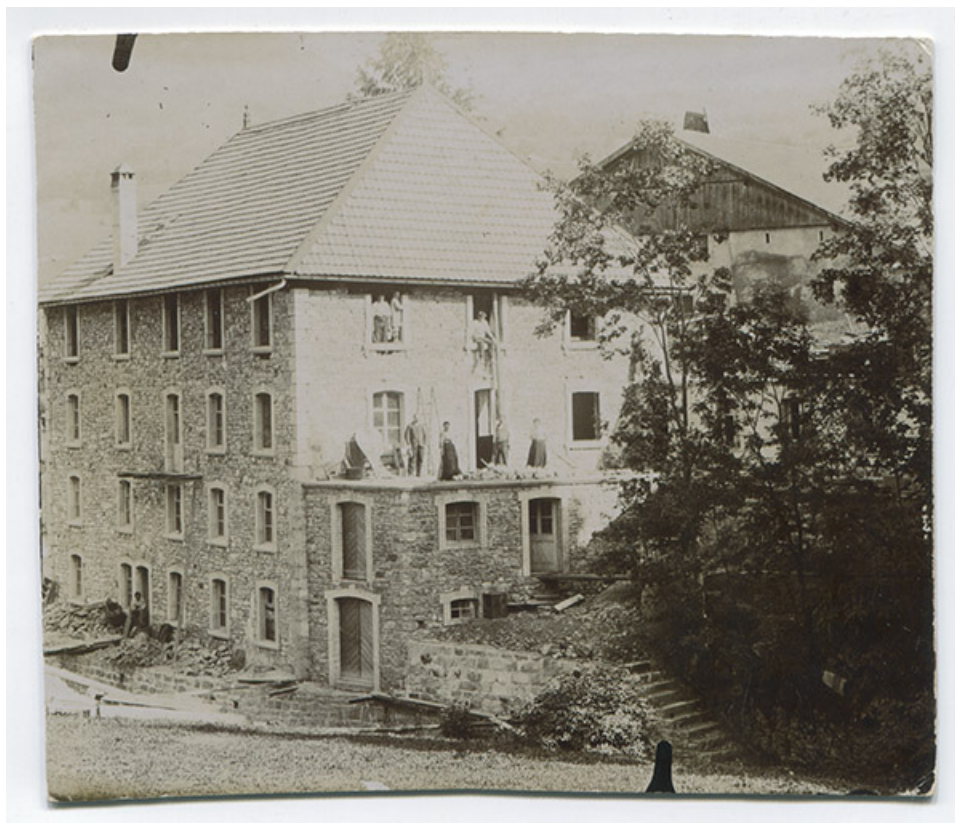
[La fonderie de cuivre Mesnier, en cours de reconstruction : façades postérieure et latérale gauche de l'immeuble], [1906 ou 1907]. 25, Les Gras, 4-6 rue du Moulin
