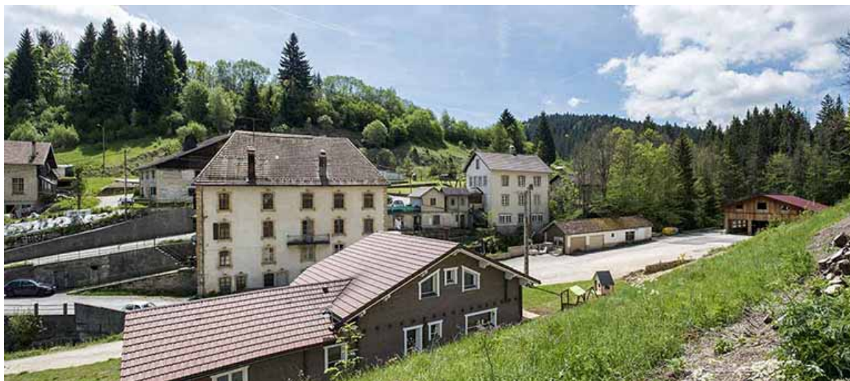
Un site de fonderie et fabrique d'outillage : l'affaire Mesnier (1873 et 1907-1908) puis Dornier et Les Fils de Virgile Amyot, 4-6 rue du Moulin. L'usine LFA se trouvait au premier plan à droite.
