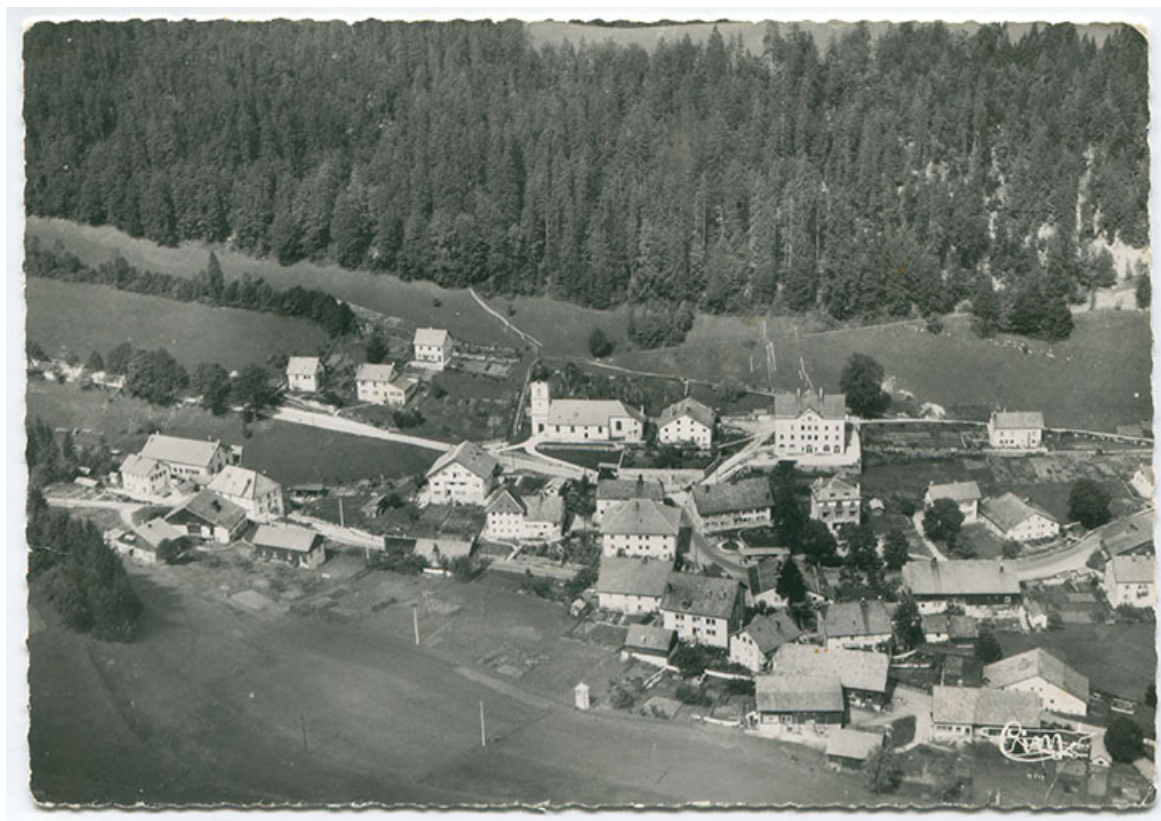
Les Gras (Doubs). 22157 A - Vue aérienne [le village vu du sud], 2e quart 20e siècle [après 1930]. 25, Les Gras
