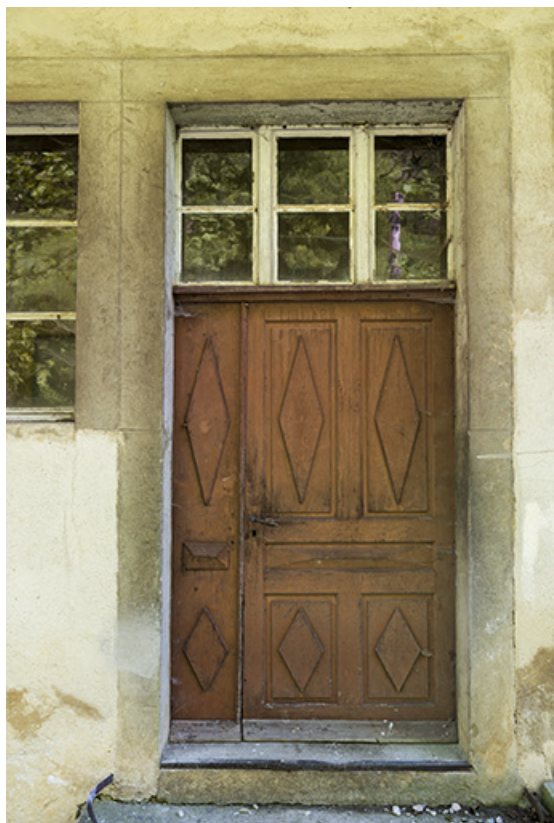
Usine, façade antérieure : porte.
