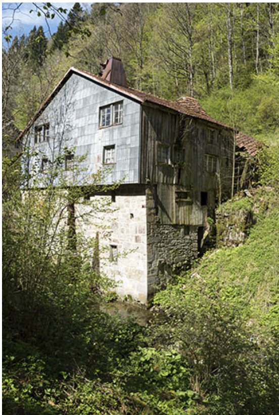
Ancien moulin : façades postérieure et latérale droite. 25, Les Gras, 11-15 Grande Rue
