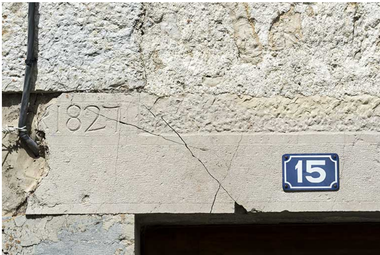
Ancien moulin : date sur la façade antérieure.
