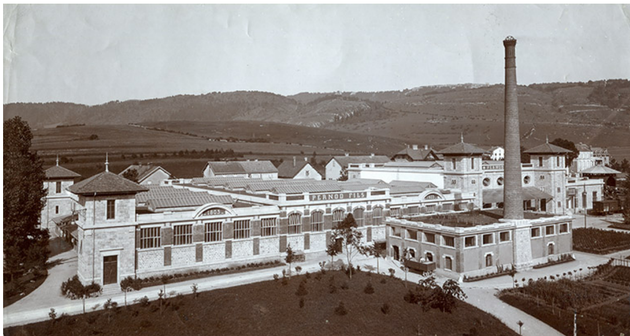
Vue d'ensemble de l'usine après reconstruction, fotogr., s.d. [1903 ?]. 25, Pontarlier, 2 avenue de l'Armée de l'Est
