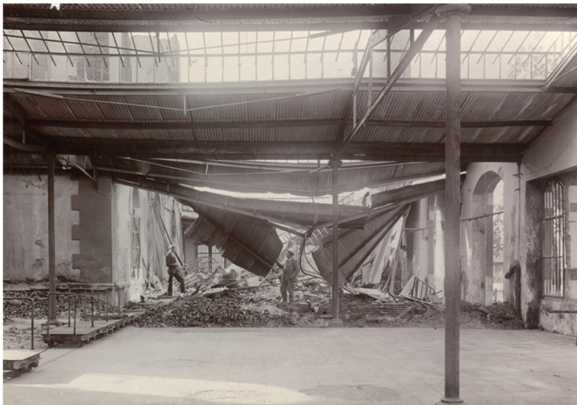
Etat d'un bâtiment après l'incendie du 11 août 1901, fotogr., s.d. [1901 ?].
