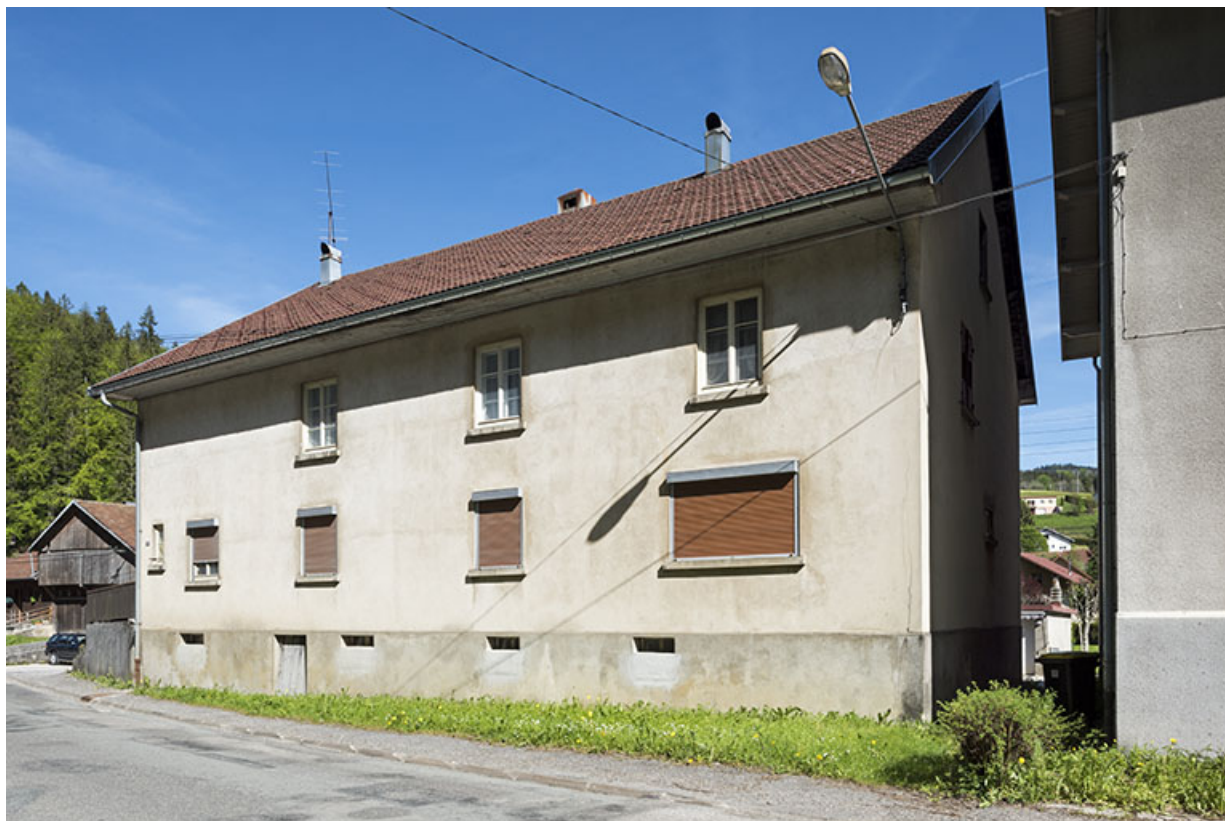
Immeuble : façade latérale droite, de trois quarts droite.
