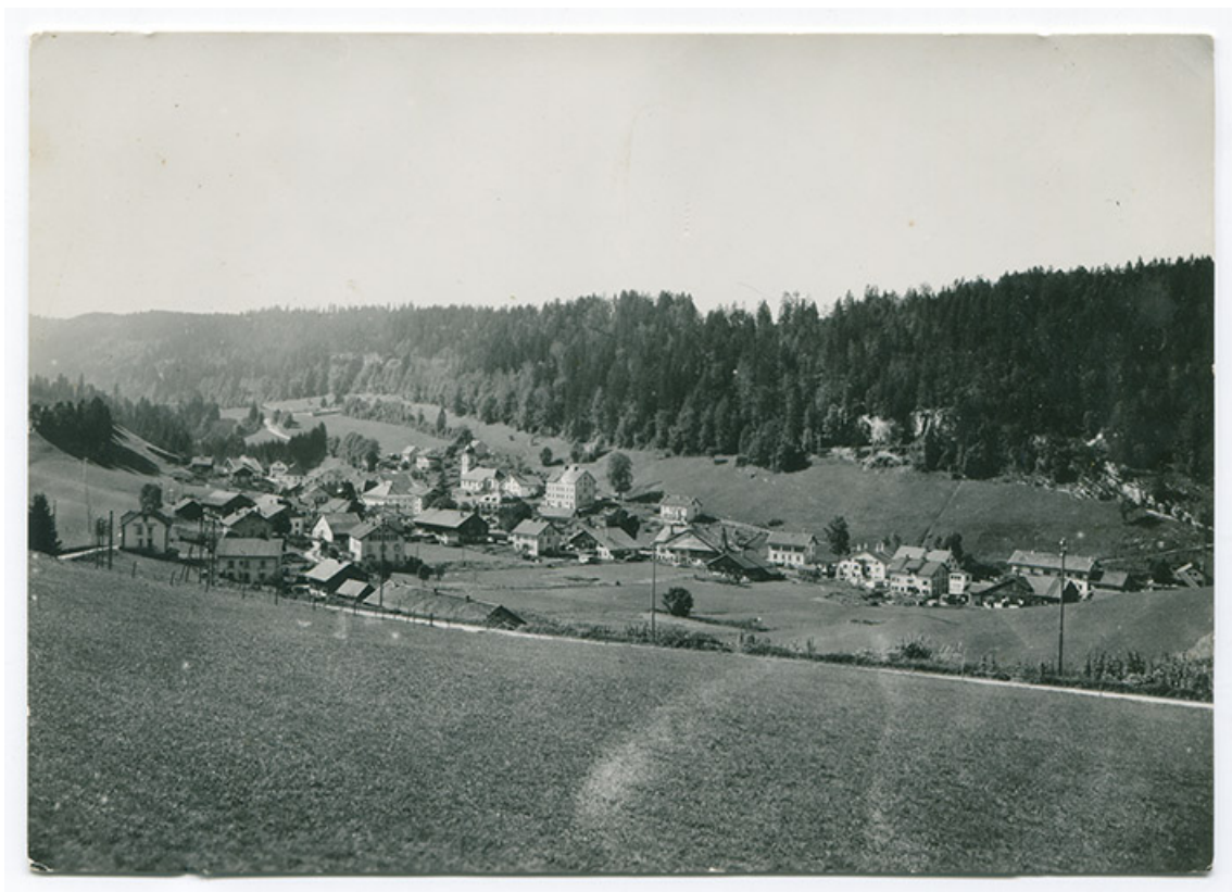
Paysages du Haut-Doubs - Les Gras [vue d'ensemble du village depuis l'est], 2e quart 20e siècle. La maison est visible à gauche. 25, Les Gras, 16 Grande Rue
