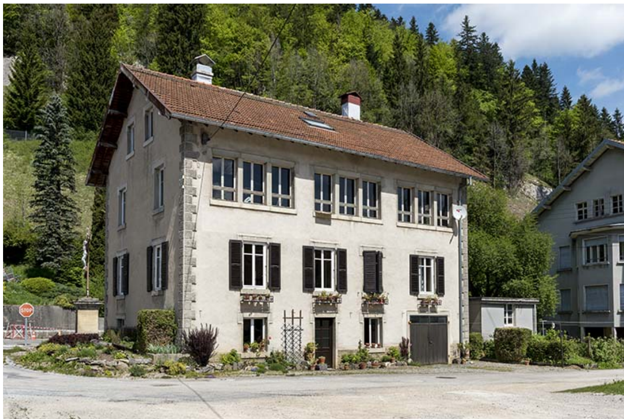
Un exemple de maison avec atelier incorporé : la fabrique de tournevis pour horlogers de Virgile Garnache-Barthod (1918-1922), au 16 Grande Rue.
