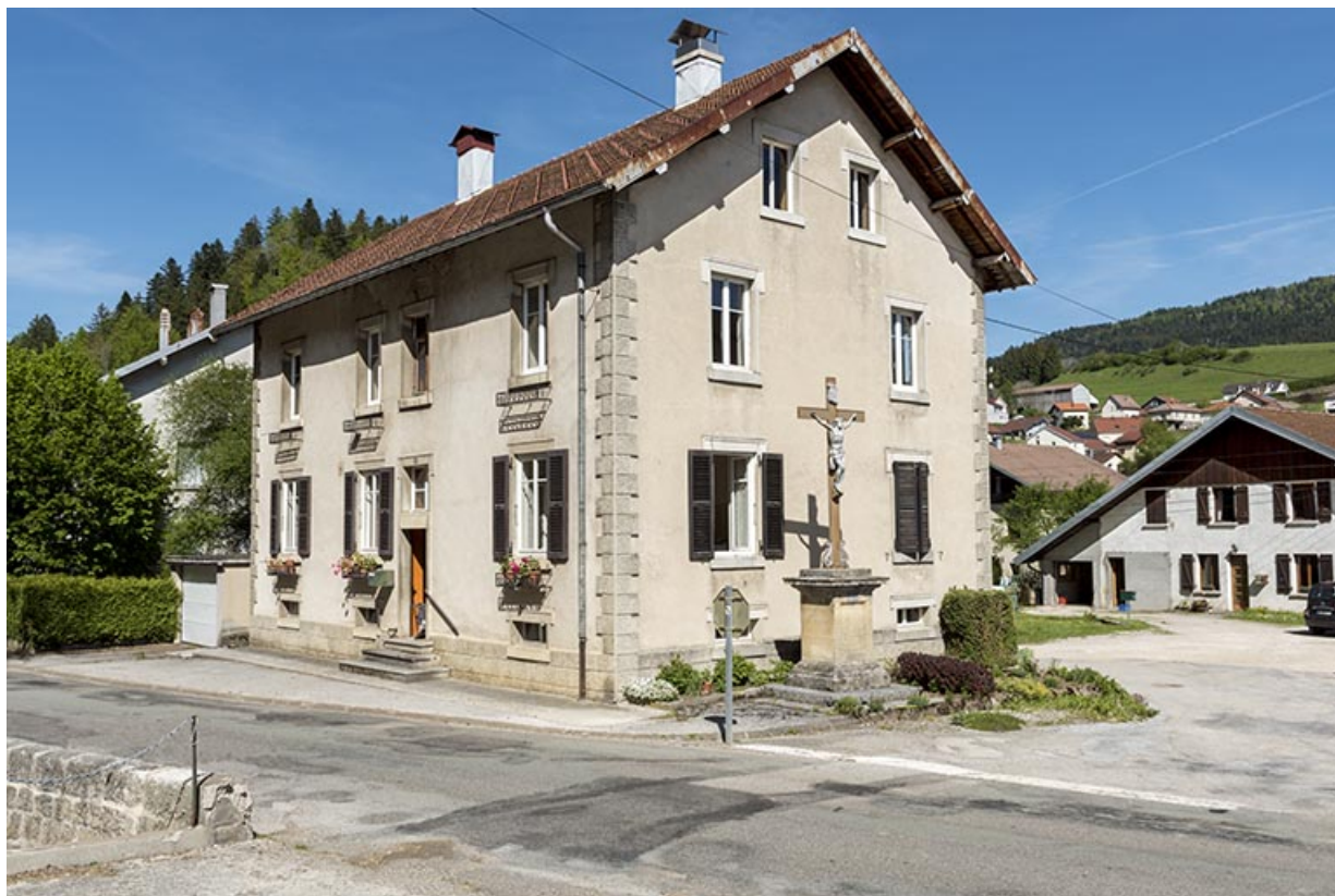
Façades antérieure et latérale droite.
