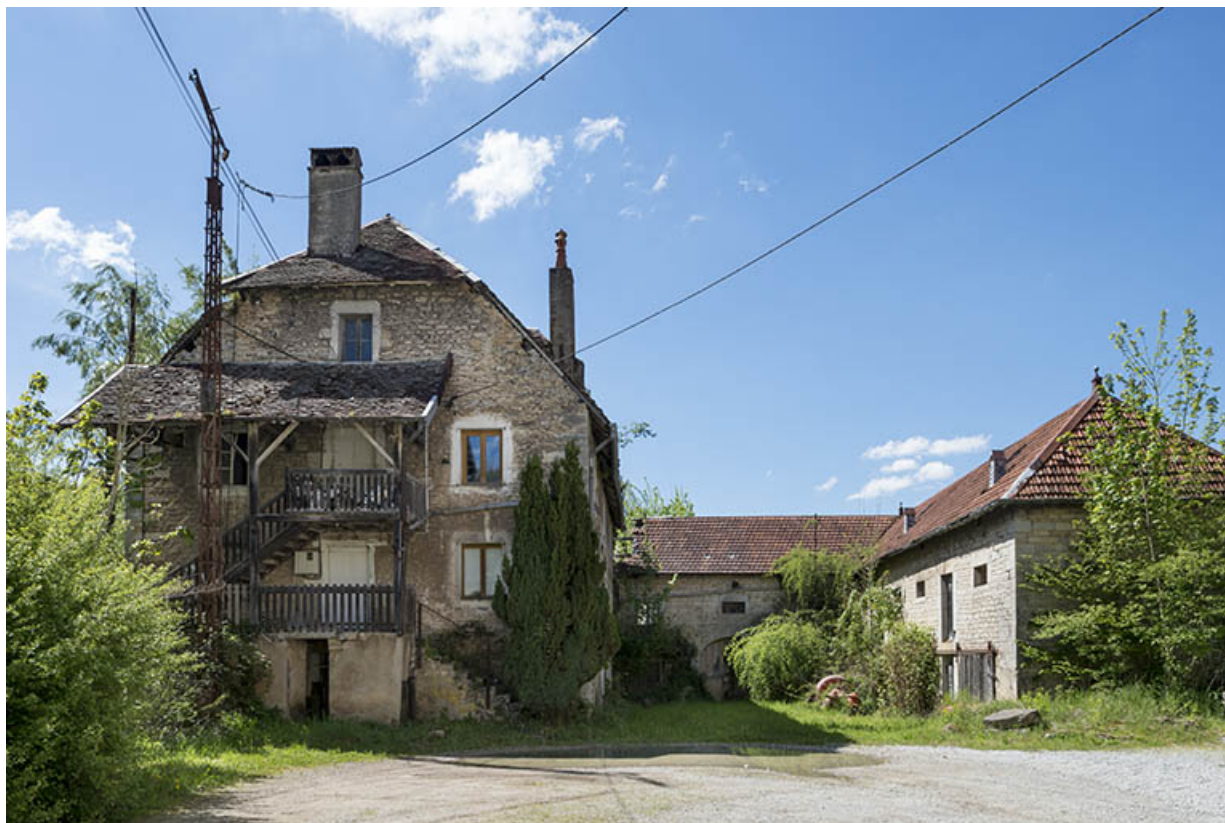
Bâtiments ouest : ancien moulin (puis logement ouvrier), écurie et remise. 25, Chenecey-Buillon chemin des Forges, lieudit : les Forges
