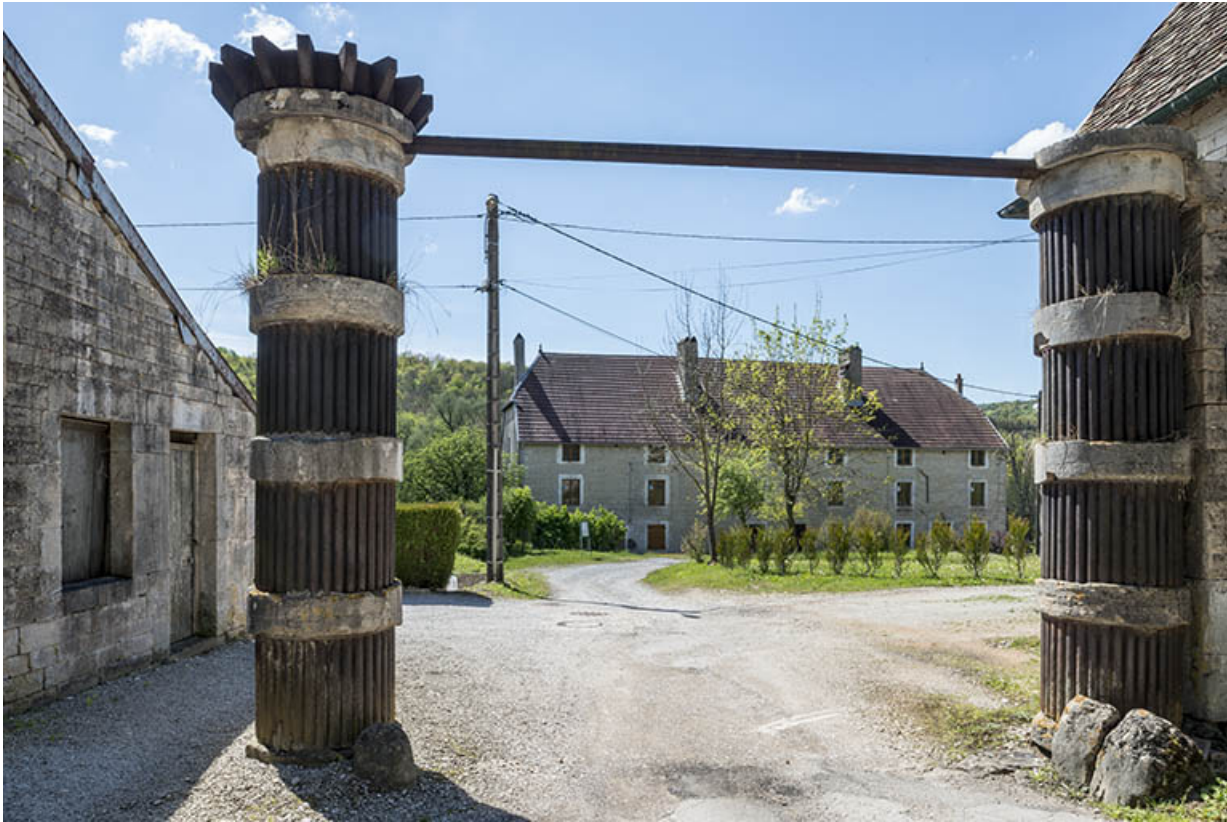
Portique d'entrée. Piliers fasciculés (pierre et fonte).
