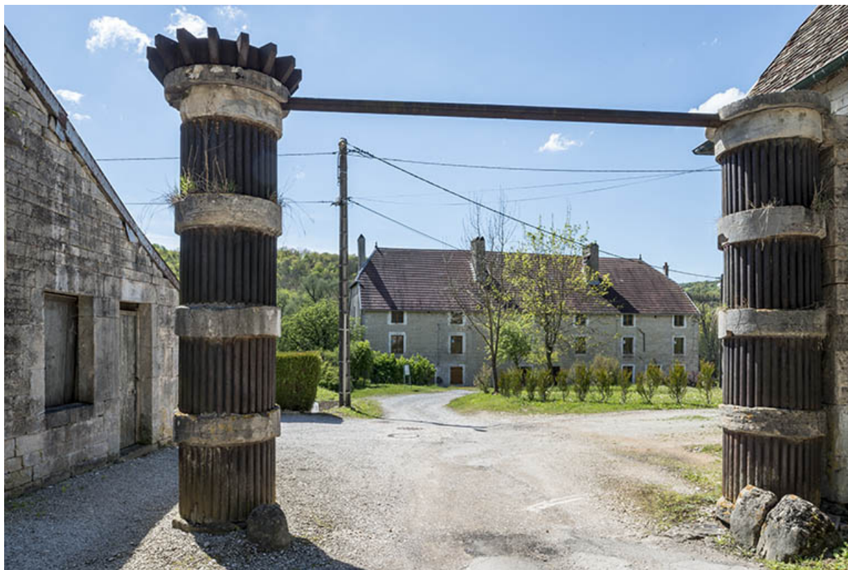
Portique d'entrée. Piliers fasciculés (pierre et fonte). 25, Chenecey-Buillon chemin des Forges, lieudit : les Forges
