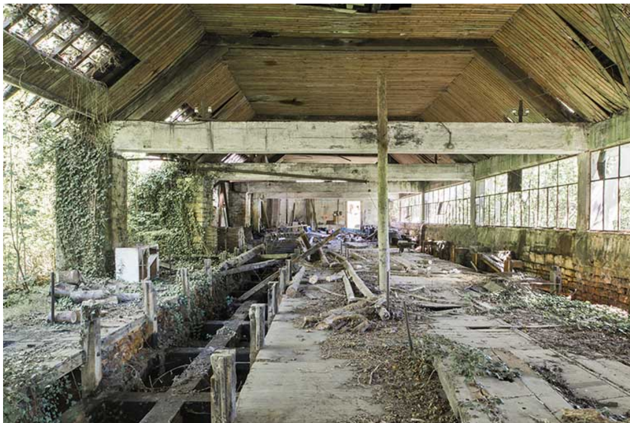
Atelier de tréfilerie. Vue intérieure depuis l'ouest.
