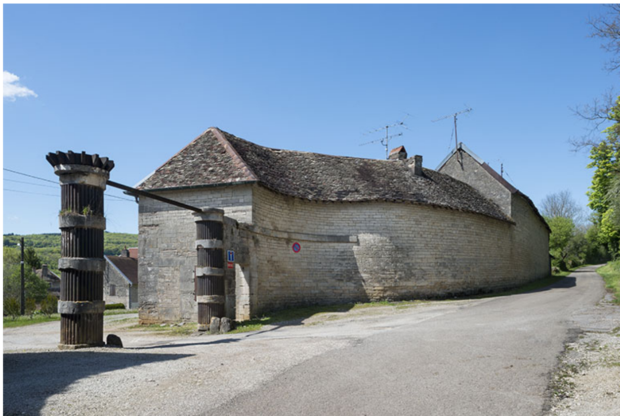
Entrée de l'usine et aile nord des logements ouvriers. 25, Chenecey-Buillon chemin des Forges, lieudit : les Forges
