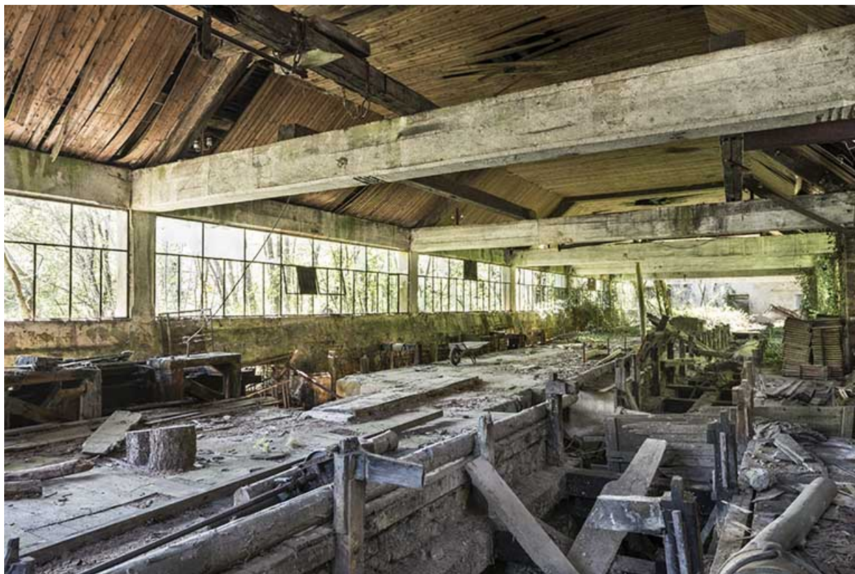
Atelier de tréfilerie. Vue intérieure depuis le nord-est.
