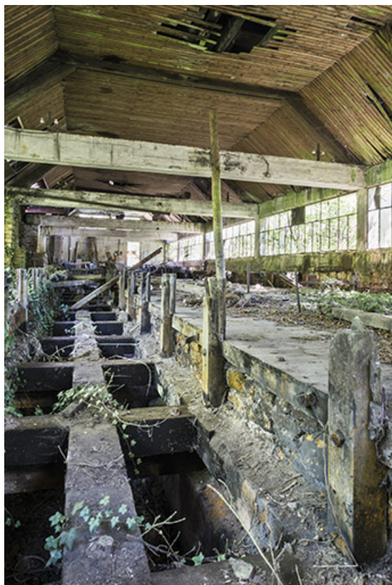
Atelier de tréfilerie. Vue intérieure depuis l'ouest (cadrage vertical). 25, Chenecey-Buillon chemin des Forges, lieudit : les Forges
