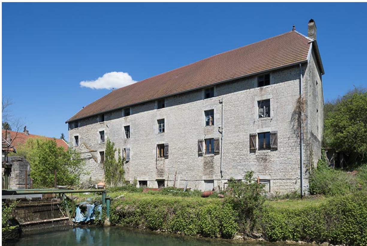
Logement ouvrier ouest. Façade sur le canal d'amenée.
