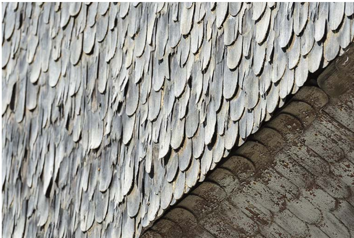
Façade postérieure : essentage de tavaillons. 25, Les Gras, 10-12 Grande Rue
