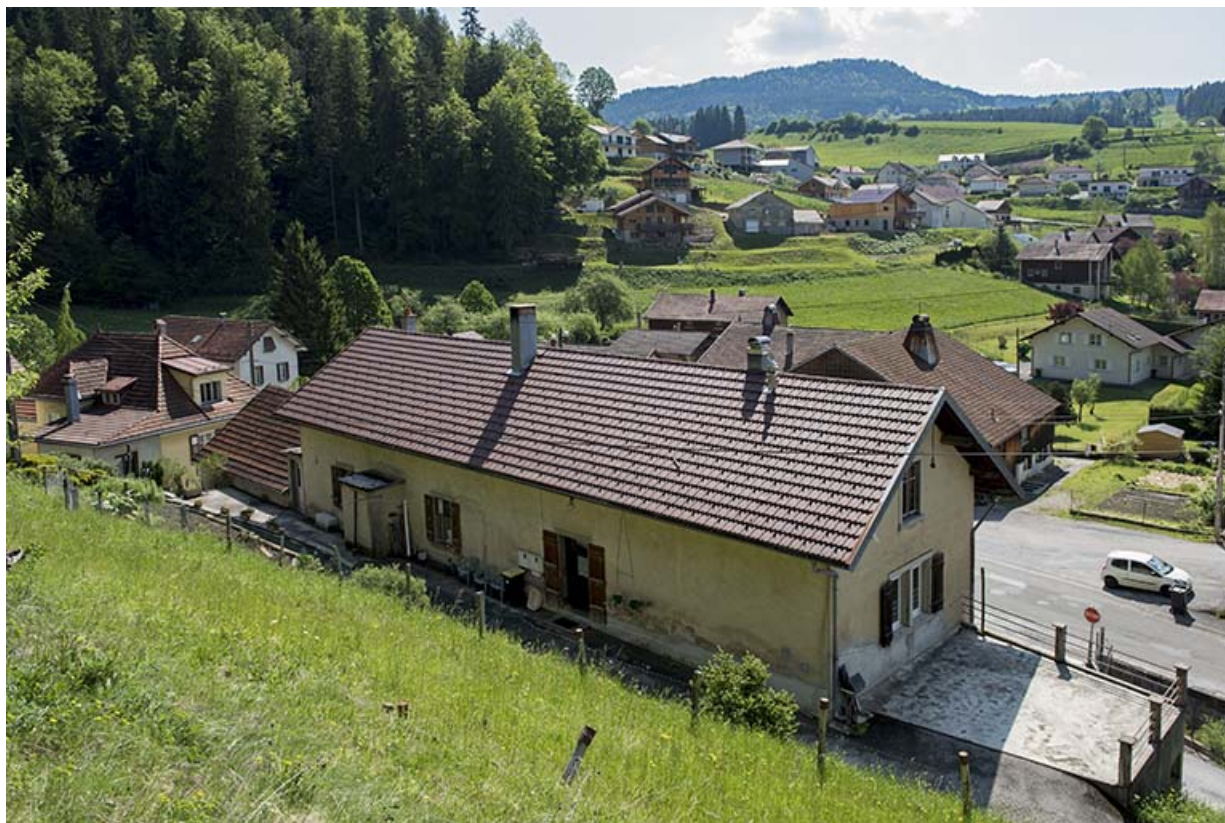
Vue plongeante sur la façade postérieure, de trois quarts droite.
