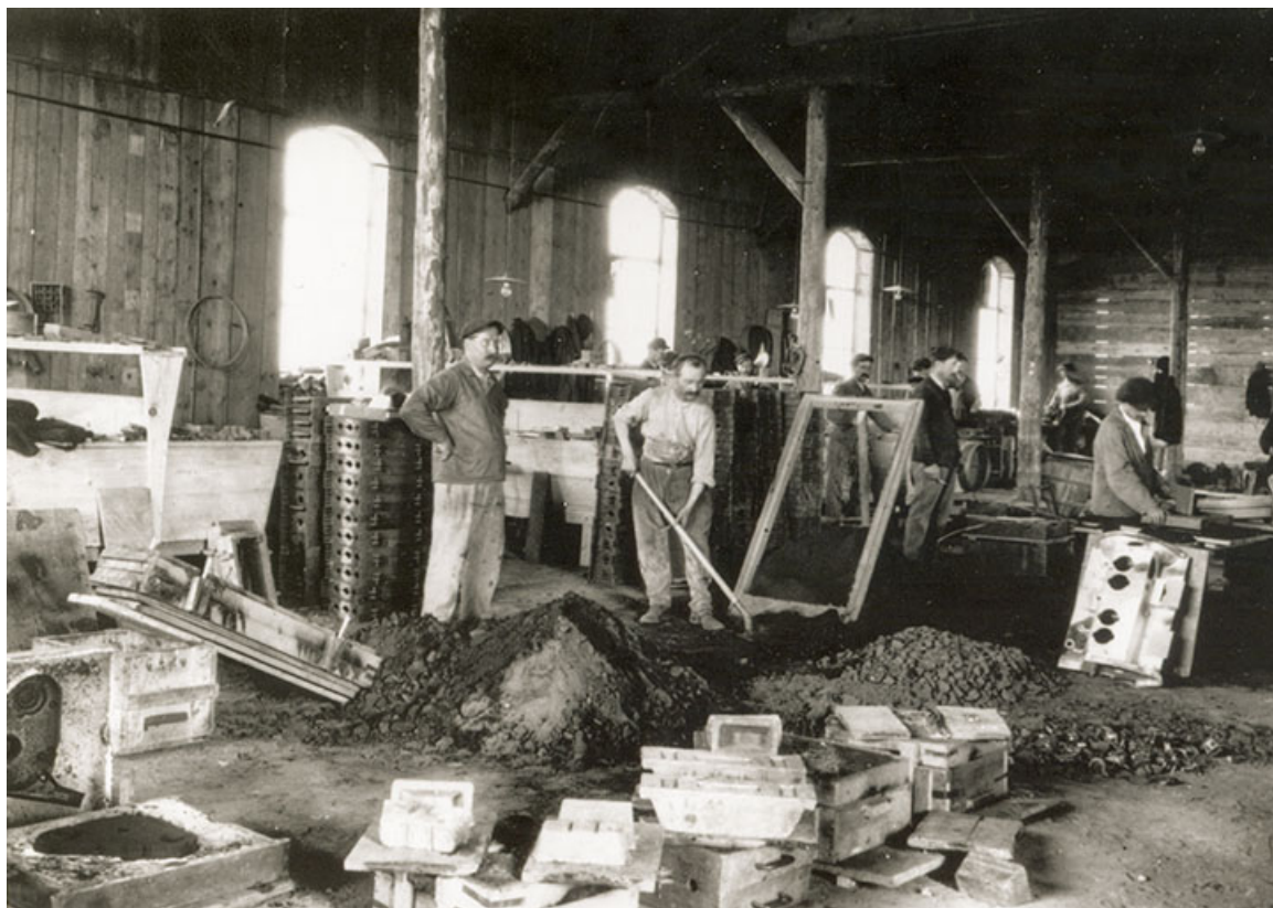
Atelier de fonderie, s.d. [début 20e siècle]. 25, Pontarlier, 3-5 rue de la Paix
