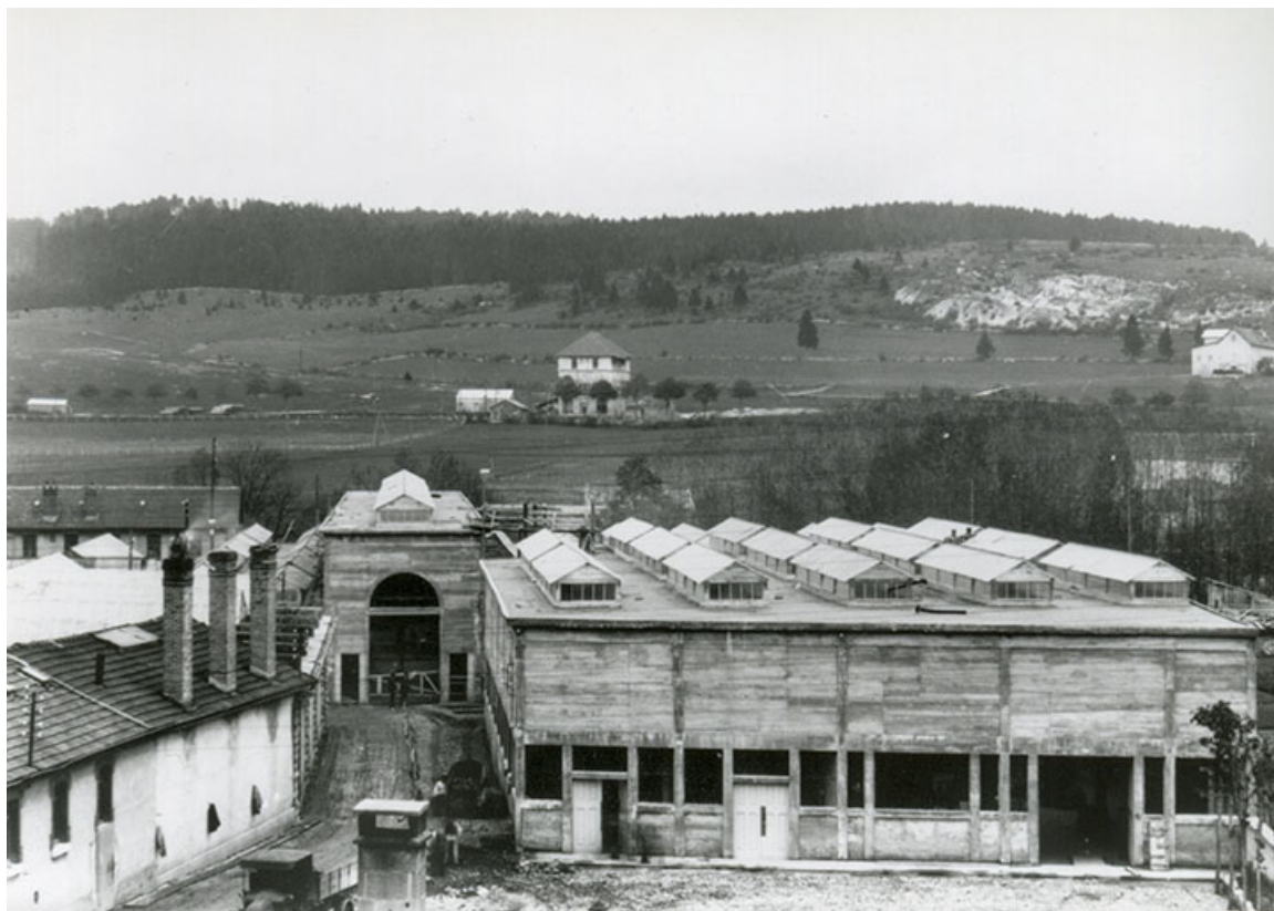
Vue plongeante sur l'atelier sud, phot. Stainacre, s.d. [début 20e siècle]. 25, Pontarlier, 3-5 rue de la Paix
