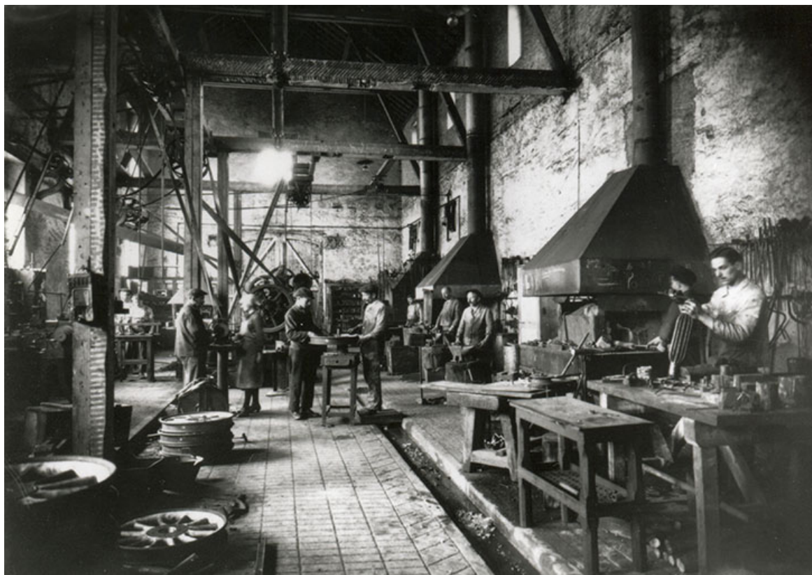
Atelier de forge (montage des moyeux ?), phot. Stainacre, s.d. [début 20e siècle]. 25, Pontarlier, 3-5 rue de la Paix
