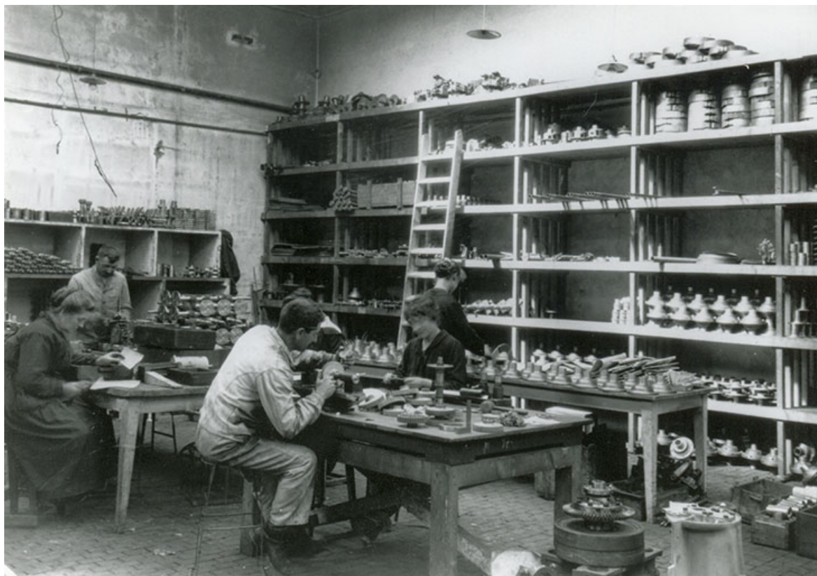
Magasin de pièces mécaniques, phot. Stainacre, s.d. [début 20e siècle]. 25, Pontarlier, 3-5 rue de la Paix
