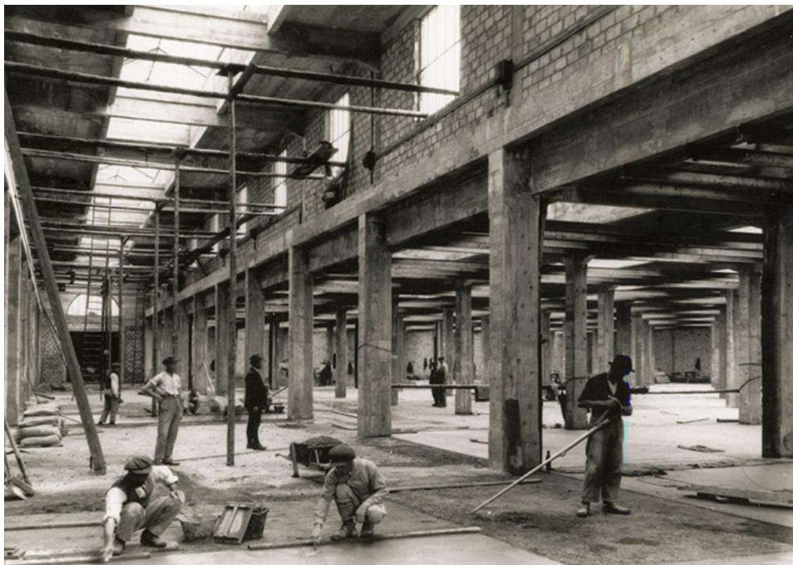
Construction de l'atelier de fabrication, phot. Stainacre, s.d. [début 20e siècle]. 25, Pontarlier, 3-5 rue de la Paix
