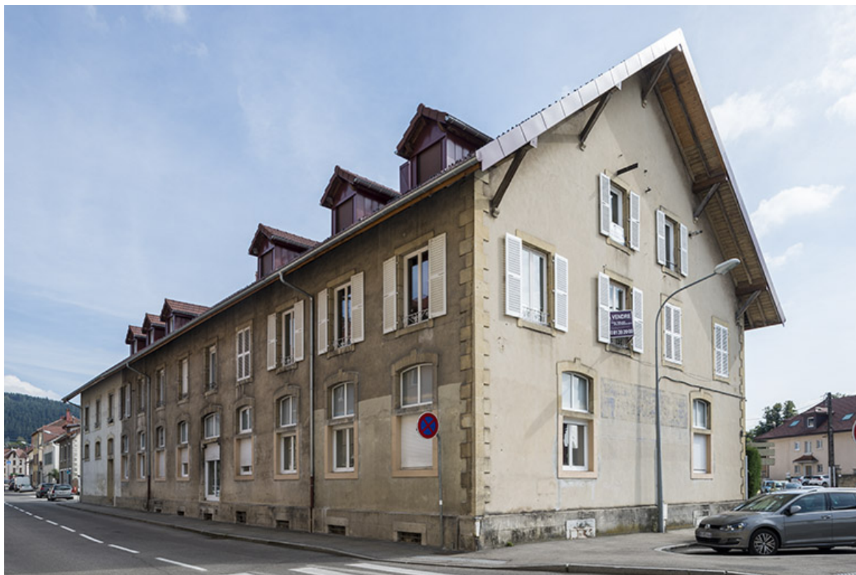
Façade nord et pignon ouest.
