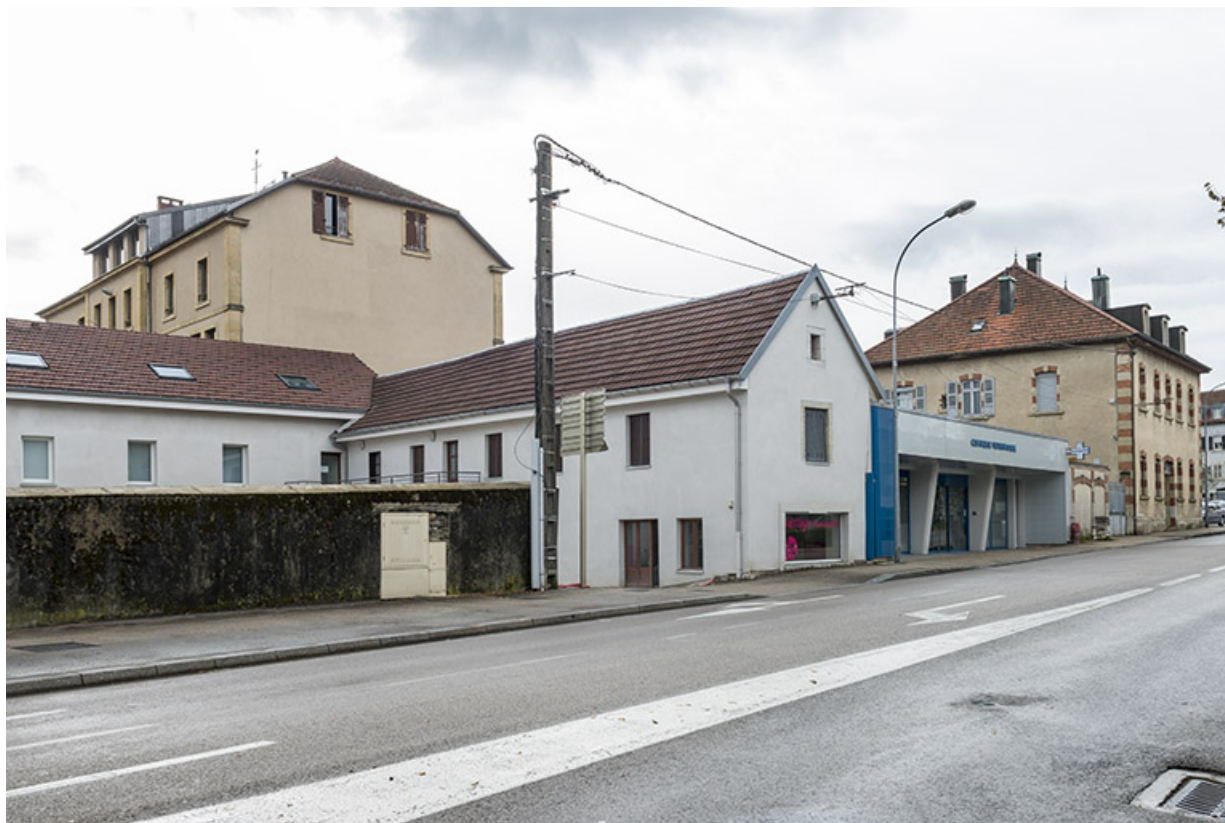
Vue d'ensemble depuis la rue du Mont.
