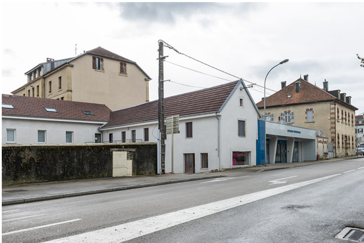
Vue d'ensemble depuis la rue du Mont.
