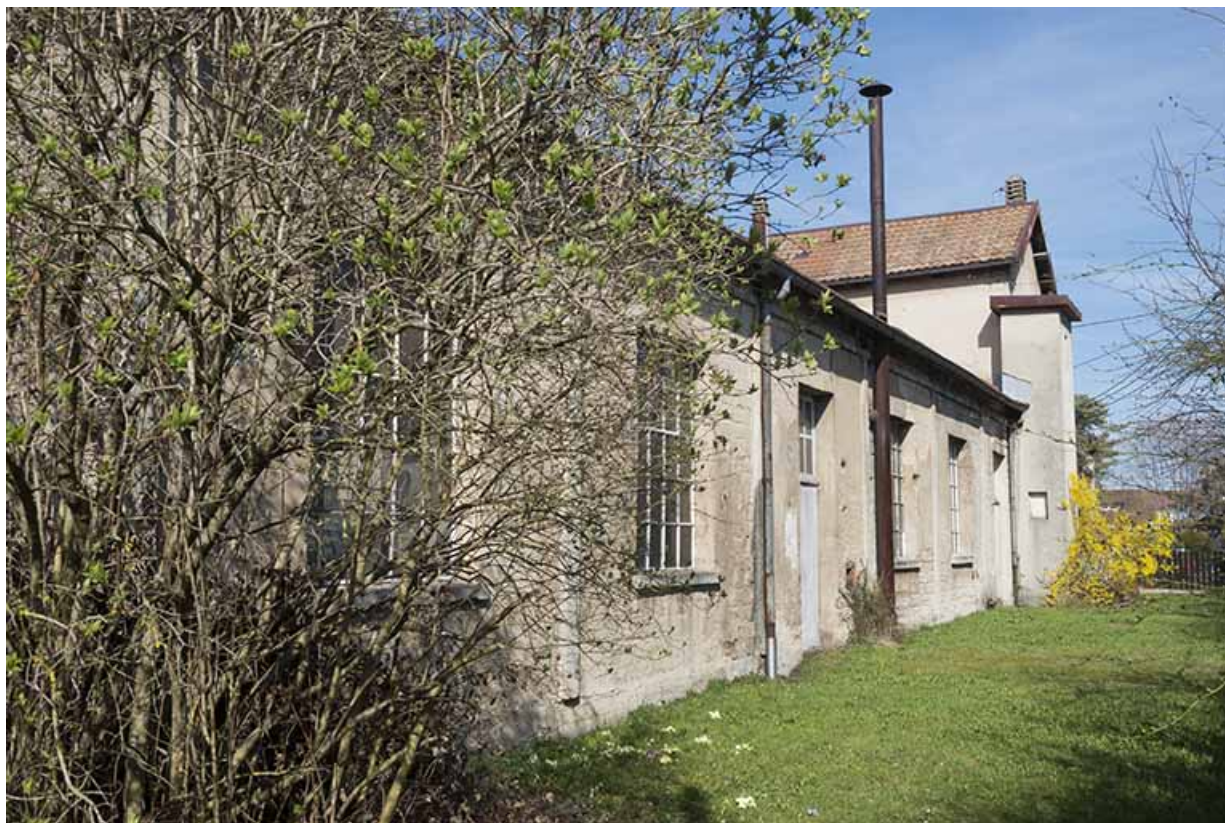
Façade est de l'atelier.
