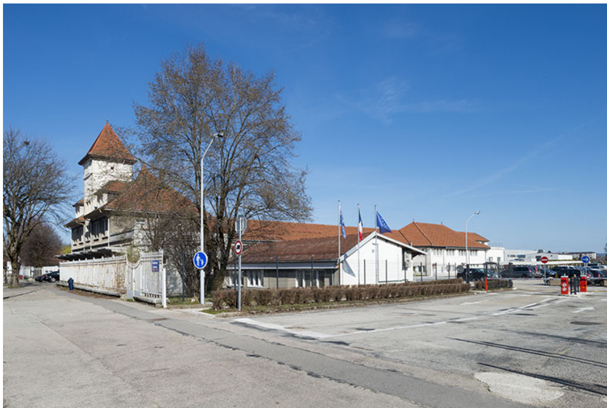
Vue d'ensemble depuis le sud.
