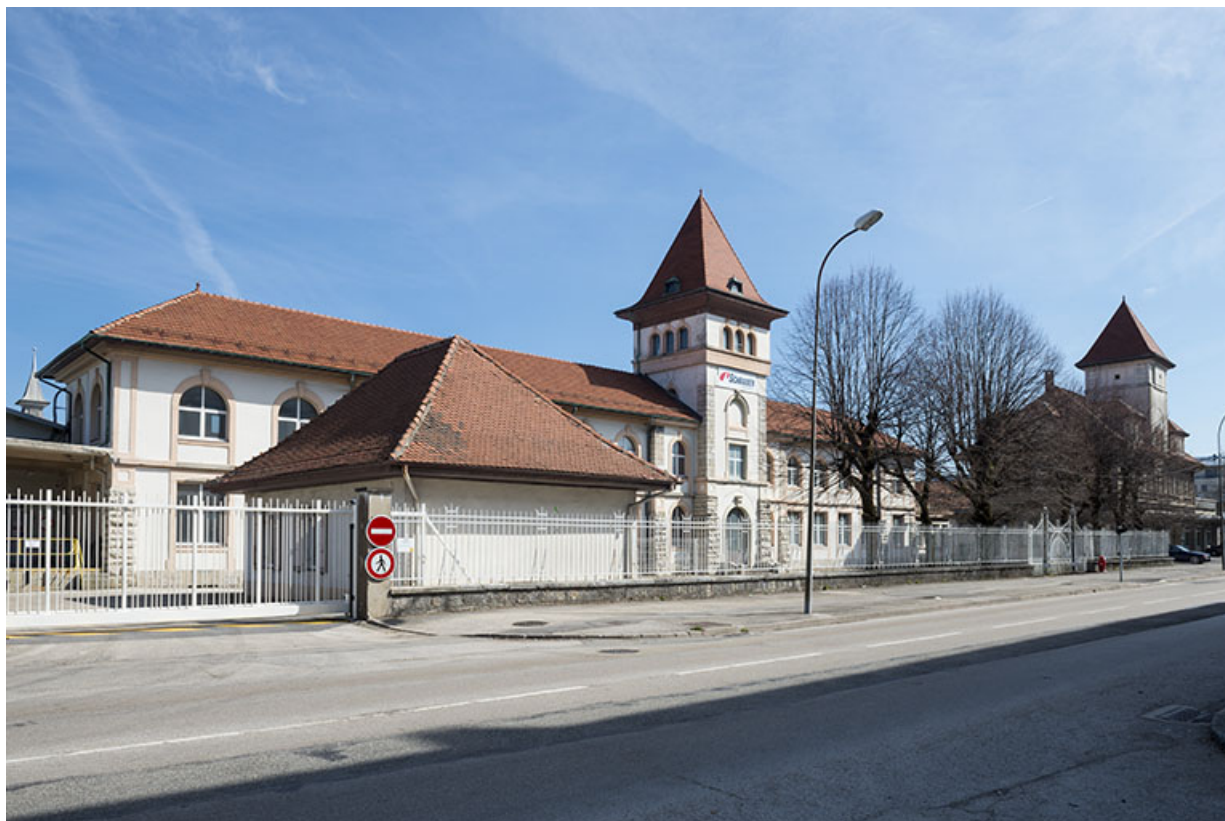
Bâtiments d'entrée, depuis l'ouest.
