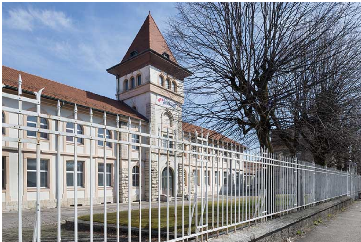
Façade sud du bâtiment administratif, vue de trois quarts gauche.
