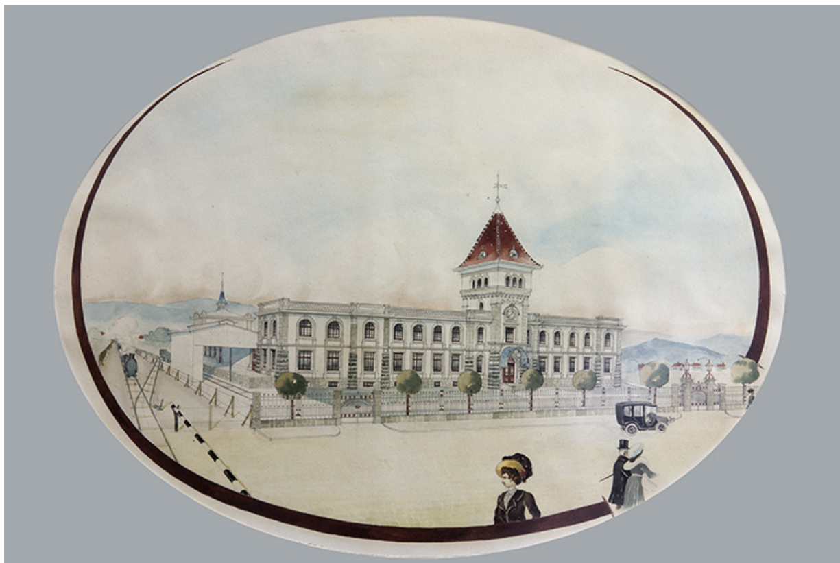
Vue de l'usine, aquarelle, s.d. [début 20e siècle]. 25, Pontarlier, 48 rue de Salins
