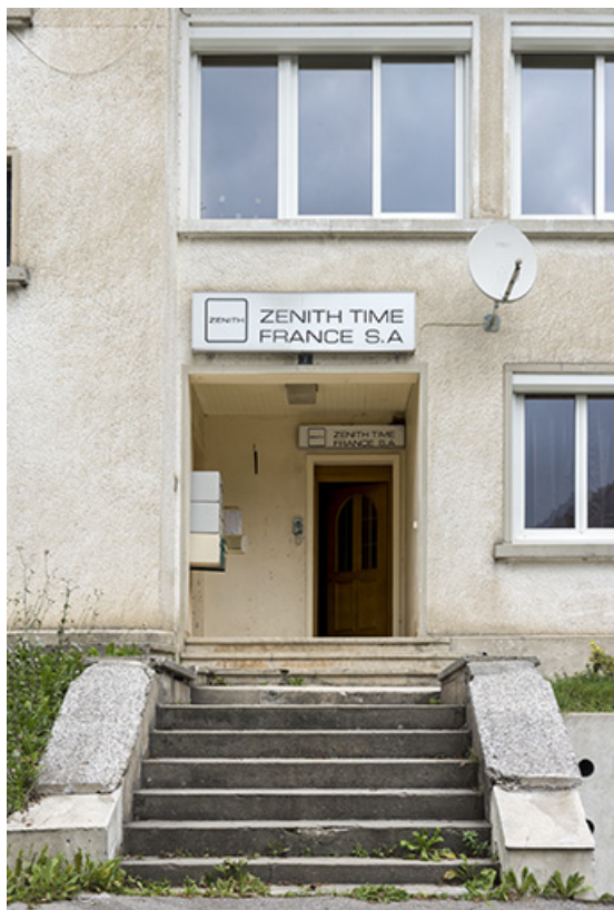
Façade antérieure : entrée de l'atelier de fabrication. 25, Villers-le-Lac, 1 rue du Stade
