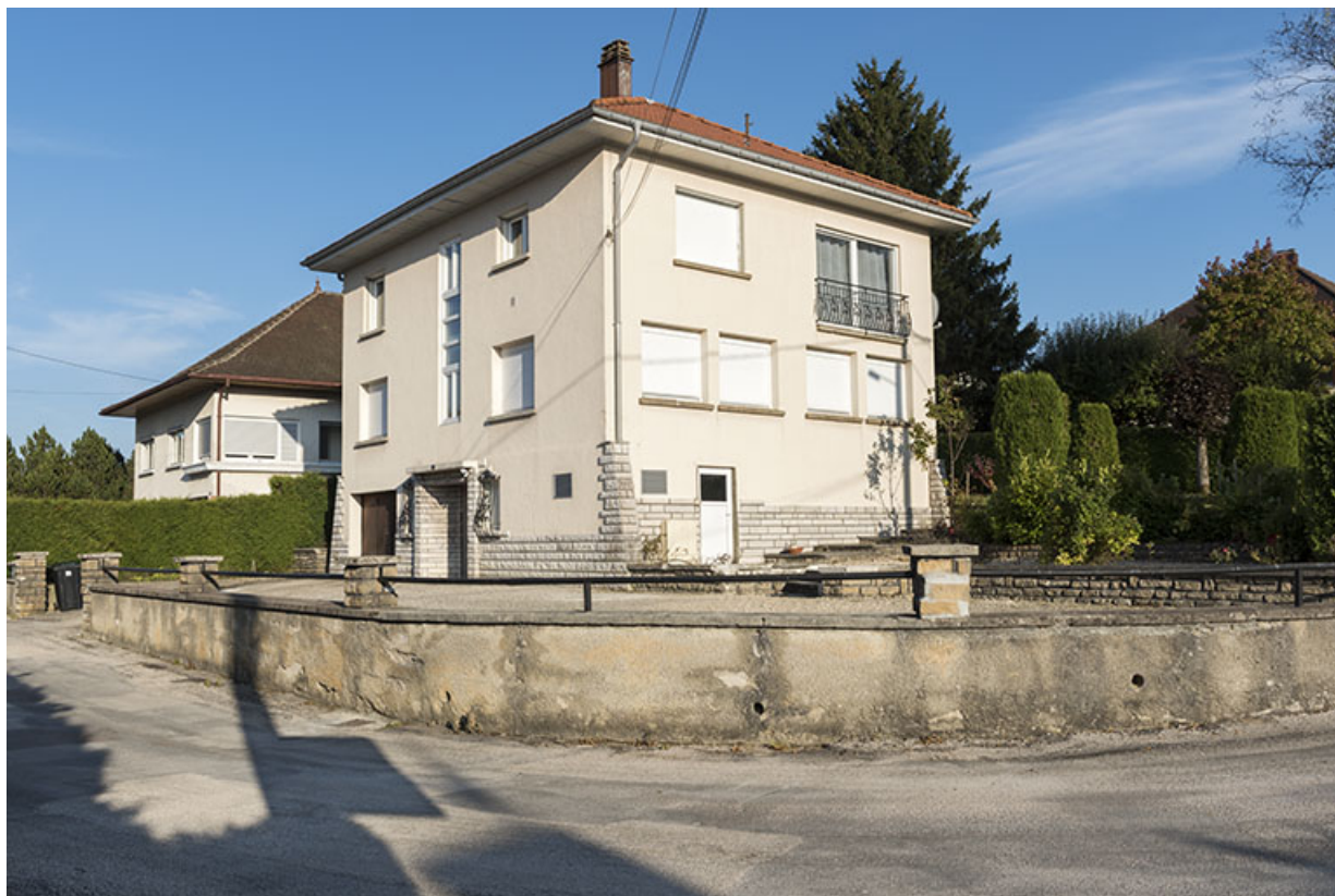
Vue d'ensemble (façades antérieure et latérale droite).
