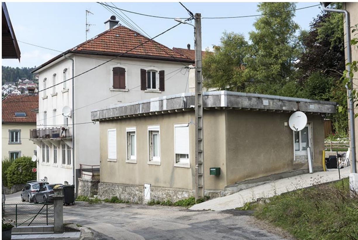
Vue d'ensemble, depuis l'est (façades antérieure et latérale droite de l'atelier). 25, Villers-le-Lac, 5 rue de la Gare
