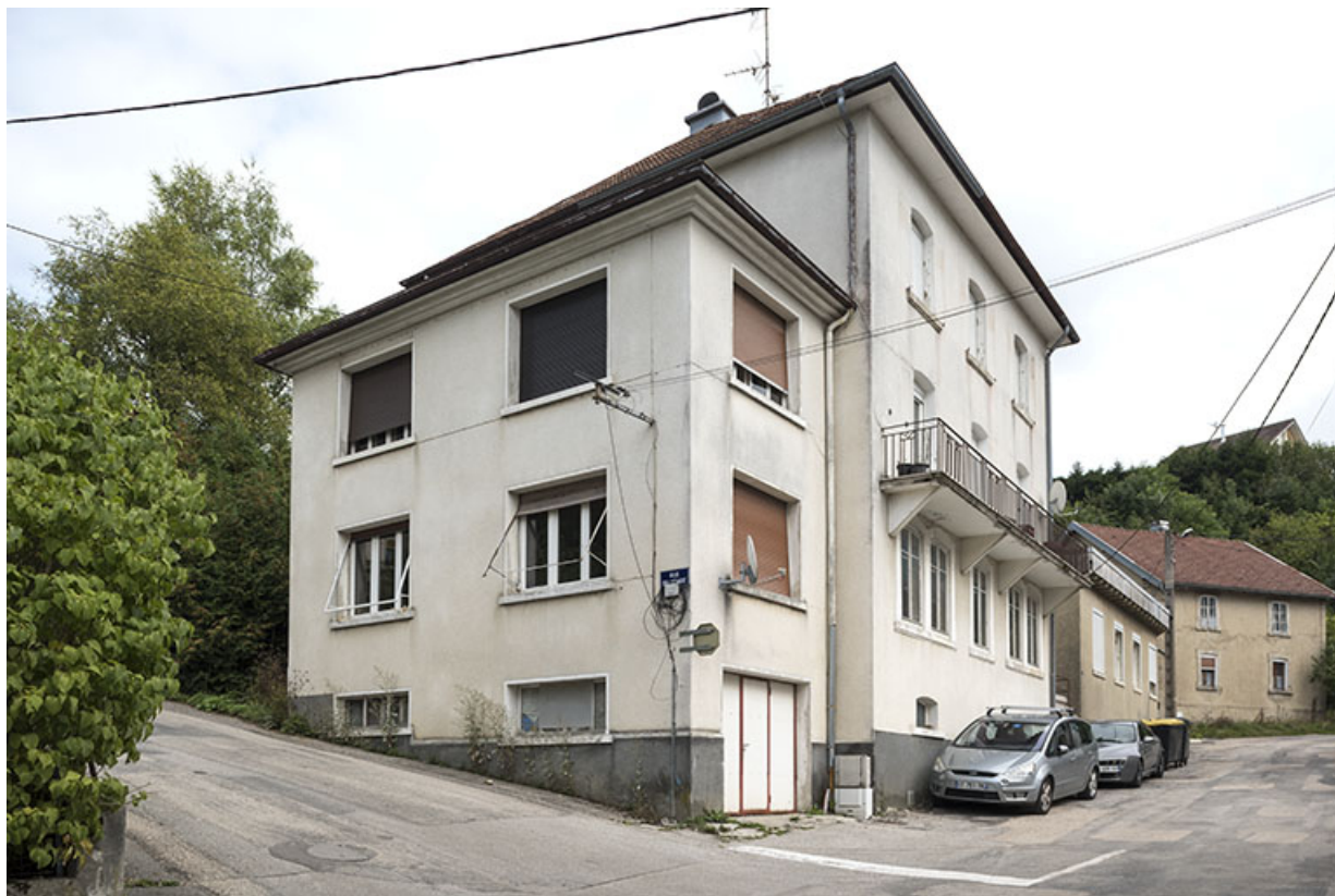
Vue d'ensemble, depuis l'ouest (façades antérieure et latérale gauche de la maison). 25, Villers-le-Lac, 5 rue de la Gare
