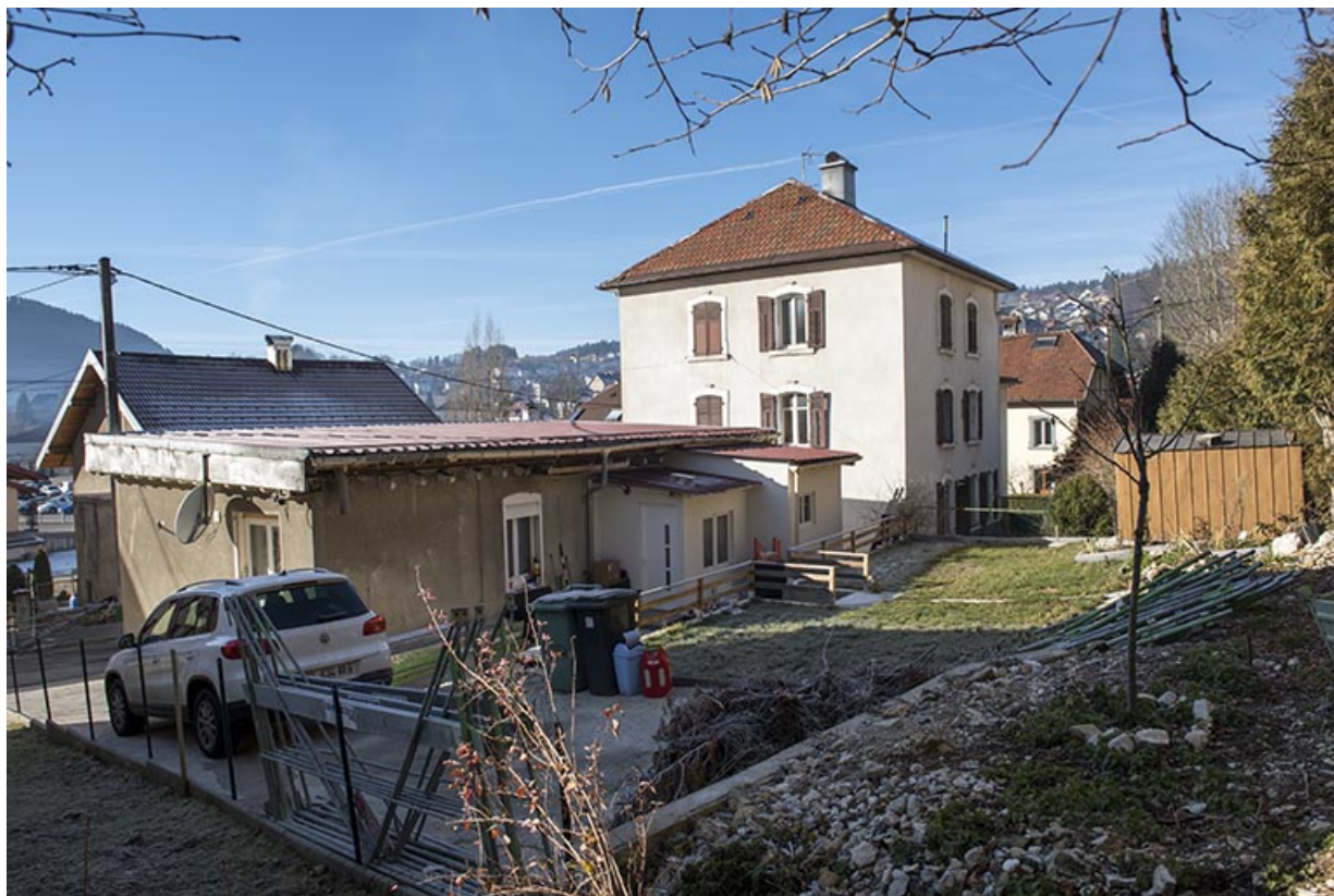
Vue d'ensemble, depuis le nord-est (façades postérieures et latérales droites). 25, Villers-le-Lac, 5 rue de la Gare
