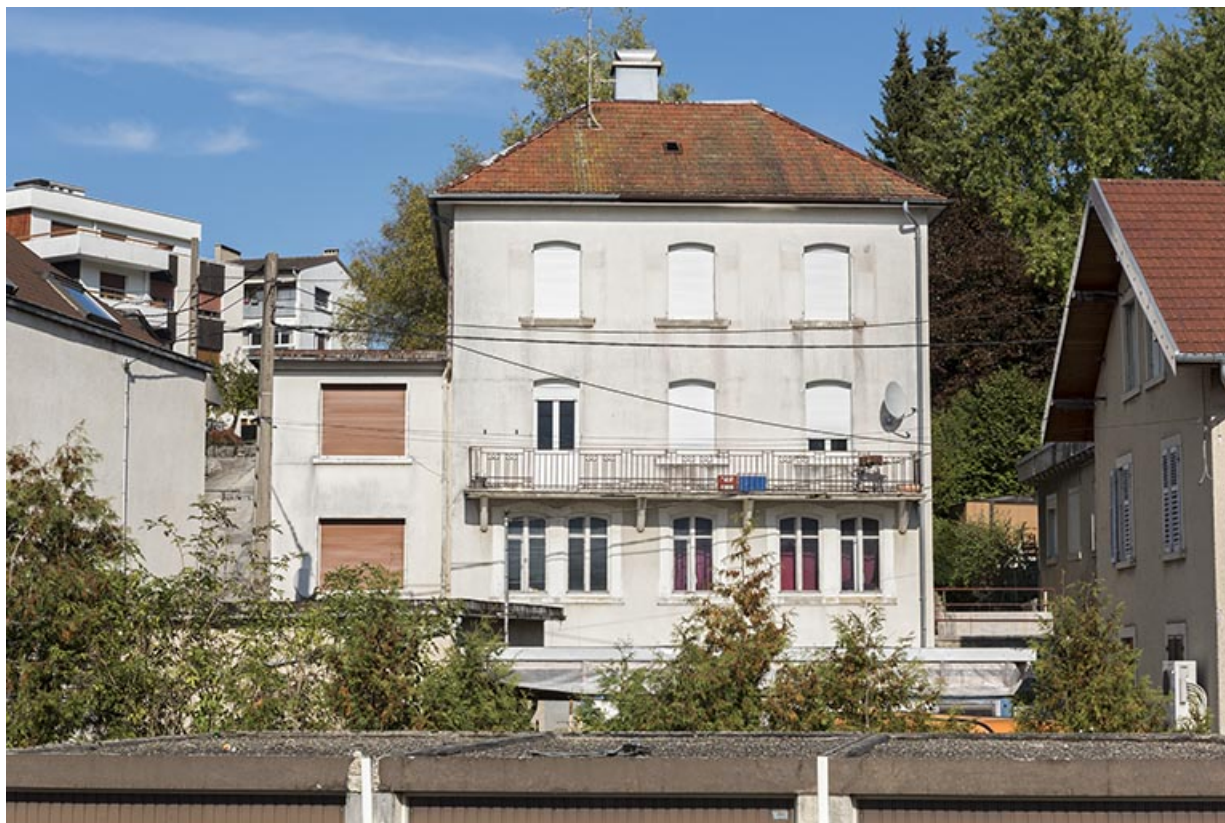
Maison : façade antérieure.
