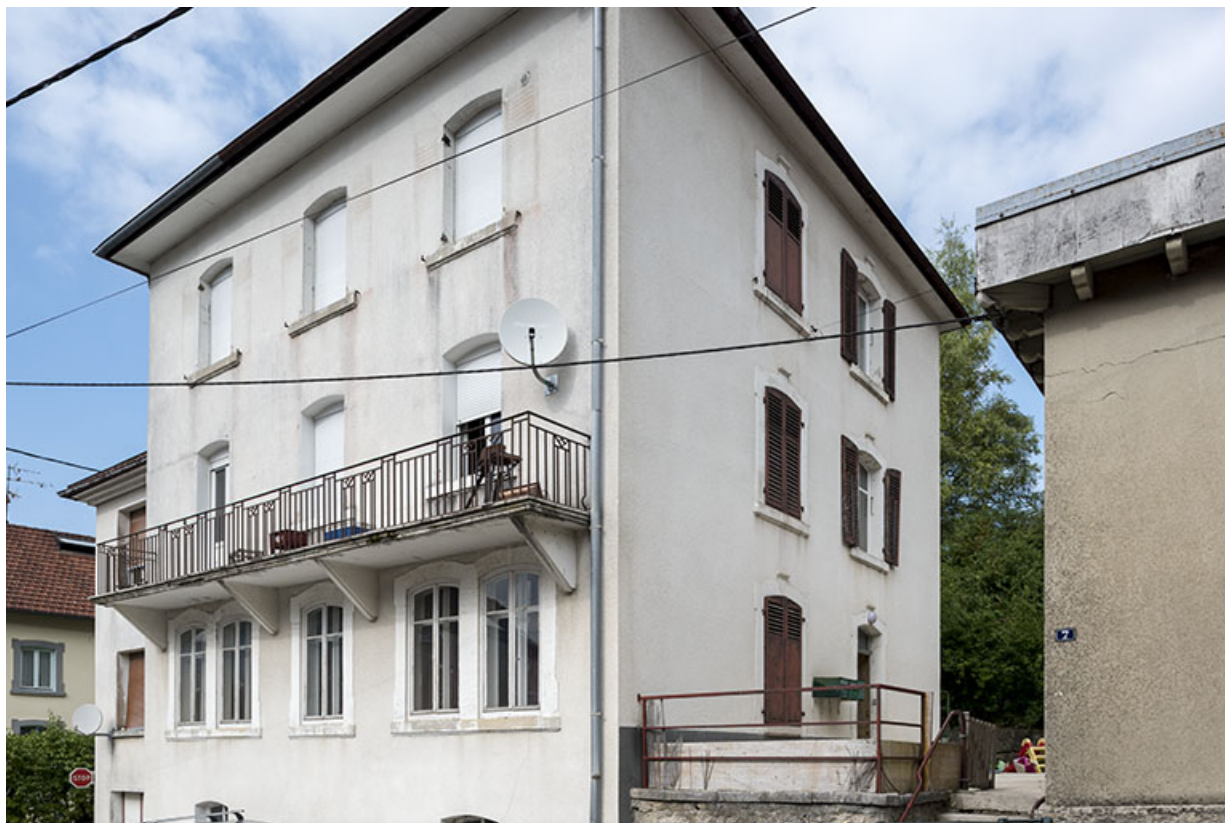
Maison : façades antérieure et latérale droite.
