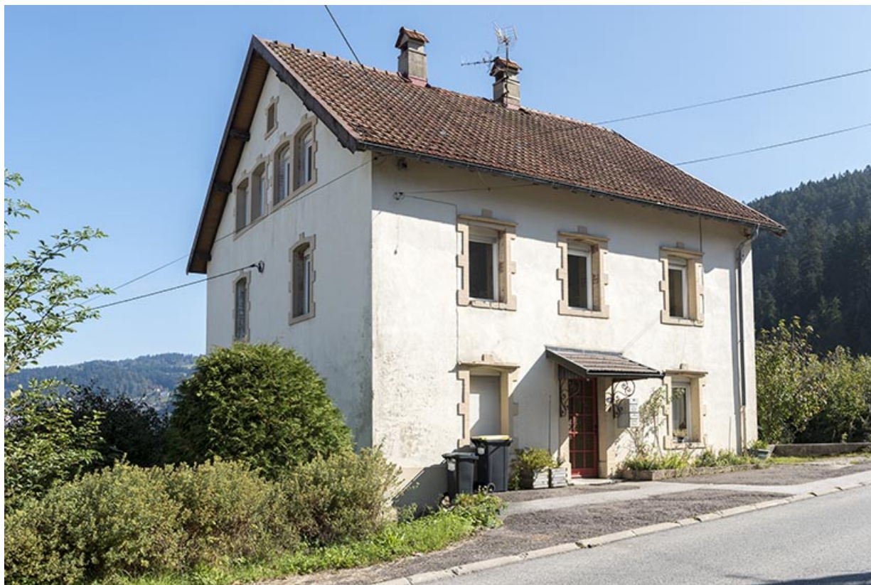
Façades antérieure et latérale gauche. Noter les baies horlogères à l'étage en surcroît. 25, Villers-le-Lac
