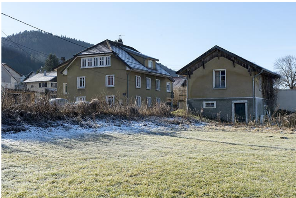
Vue d'ensemble, depuis le nord-est (maison et atelier à gauche, bûcher à droite).
