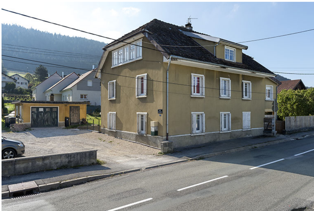
Façades antérieure et latérale gauche (garages à gauche). 25, Villers-le-Lac, 2 rue des Vieux Pargots, lieudit : les Pargots
