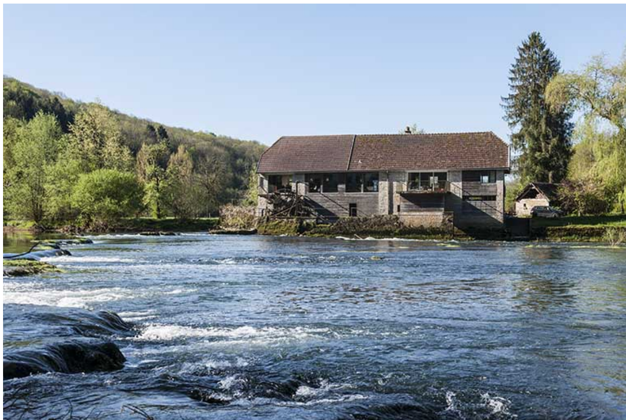
Façade nord du moulin, depuis la rive droite. 25, Chenecey-Buillon, 4 chemin du Moulin
