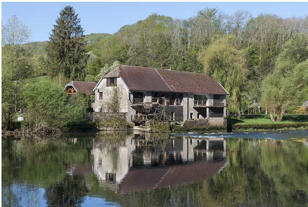
Vue de trois quarts depuis la rive droite.
