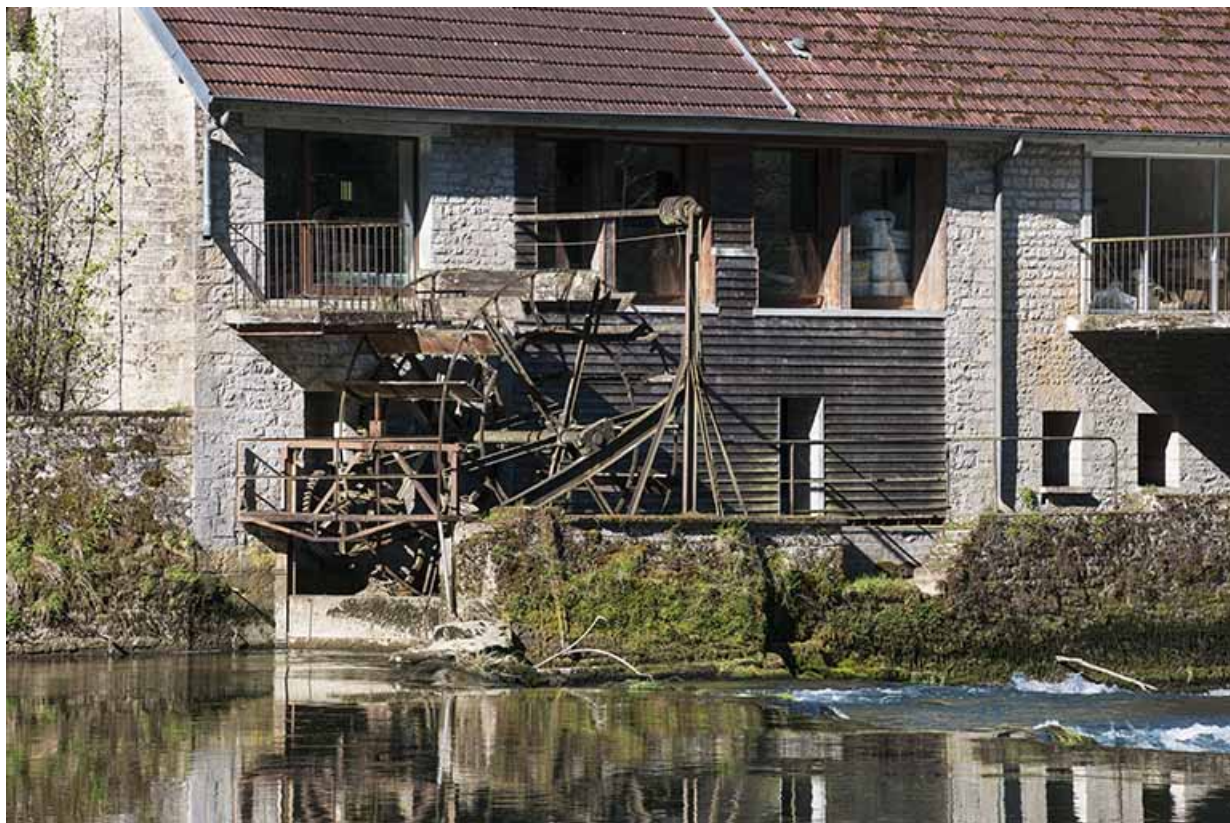
La roue suspendue vue de trois quarts. 25, Chenecey-Buillon, 4 chemin du Moulin
