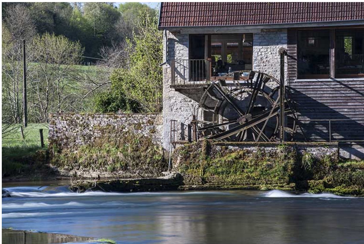
Roue suspendue amont, depuis la rive droite.
