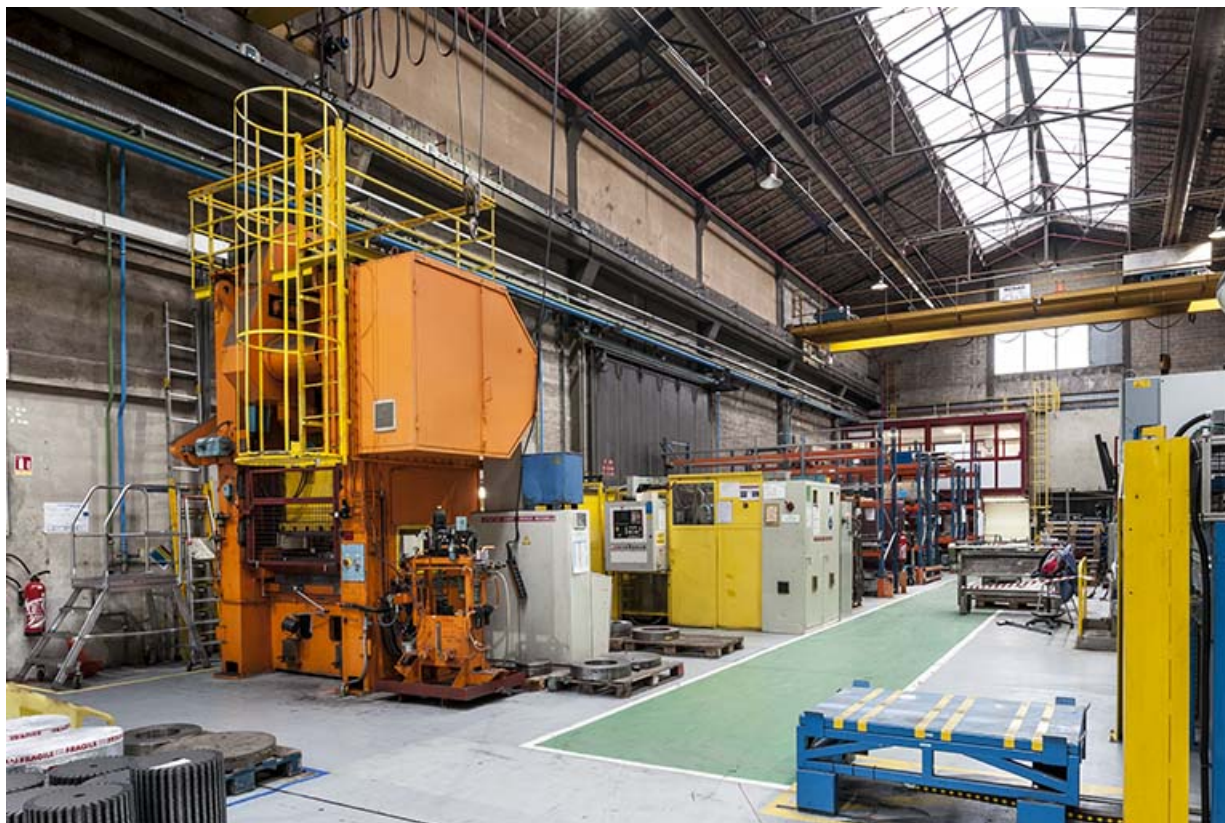
Partie est de l'atelier de tôlerie (ancien hall d'expédition). 25, Ornans, 7 avenue du maréchal de Lattre de Tassigny
