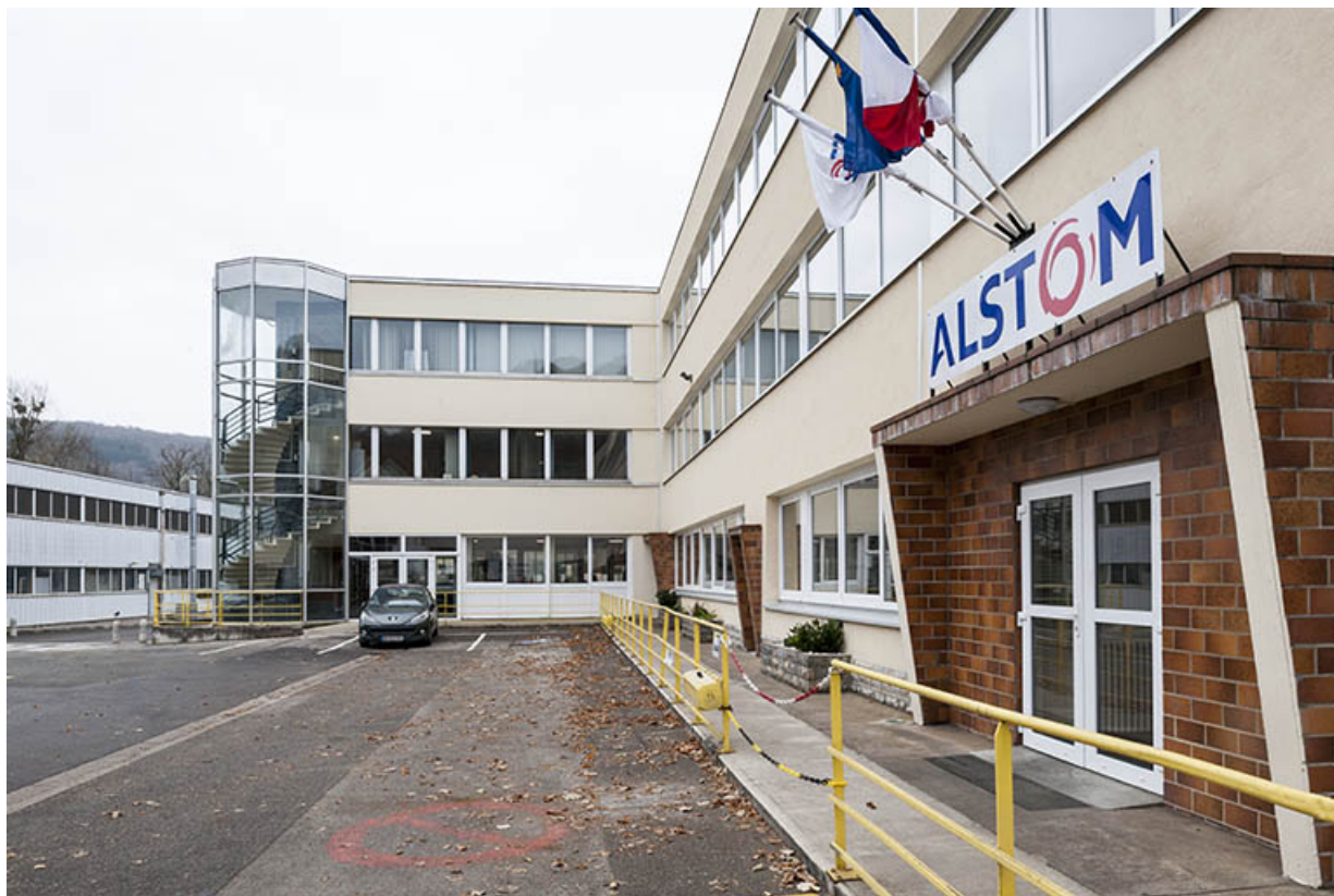
Façade nord et est du bâtiment de bureaux.
