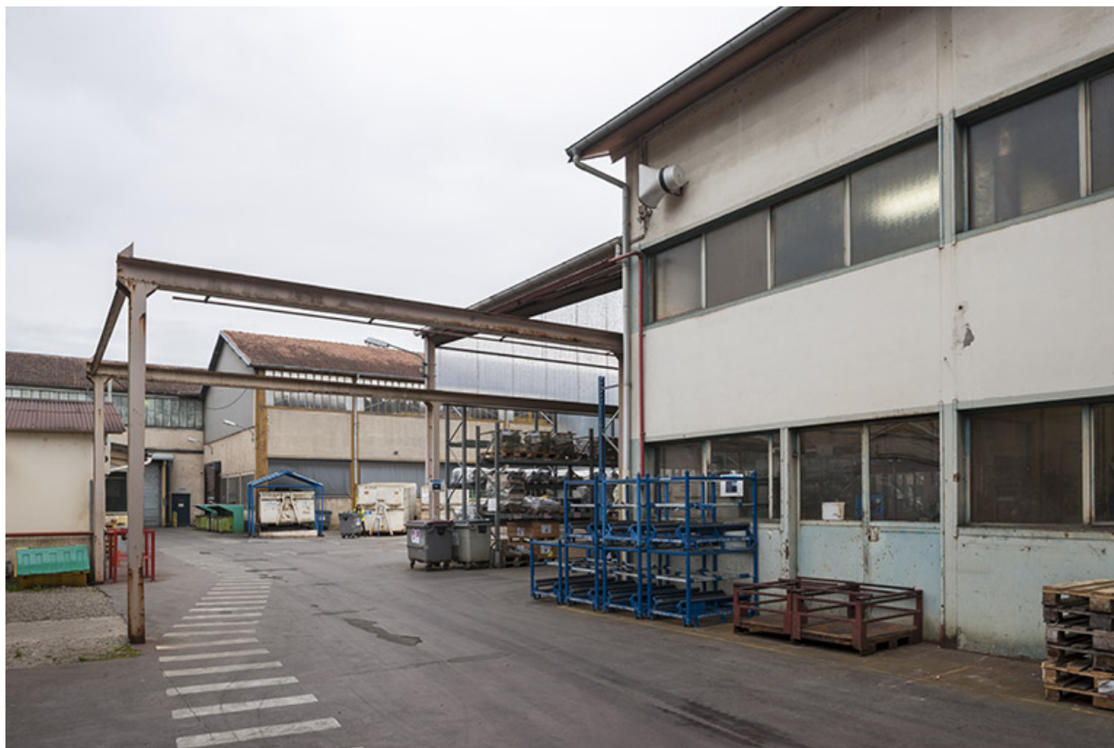
Vue de la cour depuis l'atelier de tôlerie.
