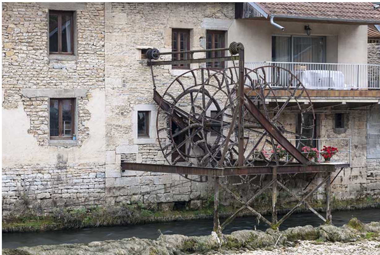
Façade sur la Loue. Roue pendante vue de trois quarts.
