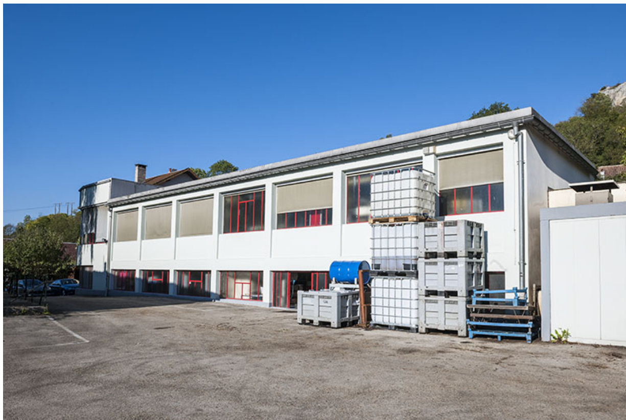
Façade est de l'atelier de fabrication.
