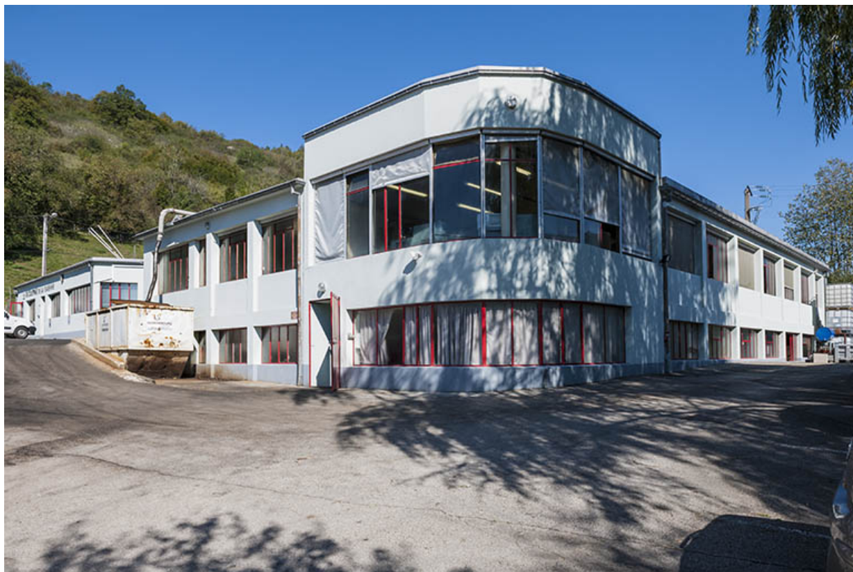
Atelier de fabrication vu depuis le sud.
