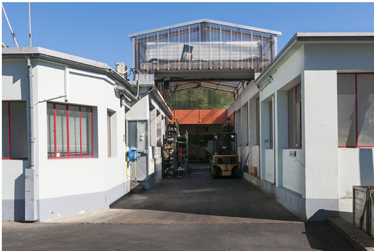
Passage couvert d'entre l'atelier original et son extension (à droite). 25, Ornans, 6 rue de la Garenne
