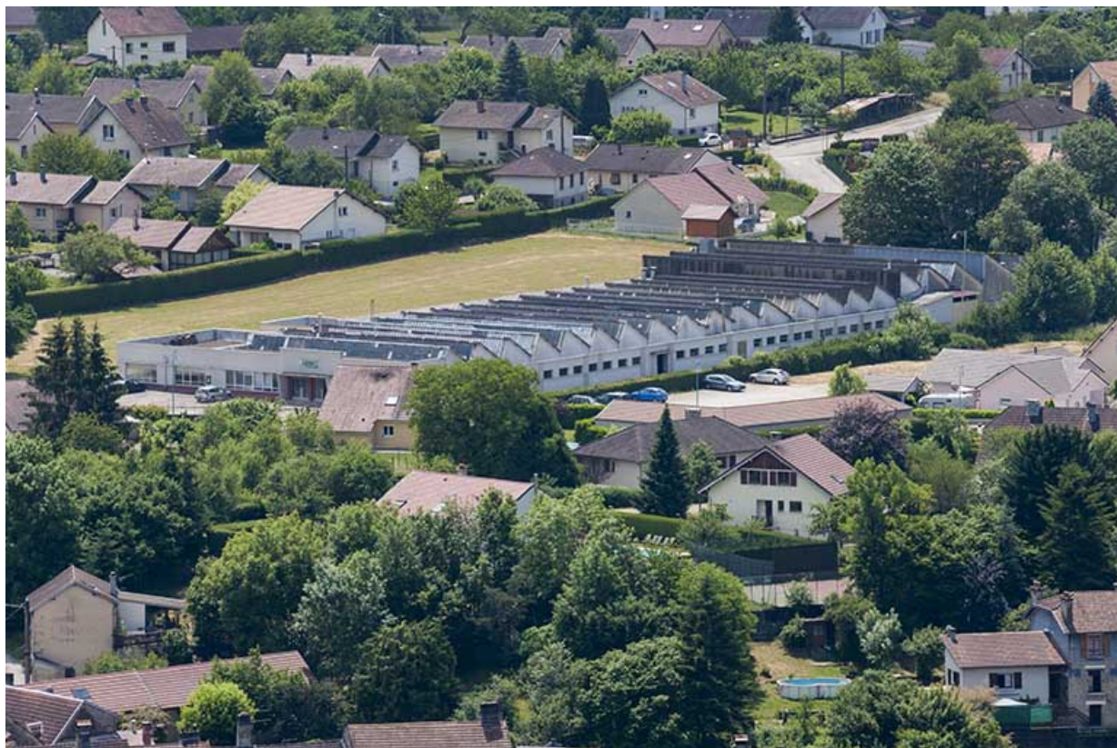
Vue plongeante depuis le nord-ouest.
