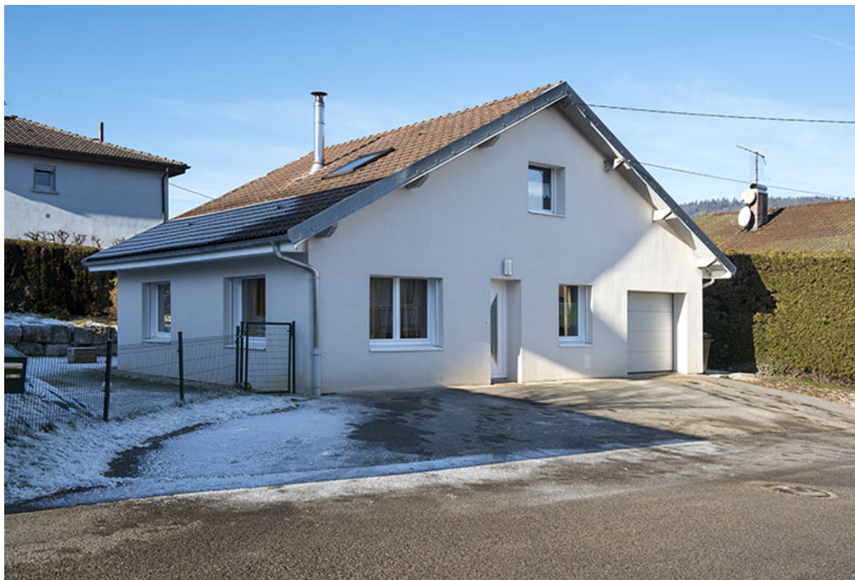
Façades antérieure et latérale gauche.
