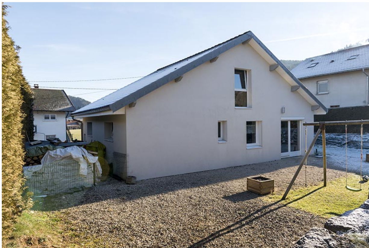
Façades postérieure et latérale droite.
