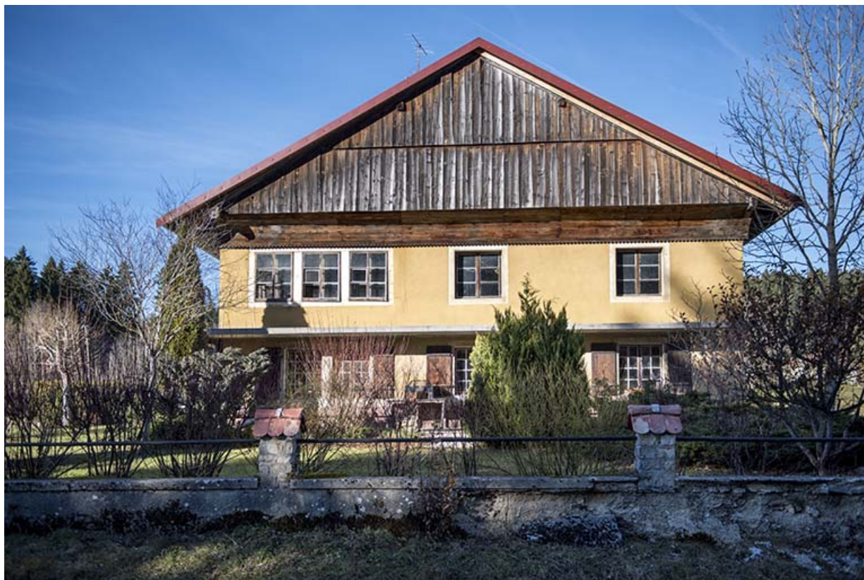
Façade latérale droite.
