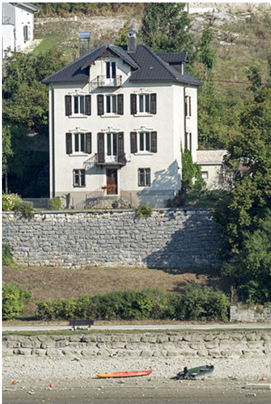
Vue d'ensemble, depuis le sud-est (façade postérieure).
