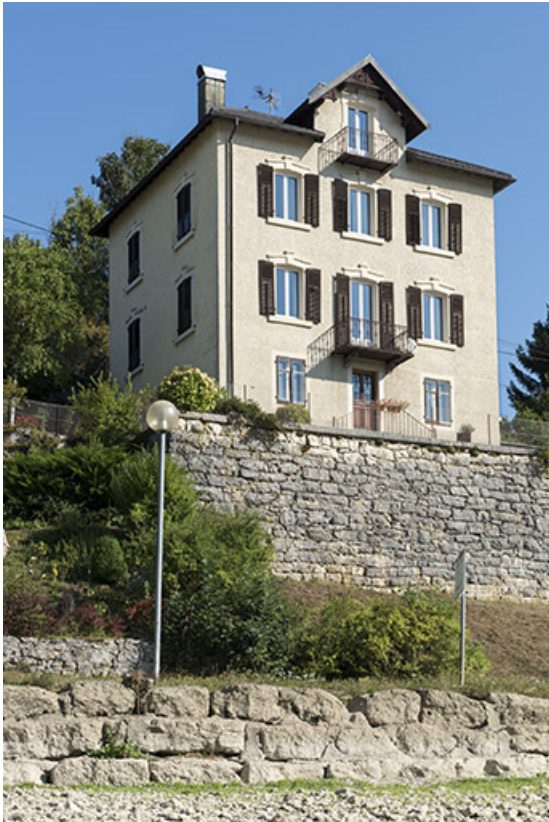
Façades postérieure et latérale droite, vues en contre-plongée.
