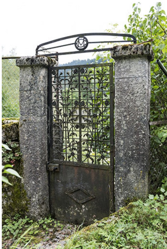
Porte de la clôture, au sud-est.
