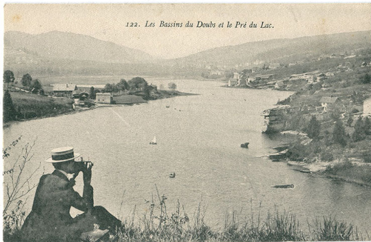
122. Les Bassins du Doubs et le Pré du Lac, 1er quart 20e siècle [entre 1903 et 1913].
