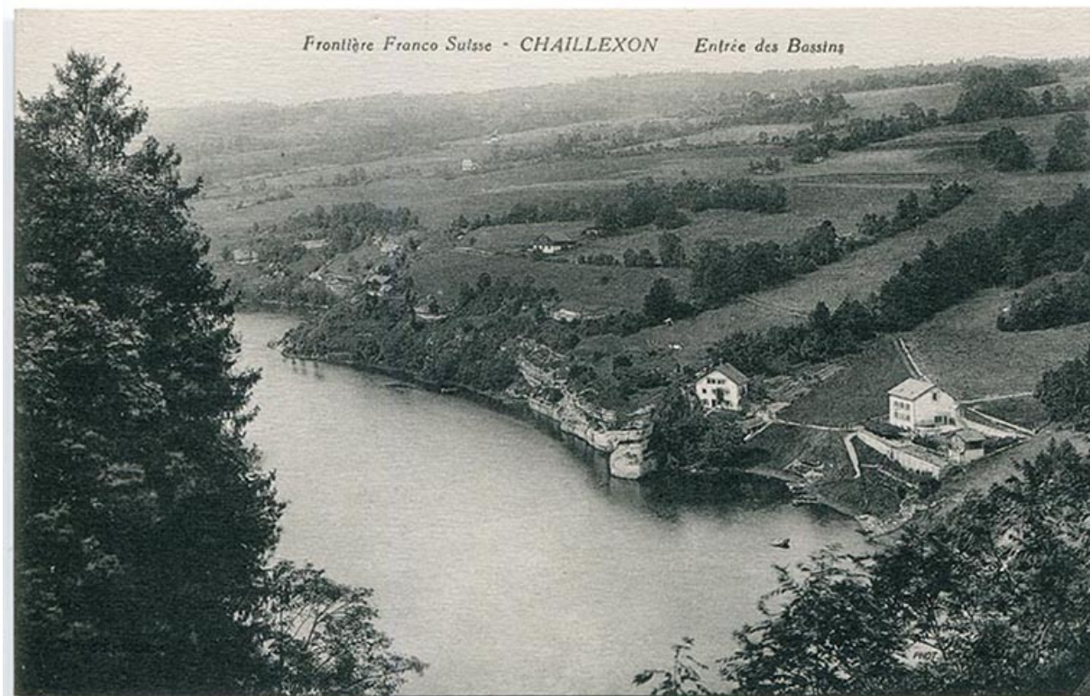
Frontière franco-suisse - Chaillexon. Entrée des bassins, 2e quart 20e siècle.
