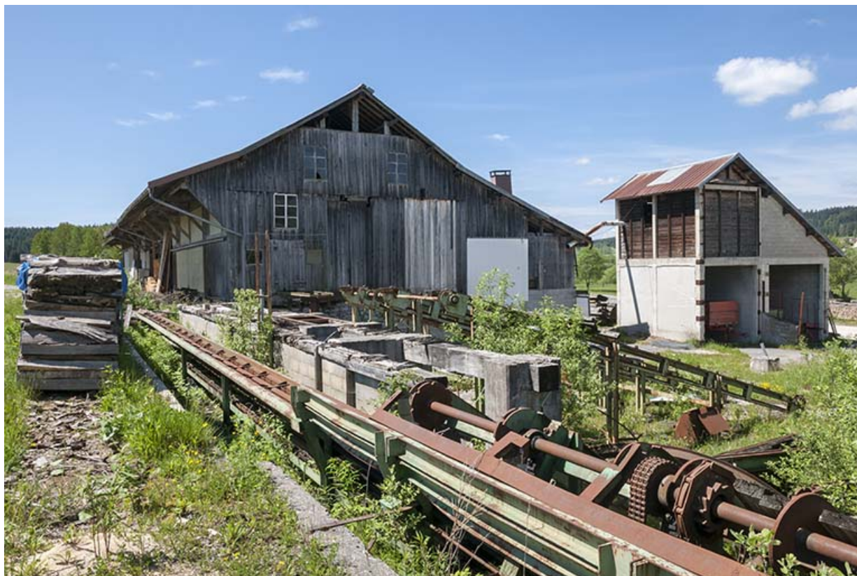
Pignon nord de l'ateier de scierie et sciurier. 25, Vaux-et-Chantegrue, 3 Grande Route
