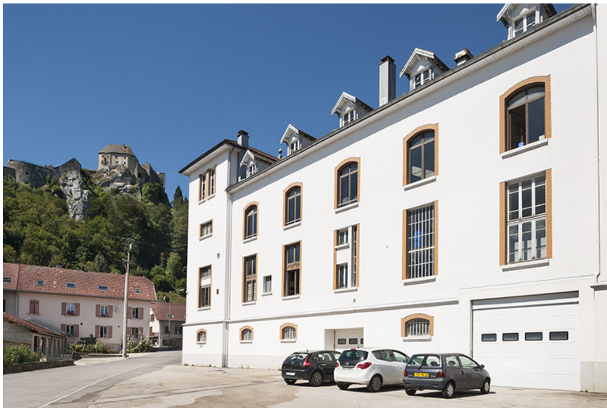
Façade postérieure vue de trois quarts droite.
